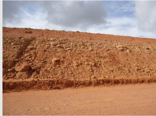
Foto 2- Aterro construído na propriedade da entrevistada.
