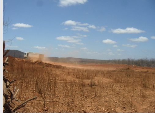
Foto 2- Obra ao lado da residência da ferrovia.
