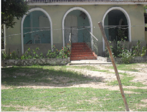
Foto 1 – Residência do proprietário.
