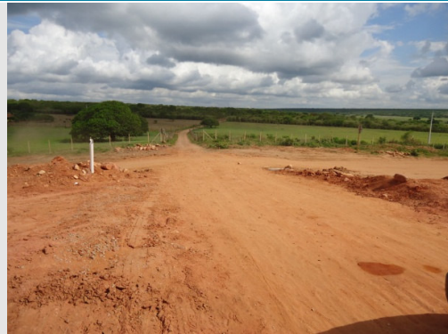
Foto 2- Faixa de domínio.
