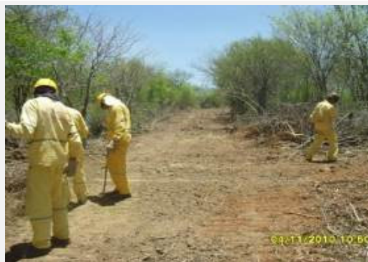
Foto 2 – Construção das cercas de limite.
