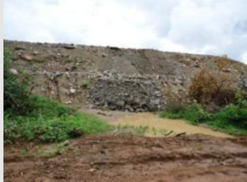
Foto 2 - Propriedade prejudicada com aterro, obstruindo a estrada vicinal.
