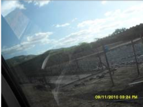
Foto 1 – Construção do bueiro dentro da antiga barragem.
