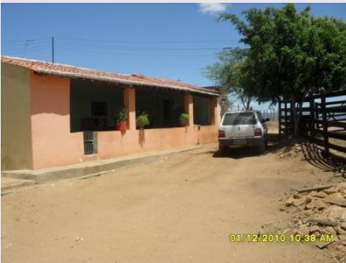
Foto 1 – Vista Geral da sede da fazenda.
