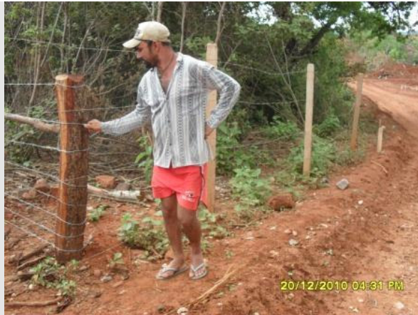
Foto 1 - Proprietário mostrando o encontro de sua cerca com a de limite de quatro fios de arame e danificada.
