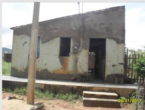
Foto 2 – Residência do Proprietário.
