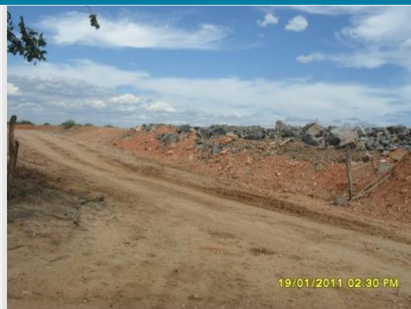
Foto 2 – Colchete aberto com as estacas jogadas ao chão.
