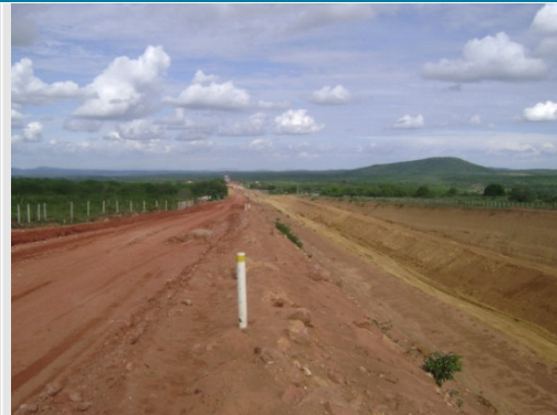
Foto 2- Início das obras.
