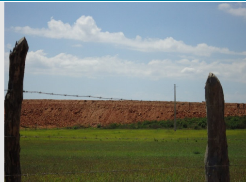
Foto 2- Estrada de acesso interrompida pelo aterro.
