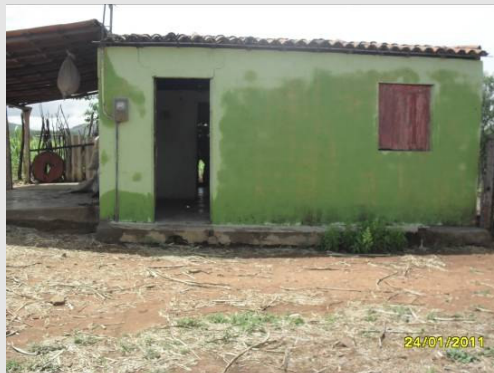
Foto 2 – Casa localizada na propriedade do Proprietário.
