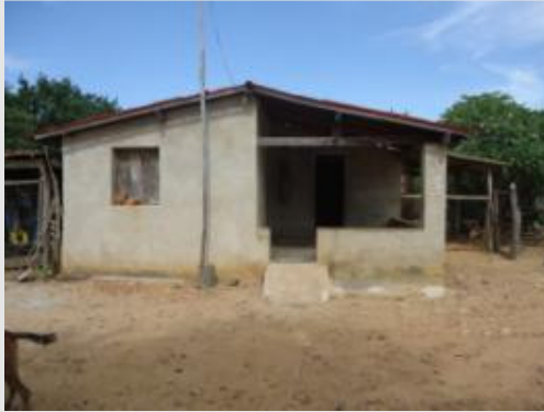
Foto 1 - Vista da residência do proprietário
