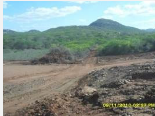
Foto 4 – Cruzamento com a faixa de domínio.
