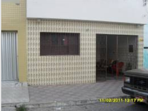
Foto 1 – Residência do proprietário (visão lateral).
