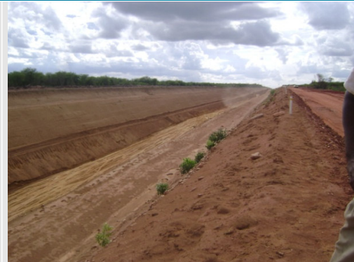
Foto 2 – Área atingida pela obra.
