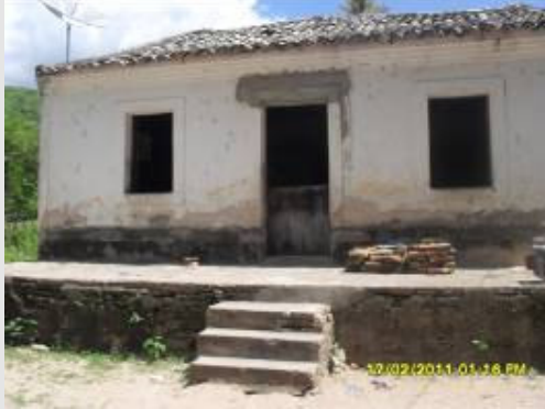
Foto 1 – residência do proprietário.
