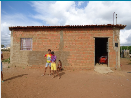
Foto 1 - Residência da família ainda em fase de acabamento.
