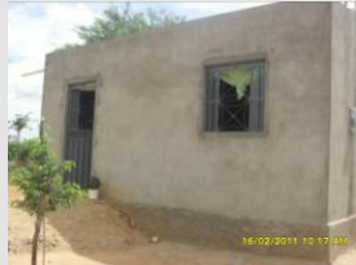
Foto 2 – Residência do Proprietário.
