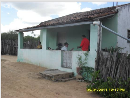
Foto 1 - Residência do expropriado.
