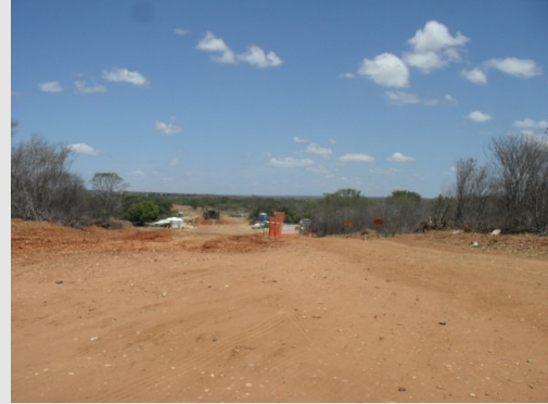
Foto 2- Propriedade atingida pela ferrovia e com obras instaladas.
