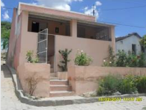
Foto 1 – Residência do proprietário.
