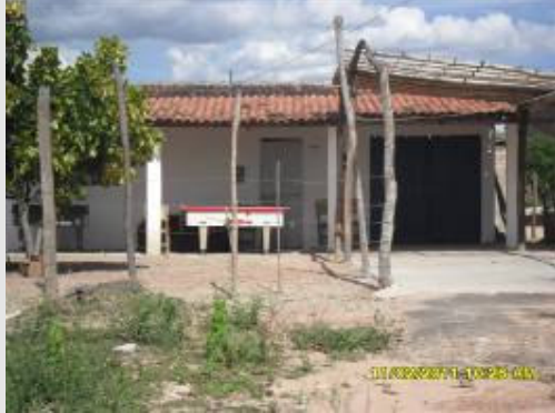
Foto 1 – Residência do proprietário.
