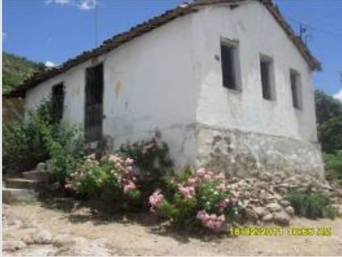
Foto 1 – Residência do proprietário.
