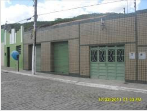
Foto 1 – Residência do proprietário.
