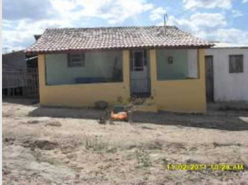
Foto 1 – residência do proprietário.
