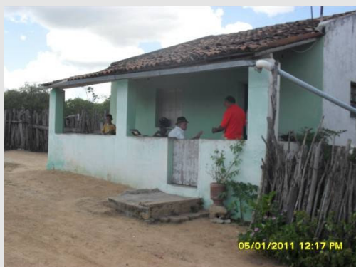
Foto 1 – Residência do expropriado.
