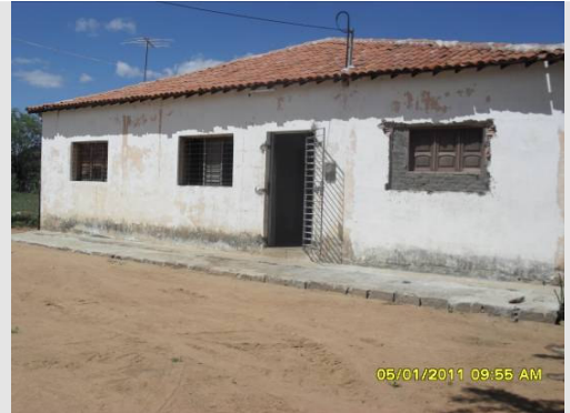
Foto 2 – Casa sede da propriedade.
