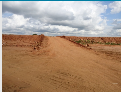
Foto 2- Propriedade cortada pela ferrovia.
