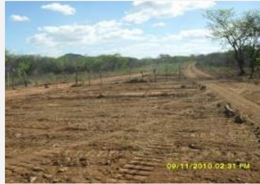
Foto 2 – Ampliação da via de acesso existente.
