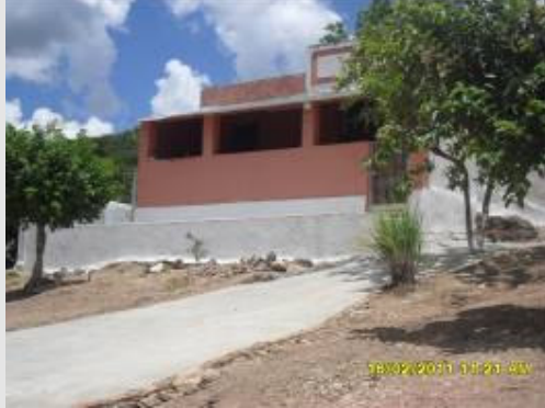
Foto 1 – Residência do proprietário.
