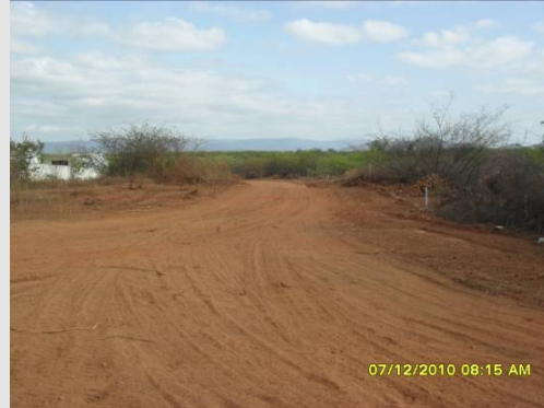
Foto 2 – Estrada citada para acesso das caçambas.
