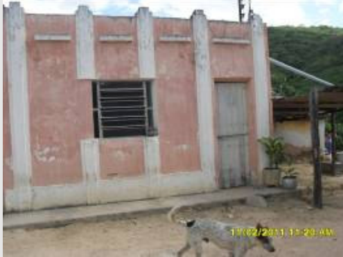
Foto 1 – Residência do proprietário.
