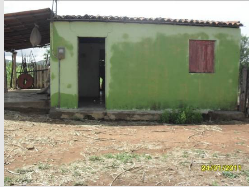
Foto 2 – Casa localizada na propriedade do Proprietário.
