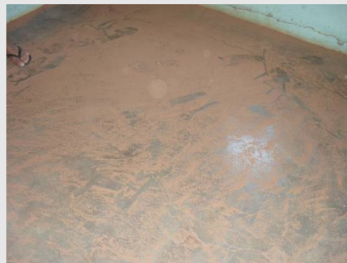
Situação da casa próximo da obra
