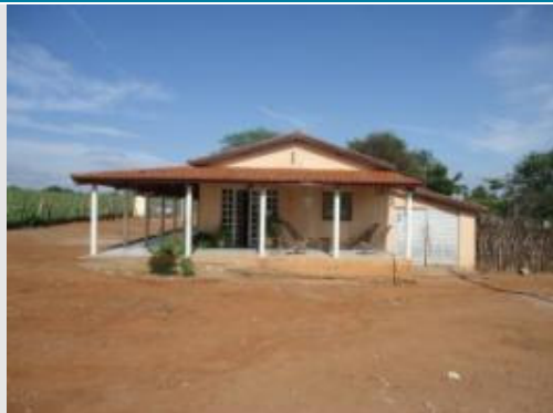
Foto 1 - Vista da residência do proprietário
