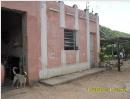
Foto 1 – Residência do proprietário.
