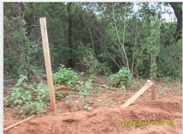
Foto 2 – Cercas inacabadas e estacas já destruídas.
