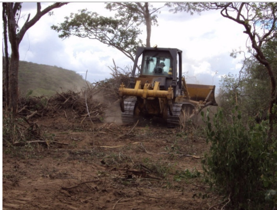
Foto 3 – Supressão de vegetação realizada por trator no Lote 3.
