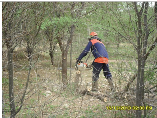
Foto 2 – Supressão de vegetação realizada por motosserra no Lote 2.
