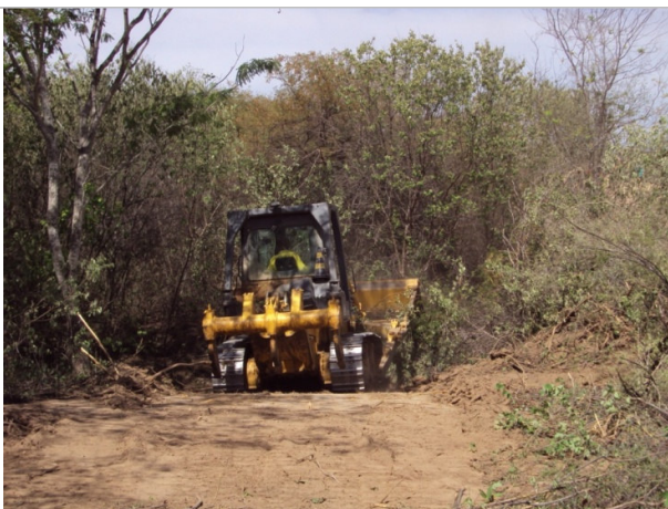
Foto 3 – Supressão de vegetação realizada por trator no Lote 3.
