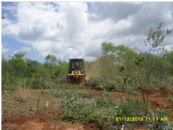
Foto 1 – Supressão de vegetação realizada por trator no Lote 2.
