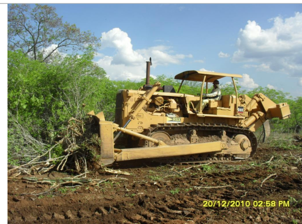
Foto 4 – Supressão de vegetação realizada por trator no Lote 4.
