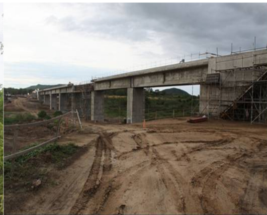
Ponto A2a – Construção de Pontilhão da Ferrovia Transnordestina - Rio Pajeú (Serra Talhada).
