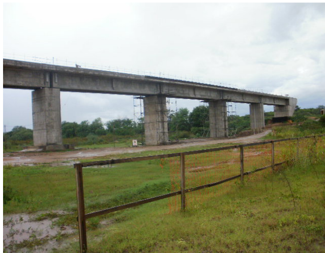
Foto 5.1.1.2-6 – Rio Pajeú (PE 07): colunas de sustentação da linha férrea.
