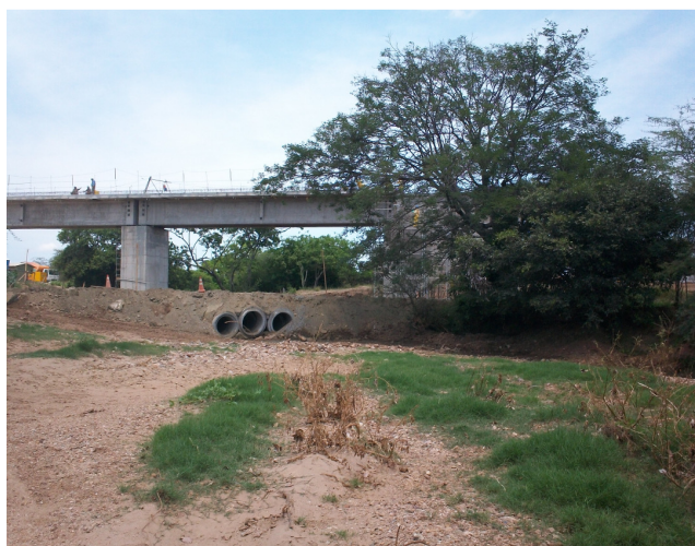
Foto 5.1.1.2-4 – Rio Exu Velho(PE 07AJ): ausência de escoamento superficial a jusante das obras.
