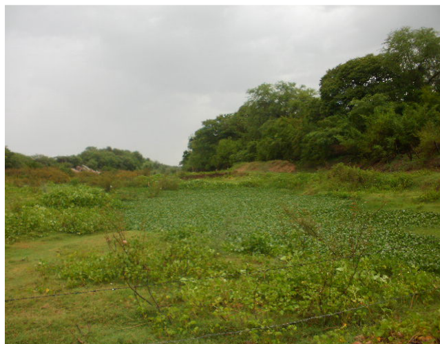
Foto 5.1.1.2-7 – Rio Pajeú (PE 07J): vista geral a jusante das obras, em trecho recoberto por macrófitas aquáticas.
