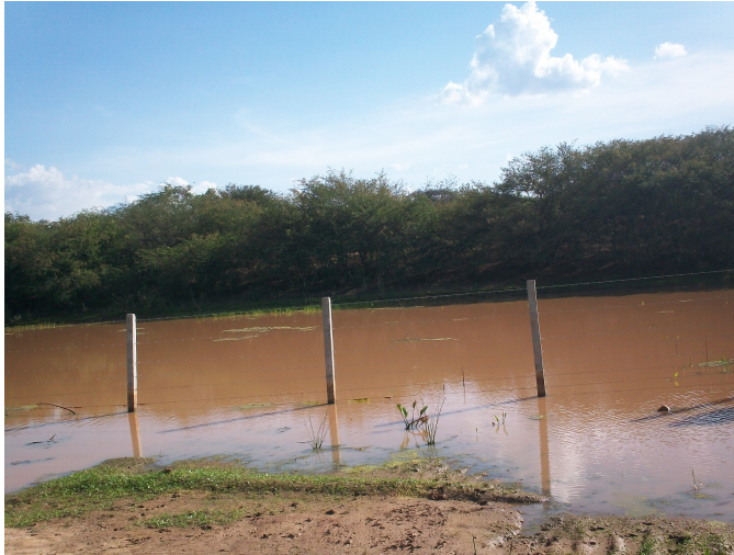
Foto 5.1.3-2. – Barreiro do Sr. Carvalho (PE 23A): vista geral do corpo d'água.
