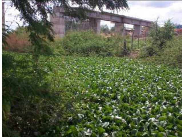
Foto 5.1.2-5 – Rio Pajeú (PE 07): colunas de sustentação para implantação da ponte de cruzamento da linha férrea.
