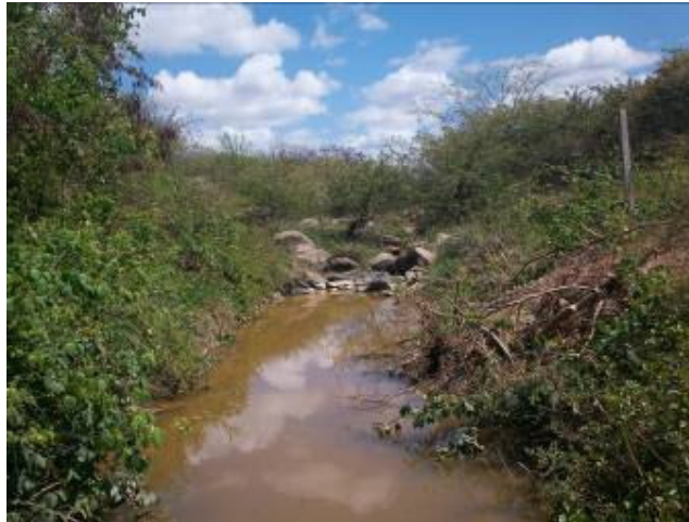
Foto 5.1.3-3 – Riacho Mulungu (PE 13J): vista geral a jusante da frente de obras.
