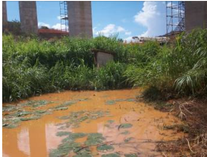
Foto 5.1.1-7 – Riacho Formiga (PE 01AJ): águas com elevado nível de cor, atribuído à movimentação dos solos e à ocorrência de chuvas.
