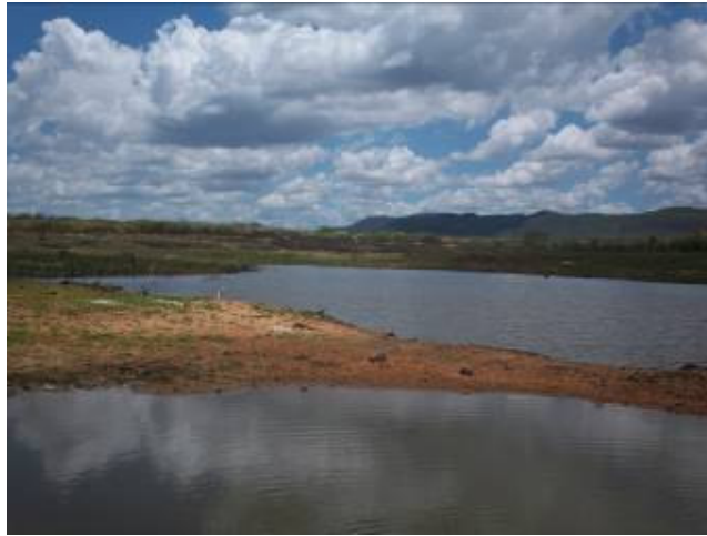
Foto 5.1.2-9 – Açude sem denominação (PE 13A): vista geral do açude
