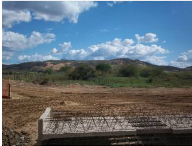
Foto 5.1.2-1 – Riacho Lagamar (PE 10): trecho em obras e sem lâmina d’água.
