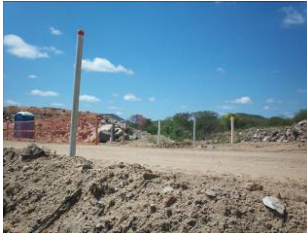
Foto 5.1.3-2 – Riacho Mulungu (PE 13): trecho em obras.
