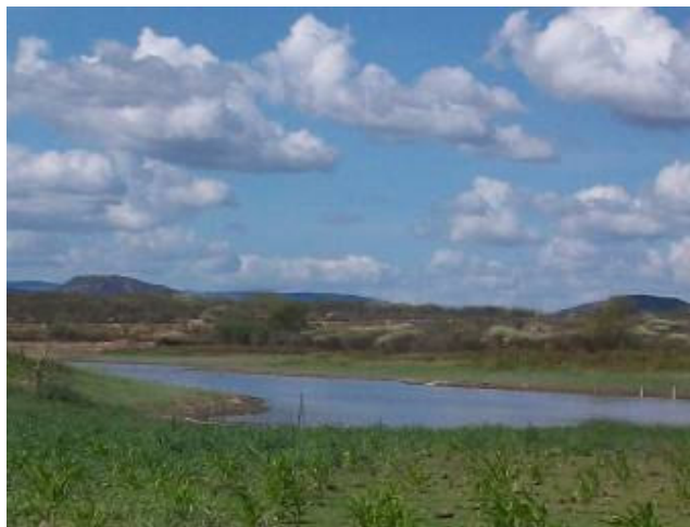
Foto 5.1.2-7 – Açude Varzinha (PE 09J): vista geral do ponto a jusante do eixo ferroviário.
