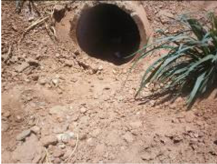
Foto 5.1.1-1 – Riacho Formiga (PE 01AM): ausência de escoamento superficial.
