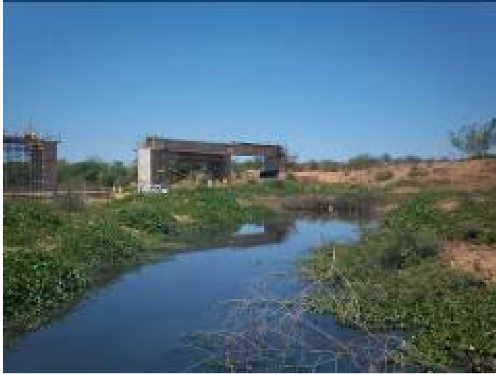
Foto 5.1.2-6 – Rio Pajeú (PE 07J): vista geral a jusante das obras.
