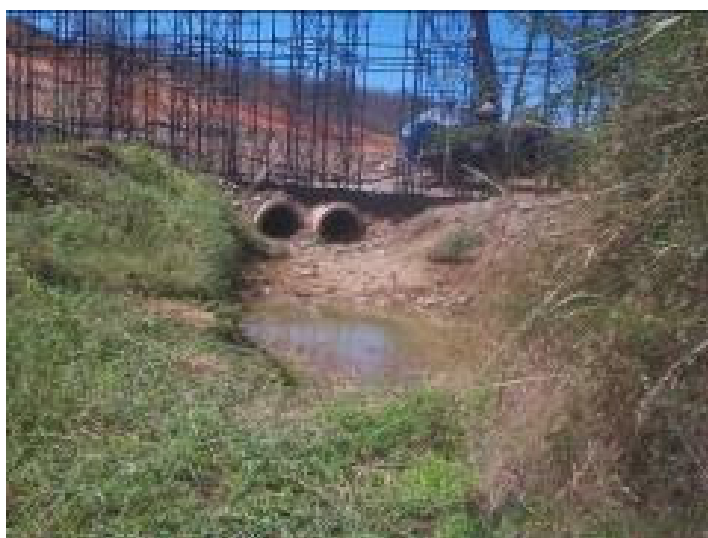
Foto 5.1.1-4 – Riacho dos Milagres (PE 01): trecho sob influência das obras da ferrovia.
