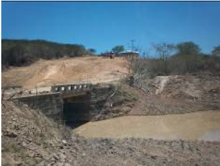
Foto 5.1.3-3 – Riacho do Mel/Pereiras (PE 23J): vista geral do ponto, trecho em obras.
