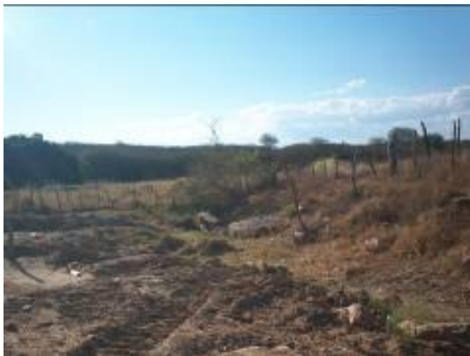
Foto 5.1.2-3 – Riacho Lagamar (PE 10): ausência de escoamento superficial a jusante das obras.
