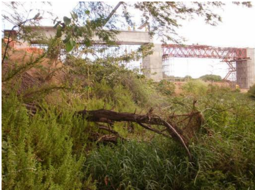
Foto 5.1.2-3 – Rio Pajeú (PE 07): colunas de sustentação para implantação da ponte de cruzamento da linha férrea.
