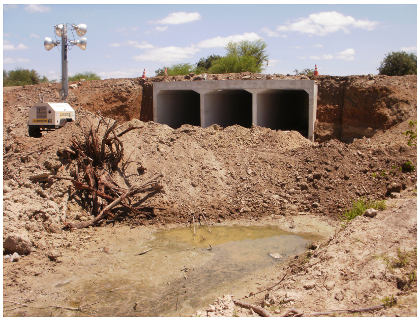
Foto 5.1.3-4 – Riacho Custódia (PE 15J): trecho em obras.
