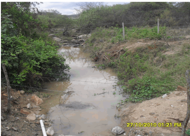
Foto 3 : 26/10/2010 Visão de Jusante para Montante (Eixo Ferroviário - BR 232)
