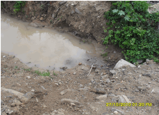
Foto 1 : 26/10/2010 Bueiro instalado. Visão do escoamento (Montante)
