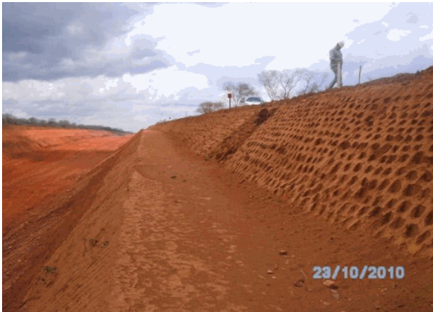
Foto 1 : 25/10/2010 Berma de corte com talude sendo preparado para plantio
