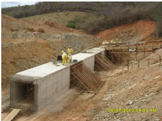
Foto 3-7 Bueiro em construção, Lote 1.
