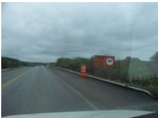
Foto 4-13 Sinalização preventiva nas rodovias que ligam os Lotes em obras
