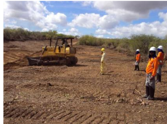
Foto 4-142 A equipe de afugentamento acompanha todo o trabalho de supressão e orienta os operadores de máquinas, evitando atropelamento de animais.
