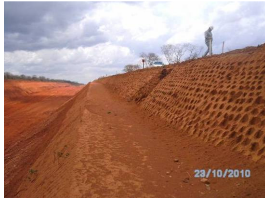
Foto 4-105 – Covas em corte recebendo preparação para plantio (Estaca 11564)
