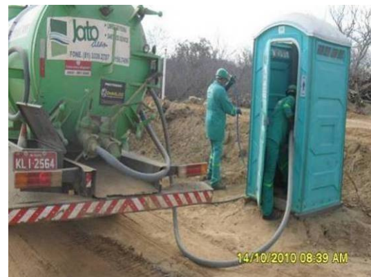
Foto 4-76 Limpeza dos banheiros químicos.
