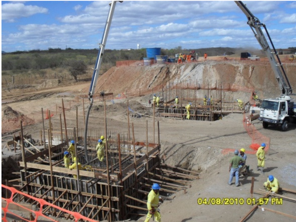
Foto 3-19 – Ponte sobre o Riacho Lagamar
