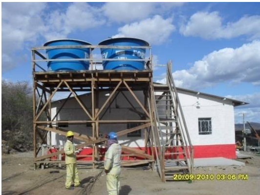
Foto 4-57 Rede de distribuição de água no canteiro avançado.
