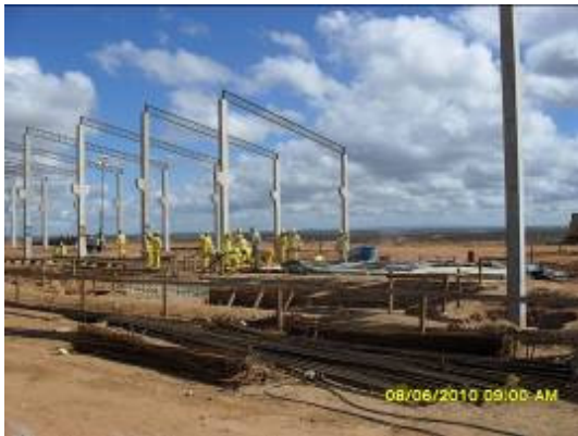
Foto 4-25 Canteiro principal: fábrica de dormentes para os trilhos.
