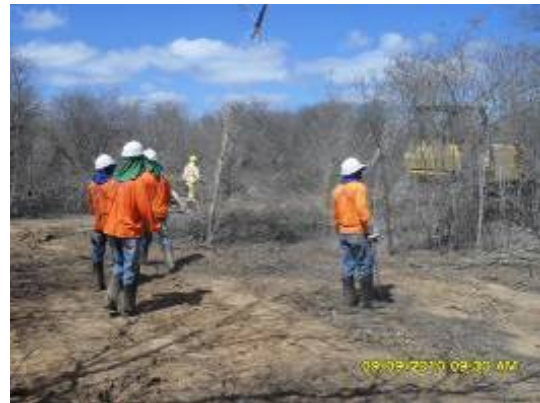
Foto 4-109 Equipe da fauna inspeciona as áreas que serão suprimidas nos lotes em obras.
