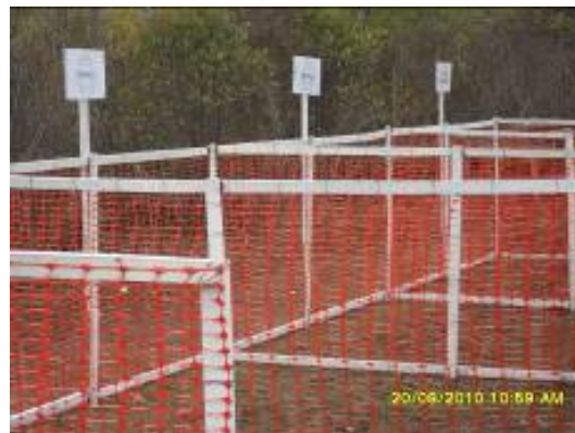
Foto 4-50 Baias para a coleta seletiva são instaladas nos canteiros.
