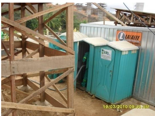
Foto 4-47 Banheiros químicos atendem todos os Lotes em obras.
