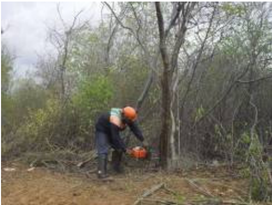
Foto 4-3 Supressão de indivíduos com diâmetro superior a 15 cm é realizada com auxílio de motosserras.
