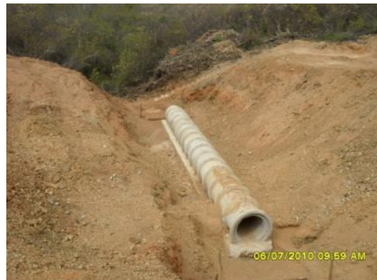
Foto 3-8 Bueiros tubulares serão instalados naqueles Lotes previstos em projeto.
