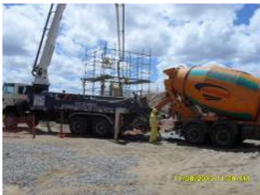
Foto 3-20 Ponte em construção na estaca 30015.
