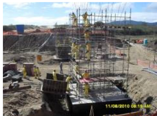
Foto 3-21 Vista da construção da ponte estaca 30015.
