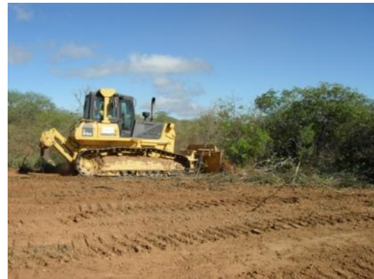
Foto 3-4 Limpeza da faixa de domínio, para implantação da ferrovia, nos lotes em obras.
