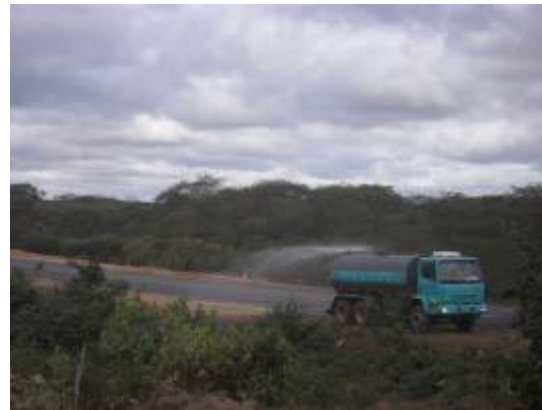
Foto 4-70 Umectação das vias de acesso.
