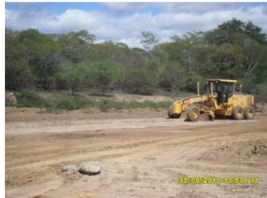
Foto 4-8 Procedimento de terraplanagem, ocorre em todos os Lotes em obras.
