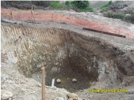
Foto 3-15 Estaca 30.522, onde será implantada uma obra de arte especial.
