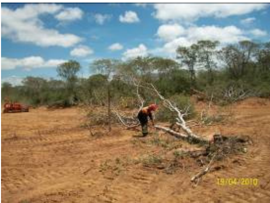
Foto 4-5 O desdobraamento do material suprimido ocorrem nos Lotes em obras.
