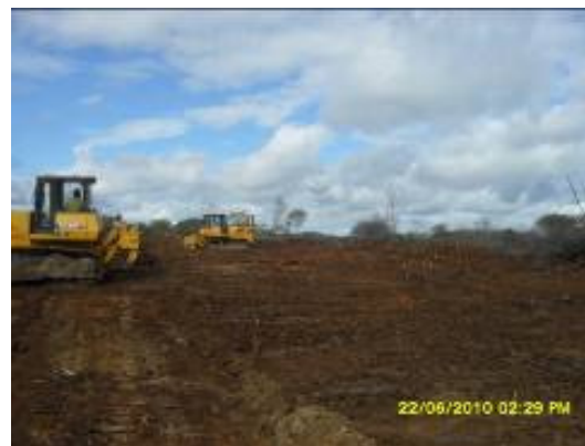
Foto 3-23 Supressão próximo a estaca 40.538.
