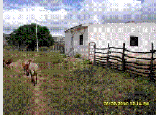
Foto 4-180 – Sede localizada próximo à faixa de domínio, Lote 02, 06/07/2010.
