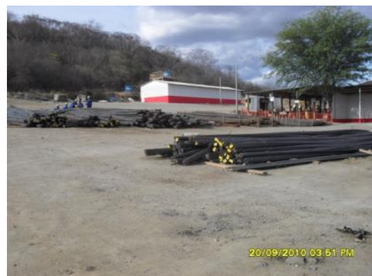
Foto 4-42 Pátios de estocagem de ferragens, do canteiro avançado de Custódia-PE.
