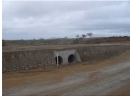
Foto 4-22 Bueiro concluído e com terraplanagem executada.
