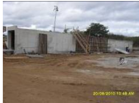
Foto 3-27 Bueiro da estaca 40.283, BSCC 3,0 X 3,0 m.
