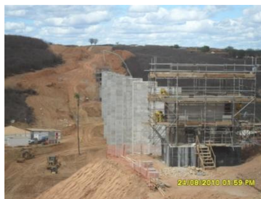
Foto 3-12 Ponte em construção.
