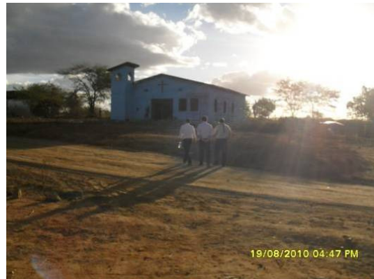
Foto 4-168 - Nova Capela concluída Sítio Carvalho, Custódia/PE, 19/08/2010.
