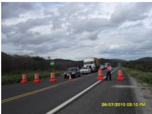
Foto 4-19 Sinalização na rodovia, em virtude de detonações em rocha.
