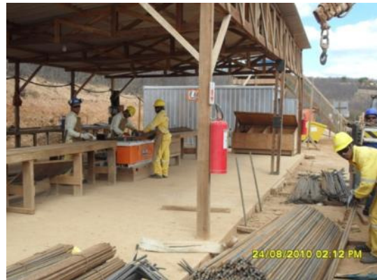
Foto 4-32 Central de armação do canteiro provisório, Lote 1.
