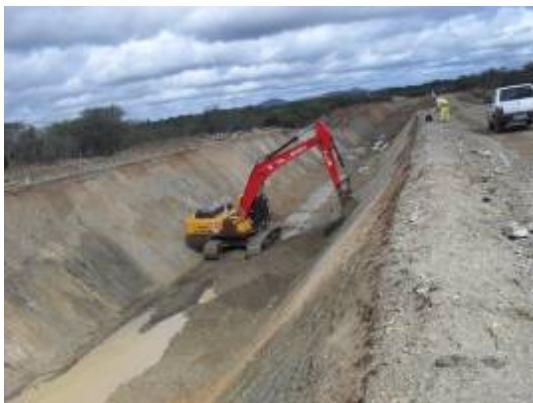
Foto 4-9 Escavações com retaludamento, no corte.
