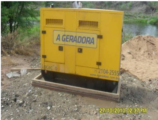
Foto 4-85 – São Instaladas caixas de contenção em maquinário estacionário para evitar contaminação do solo.
