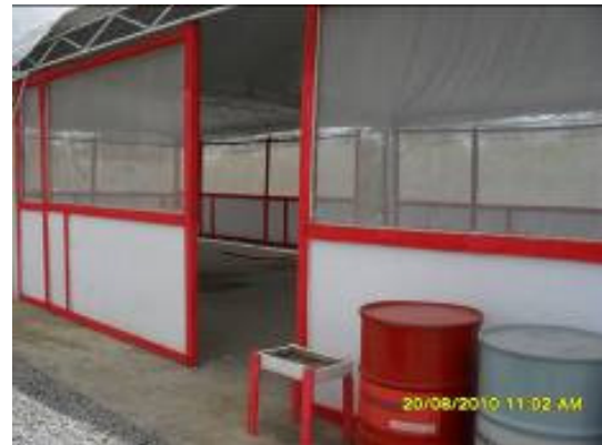
Foto 4-58 Refeitório em fase final de construção.
