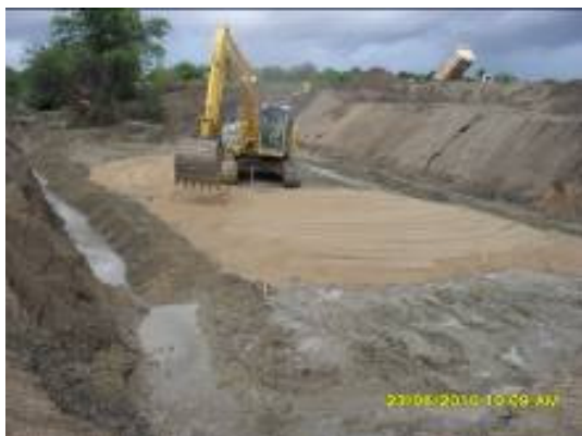
Foto 3-24 Estaca 40.057, onde será implantada uma obra de arte corrente.
