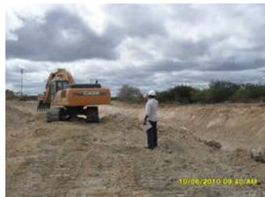
Foto 4-74 Inspeções realizadas periodicamente.
