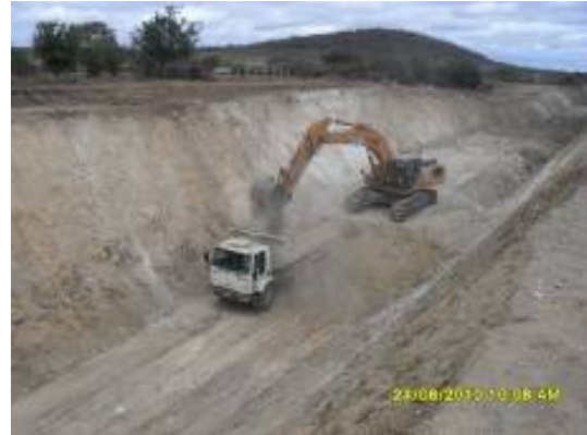
Foto 3-16 Trecho de corte no lote 3, próximo a estaca 32.600.
