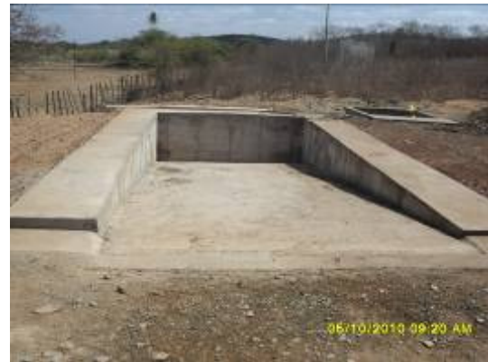
Foto 4-86 - As áreas de lavagem do maquinário são impermeabilizadas visando a não contaminação do solo.
