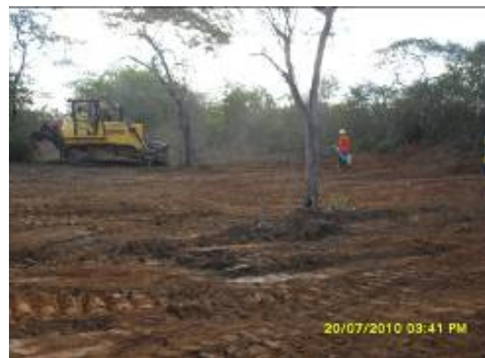
Foto 4-111 Verifica-se o diâmetro de algumas árvores antes da entrada das máquinas, para posterior corte com motosserra
