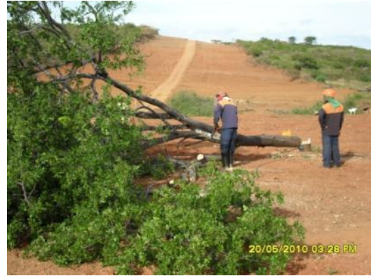
Foto 3-2 Desgalhamento e desdobramento do material suprimido, ocorre em todos lotes.
