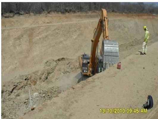
Foto 4-103 Lotes em fase inicial de implantação do empreendimento.
