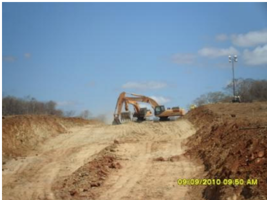
Foto 4-7 Escavações na área do traçado da implantação do empreendimento.
