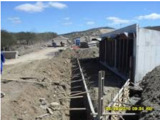
Foto 3-17 - Bueiro da estaca 32.500, BTCC 3,0 X 3,0 m.
