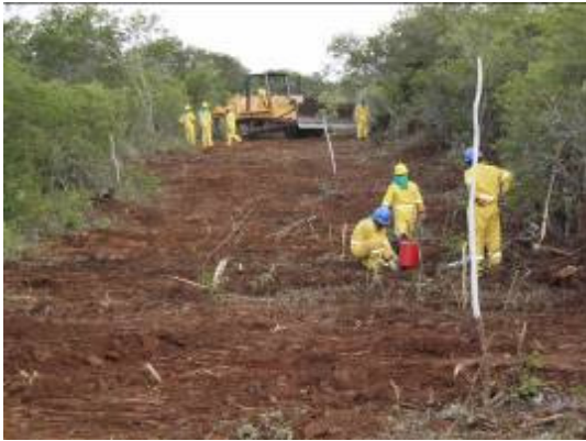
Foto 4-1 - Início da supressão do Trecho SPS, Lote 2.
