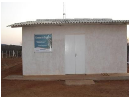
Foto 4-131 Vista externa do Centro de Triagem.
