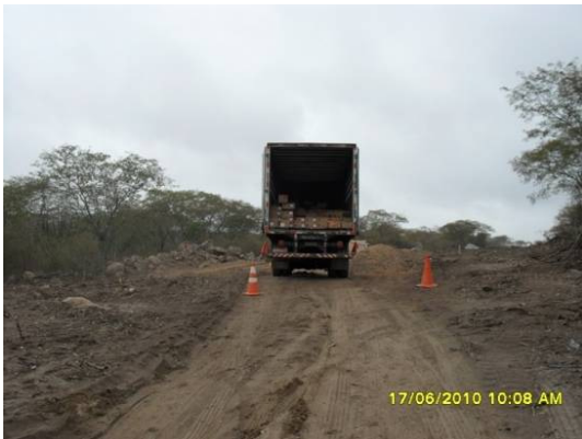
Foto 4-67 Caminhão conduzindo explosivos pelos Lotes que necessitem de escavações em rocha.
