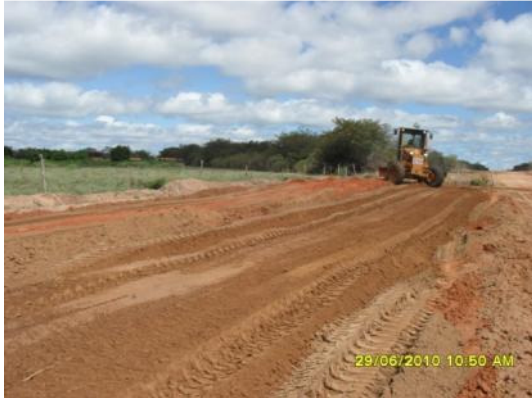
Foto 3-5 Início dos procedimentos de terraplanagem nos Lotes mobilizados.
