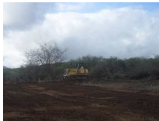
Foto 3-14 Supressão próximo a estaca 31.986.
