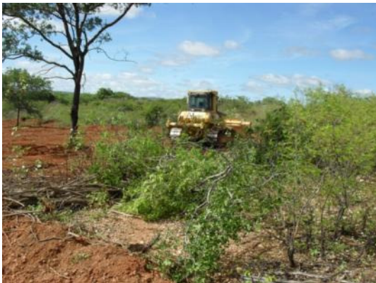
Foto 3-3 Limpeza da vegetação de diâmetro inferior a 15 cm é realizada pelo trator de esteira.
