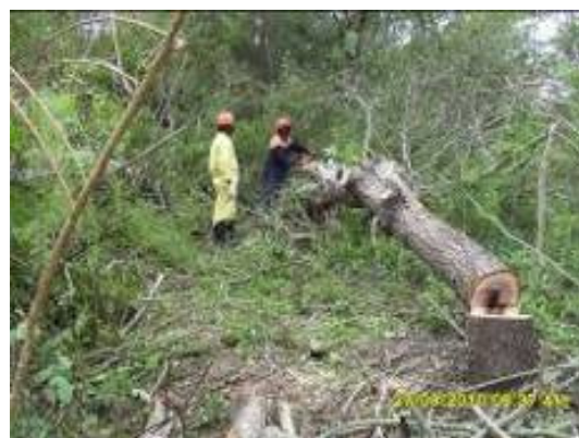
Foto 3-29 Supressão próximo a estaca 50.726.
