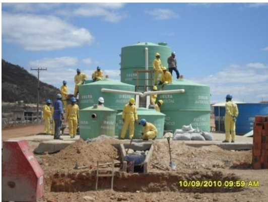
Foto 4-53 Estação de Tratamento de Água do canteiro principal, em construção.
