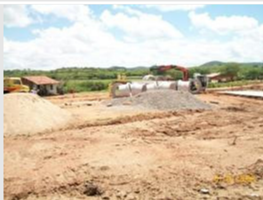
Foto 4-172 - Visão da construção de bueiro e localização da casa, Lote 3, 15/04/2010.
