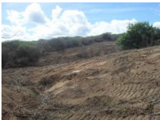
Foto 3-13 Supressão próximo a estaca 33.020.
