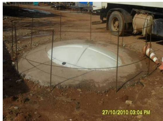
Foto 4-84 Construção fossas sépticas para a demanda de efluentes sanitários.
