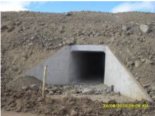
Foto 4-23 Bueiros concluídos em todos os Lotes.
