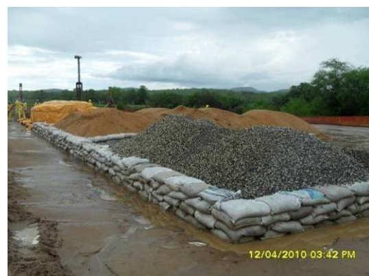
Foto 4-78 Baias de contenção de resíduos presentes nas frentes de serviços.
