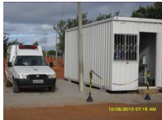
Foto 4-28 Ambulatório provisório para atender a implantação do canteiro principal.
