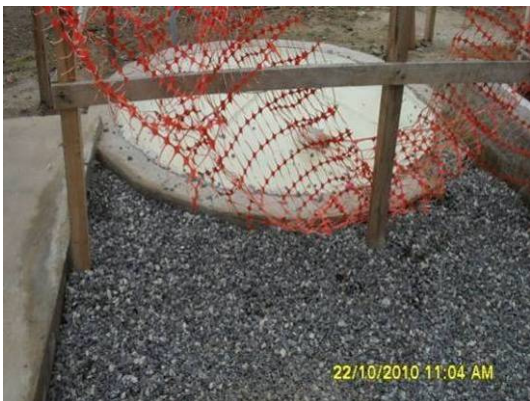
Foto 4-83 Fossas sépticas implantadas nos canteiros de obras.
