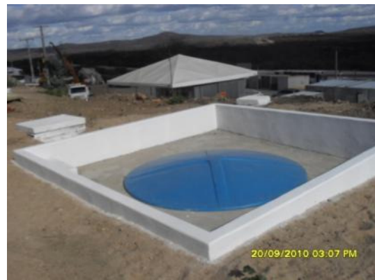
Foto 4-40 Fossa séptica instalada para atender o canteiro avançado de Custódia-PE.
