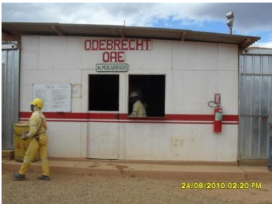
Foto 4-35 Almoxarifado do canteiro provisório, Lote 1.
