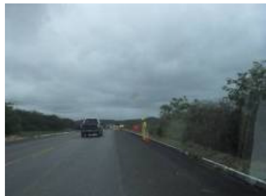
Foto 4-14 Colaborador executando a sinalização preventiva.
