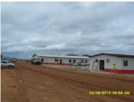
Foto 4-27 Instalação dos escritórios e alojamentos, do canteiro principal (administrativo).
