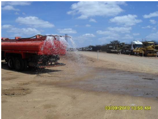
Foto 4-71 Caminhão pipa promovendo umectação próxima do canteiro avançado
