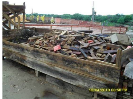
Foto 4-80 Área de Armazenamento de Madeira em ponto de apoio.
