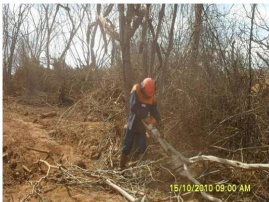
Foto 4-110 Supressão realizada com auxílio de motosserra.
