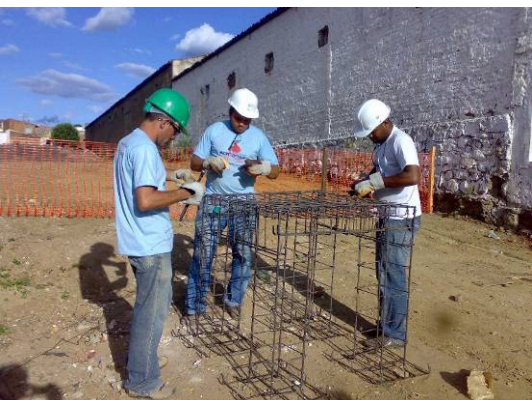
Foto 4-97 Capacitação de Trabalhadores Locais na construção de armações metálicas
