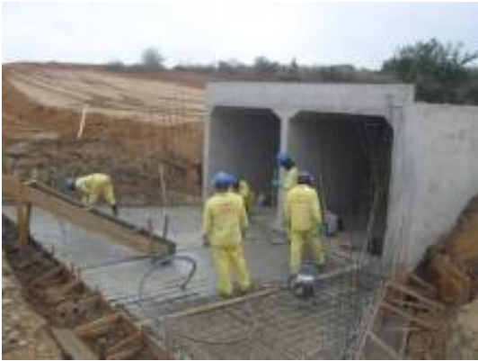
Foto 4-21 Bueiros em construção em todos os Lotes mobilizados, conforme projeto.
