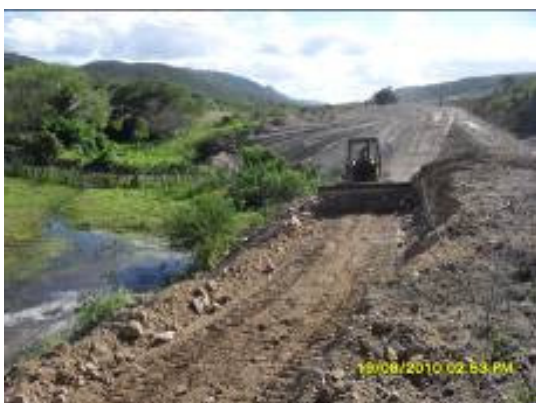
Foto 3-28 Supressão próximo a estaca 50. 608.
