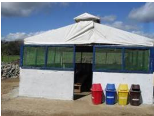
Foto 4-59 Refeitório dos canteiros provisórios.
