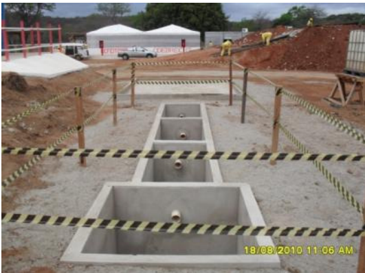
Foto 4-29 Lavador com caixa separadora de água e óleo em construção no canteiro principal.
