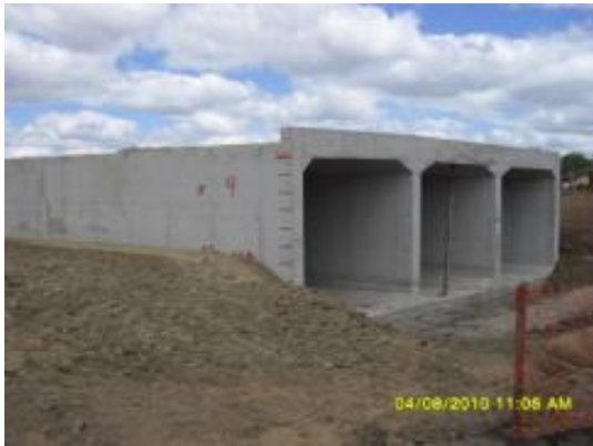
Foto 3-26 - Bueiro da estaca 40.049, BTCC 3,0 X 3,0 m.
