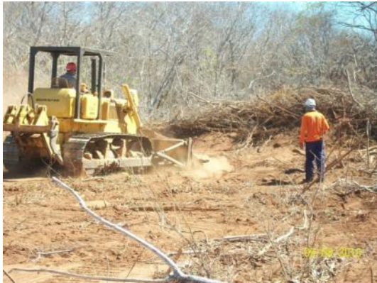
Foto 4-112 Raspagem da camada superficial do solo ocorre em todos os lotes.
