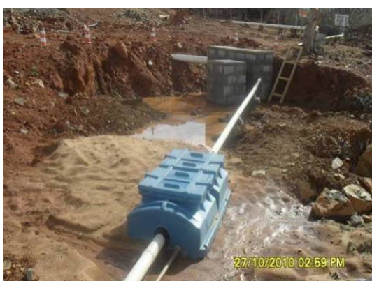
Foto 4-77 Implantação de dispositivo separador de água e óleo
