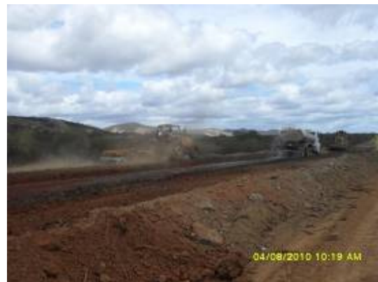
Foto 4-10 Aterro para implantação da ferrovia.
