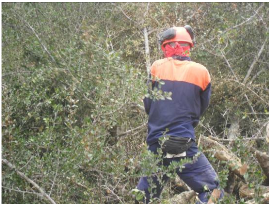
Foto 4-114 Desgalhamento e desdobramento do material lenhoso para enleiramento.
