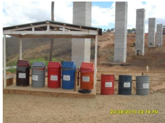
Foto 4-36 Coleta seletiva no canteiro provisório, Lote 1.
