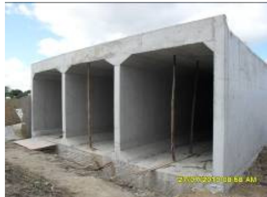
Foto 4-24 Bueiro em fase final de conclusão, Lote 4.
