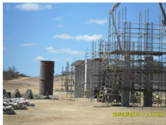
Foto 3-10 Ponte em construção. No Lote 01
