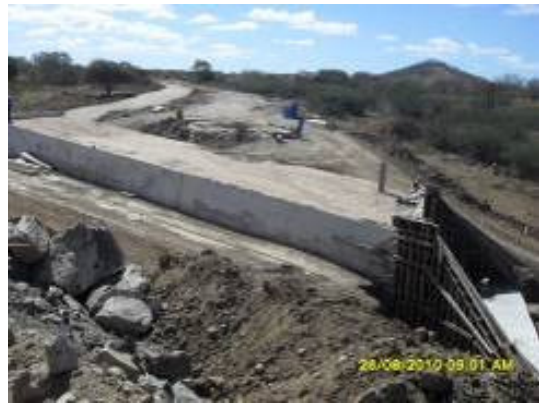
Foto 3-18 Bueiro da estaca 32.550, BDCC 3,0 X 3,0 m.
