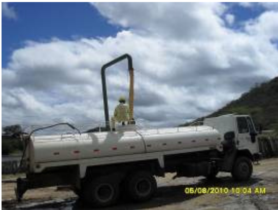
Foto 4-69 Abastecimento do caminhão pipa que realiza a umectação das vias de acessos e obras.
