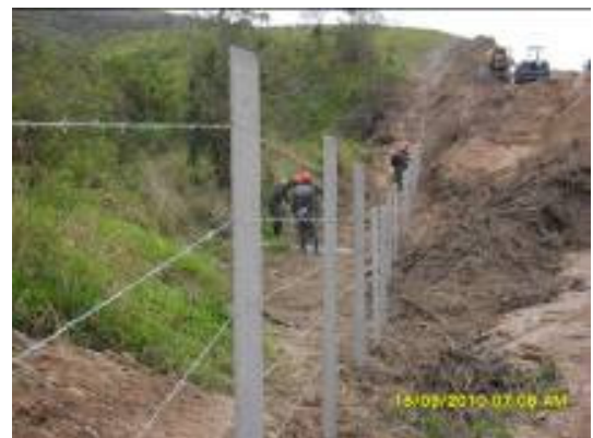
Foto 4-117 Simultaneamente a supressão da faixa de domínio nos lotes em obras, ocorre o cercamento da mesma.
