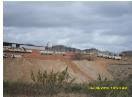
Foto 4-26 Vista geral da implantação do canteiro principal (industrial).
