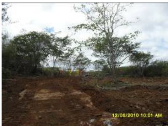
Foto 3-22 Supressão próximo a estaca 40.000.
