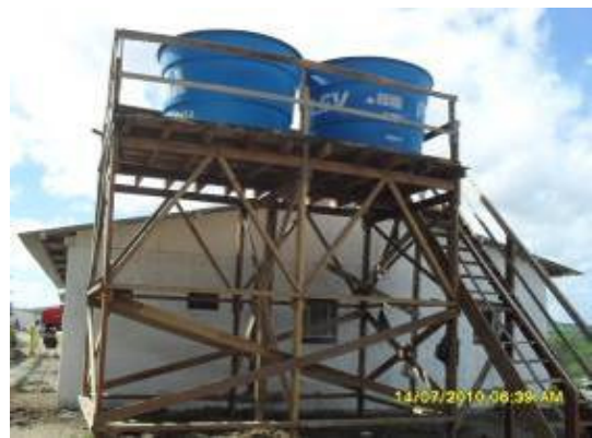
Foto 4-62 Redes de distribuição de água são instaladas onde necessárias.
