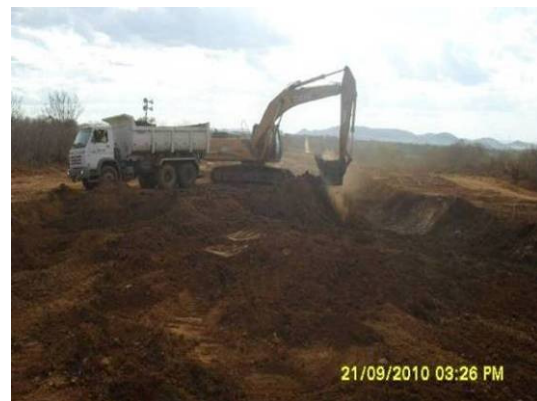
Foto 4-104 Escavações ao longo do eixo da ferrovia ainda são realizadas.
