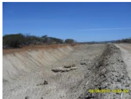
Foto 3-25 Trecho de corte no lote 4, próximo a estaca 40.183.
