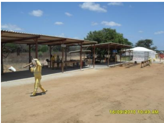
Foto 4-33 Carpintaria no canteiro provisório, Lote 1.
