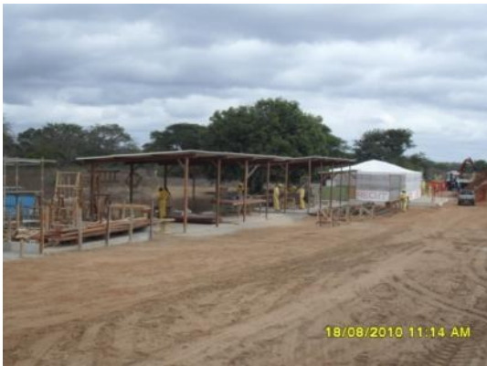
Foto 4-31 Canteiro provisório, Lote 1.
