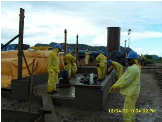
Foto 4-79 Construção de Pátios para Armazenamento de Aditivos.
