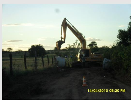
**Foto 2** – Máquina colocando manilha numa parte da estrada de acesso a sede da fazenda, que foi danificada.
