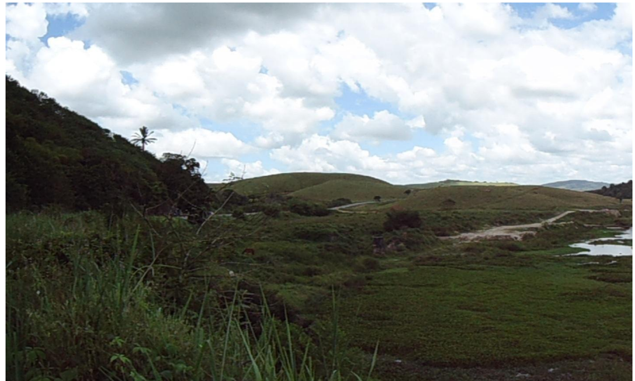
Barramento rudimentar criado para abastecimento humano
