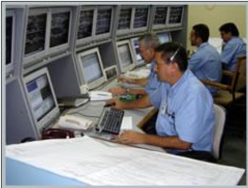
Foto 3.2-1 - Centro de Controle Operacional.
