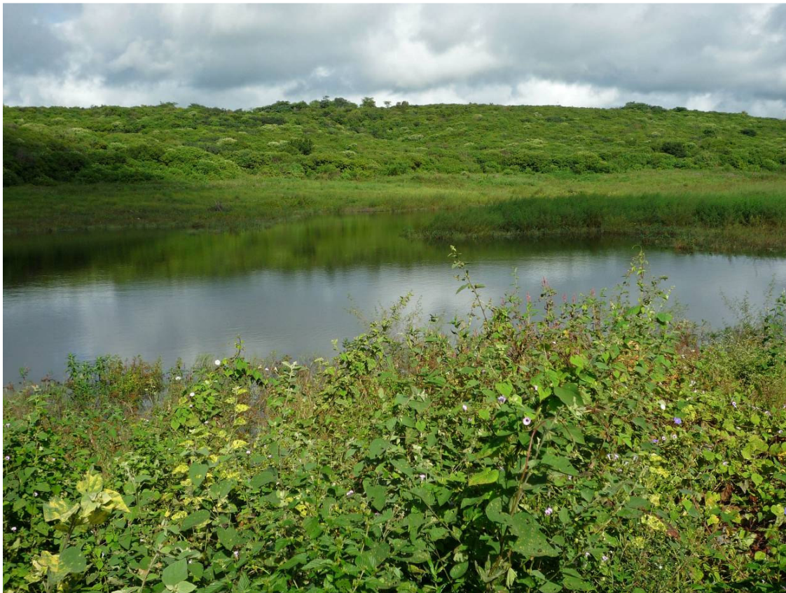
Figura 8. Açude drenado da fazenda Bálamo, no município de Jati.
