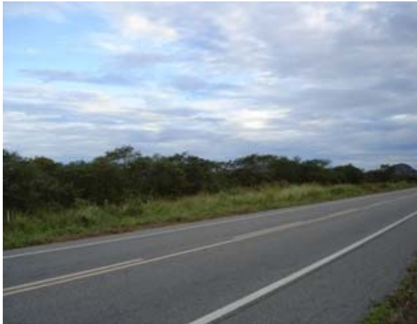
Foto 4.3-7 - BR-122 no município de Quixadá, dentro da AID. Essa rodovia será atravessada pelo empreendimento.
