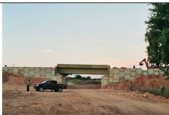
Foto 28_0281 (pto. 66): vista de passagem do trecho da ferrovia da CFN em construção, sobre a estrada para missão Velha.
