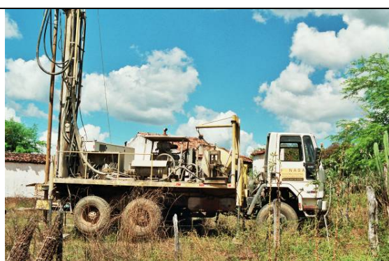
Foto 4_0260 (pto. 58): caminhão da FUNASA com equipamento de perfuração de poço para captação de água subterrânea ao lado do traçado da ferrovia.
