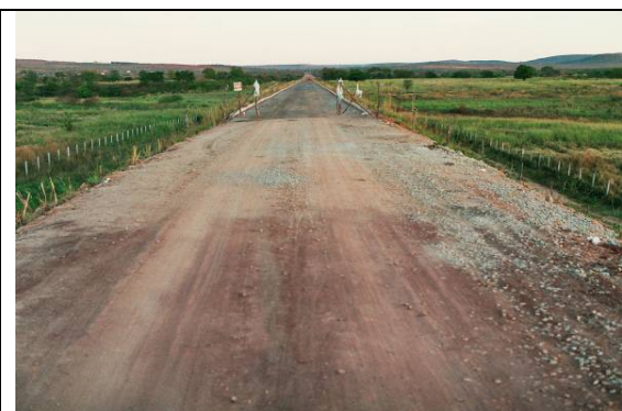
Foto 27_0280 (pto. 66): vista da plataforma da ferrovia da CFN já construída, em direção a Missão Velha.
