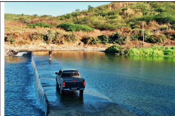
Foto 17_0271 (pto. 63): açude no rio Salgado, ainda vertendo água após período chuvoso.
