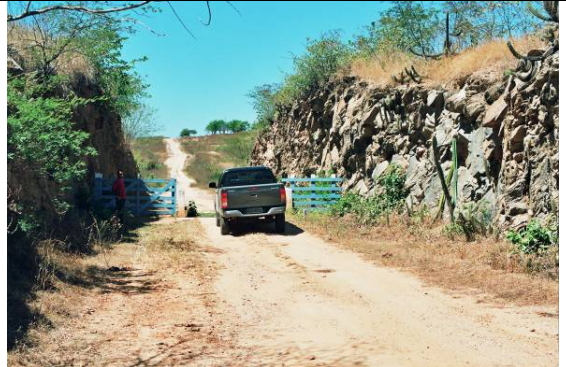
Foto 27_0175 (pto. 44): corte de antiga estrada de ferro desativada, a cerca de 700 m do traçado em análise, que passa junto às árvores no horizonte, ao fundo; predominam gnaisses do Complexo Cruzeta, com injeções de granito fino (v. foto seguinte).
