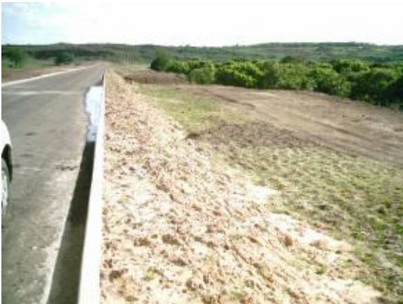
Foto 6.1.2.2-3 – Reinício da revegetação dos taludes de aterro
