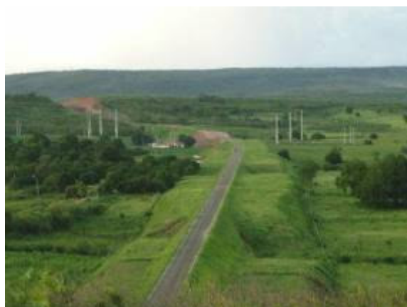
Foto 5.1.8-1 – Revegetação de talude de aterro e lateral da faixa de domínio
