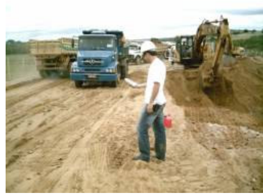
Foto 6.1.5.2-2 – Medição de ruído no canteiro de obras
