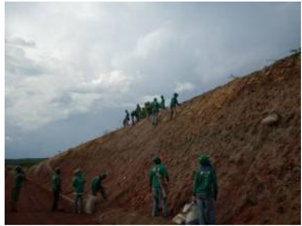
Foto 6.1.2.2-4 – Preparo de parede de talude de corte para revegetação.
