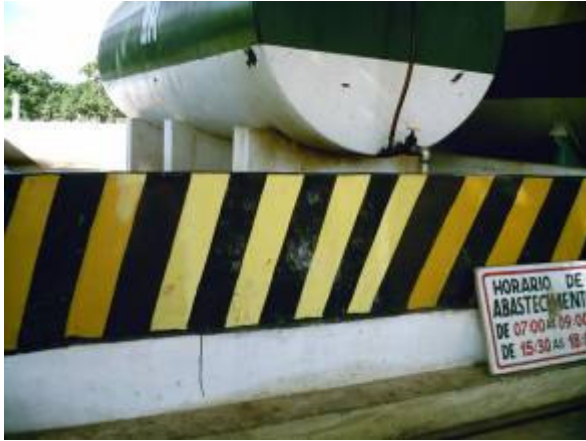
Foto 6.1.2.2-1 – Fechamento da abertura na parede do tanque de contenção de depósito de combustível.
