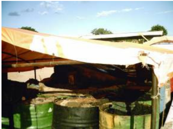
Foto 6.1.2.2-6 – Solo contaminado acondicionado em tambores dentro de baía cimentada na SUPEQ.
