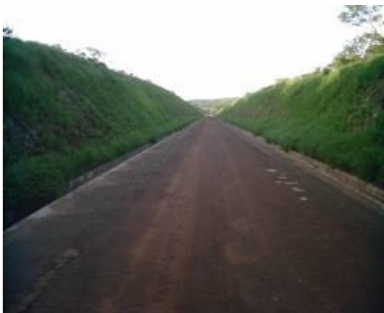
Foto 6.1.8.2-1 – Revegetação de Taludes
