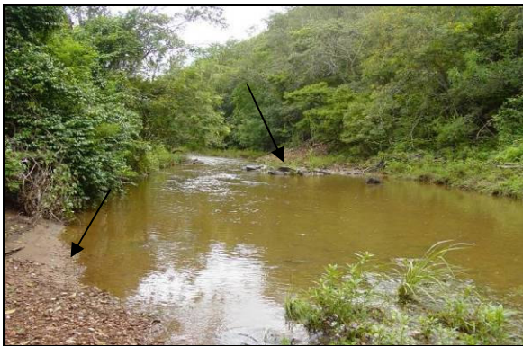
Foto 23 - Vista do riacho Jardim a montante do local de coleta (EST6), situado no ponto onde está sendo instalada a ponte sob a Ferrovia Transnordestina. As setas indicam os locais com queda de barranco nas margens esquerda e direita.
