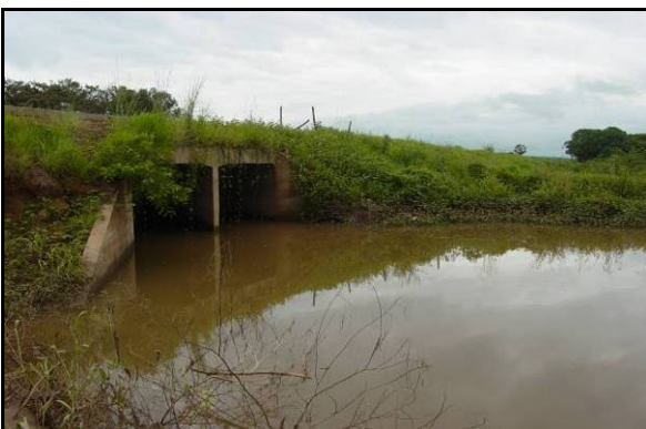
Foto 11 - Vista do riacho Olho d'Água a montante do bueiro sob a Ferrovia Transnordestina, no local da estação EST1.
