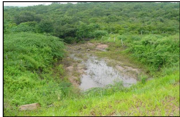
Foto 16 – Vista de tributário do riacho Olho d'Água a jusante do bueiro sob a Ferrovia Transnordestina, no local da estação EST2.
