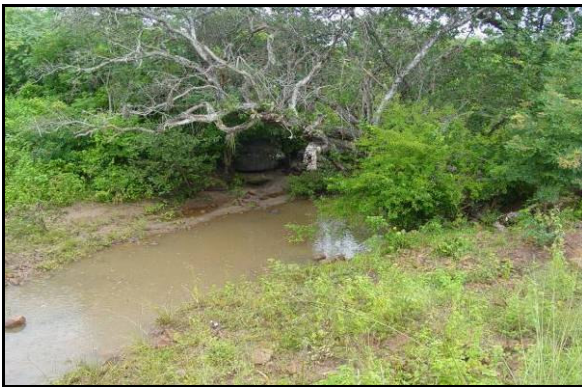
Foto 15 – Vista de tributário do riacho Olho d'Água a montante do bueiro sob a Ferrovia Transnordestina, no local da estação EST2.
