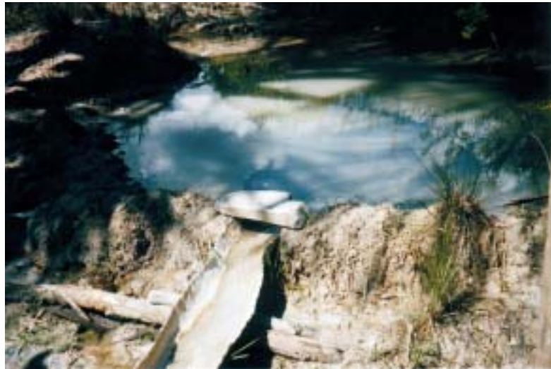
Sistema de captação de água de nascente Km 147,5
