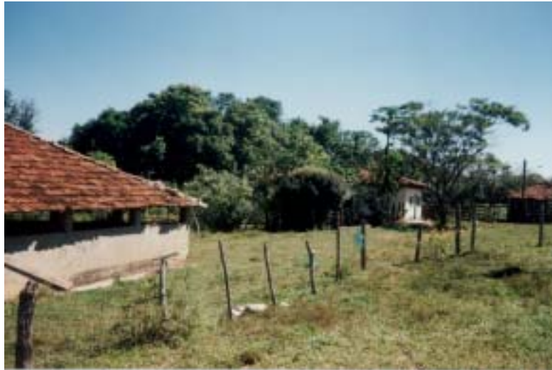
Benfeitorias existentes na propriedade situada no Km 72,5.
