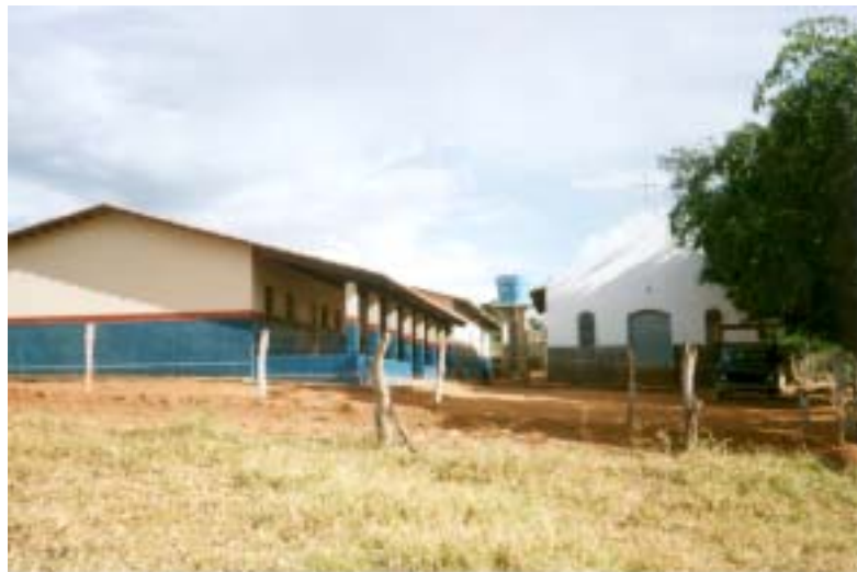
Escola e Igreja afetadas no Km 93.
