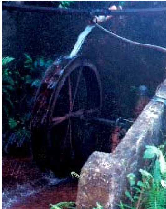
Roda de água para a geração de energia em pequena escala, Km 119,2
