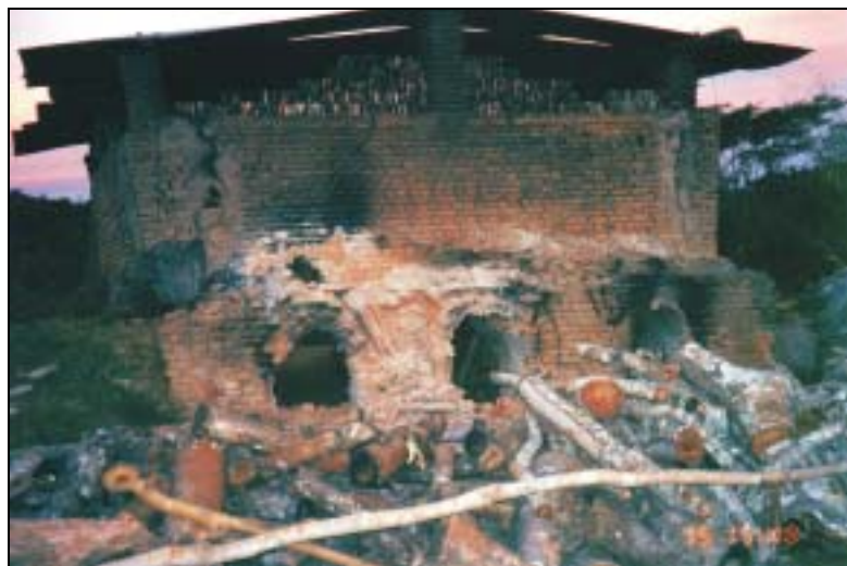
Fornos para queima de tijolos - Km 137,5, próximo do Ribeirão das Lages
