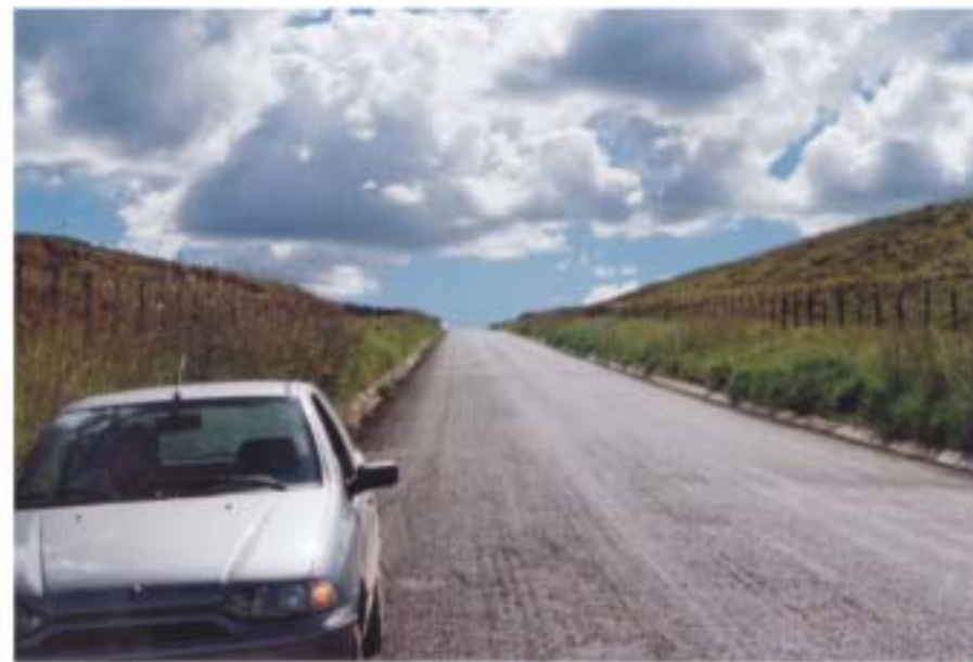
GO-427 sentido Itaguaru, destaque para os taludes de corte.
