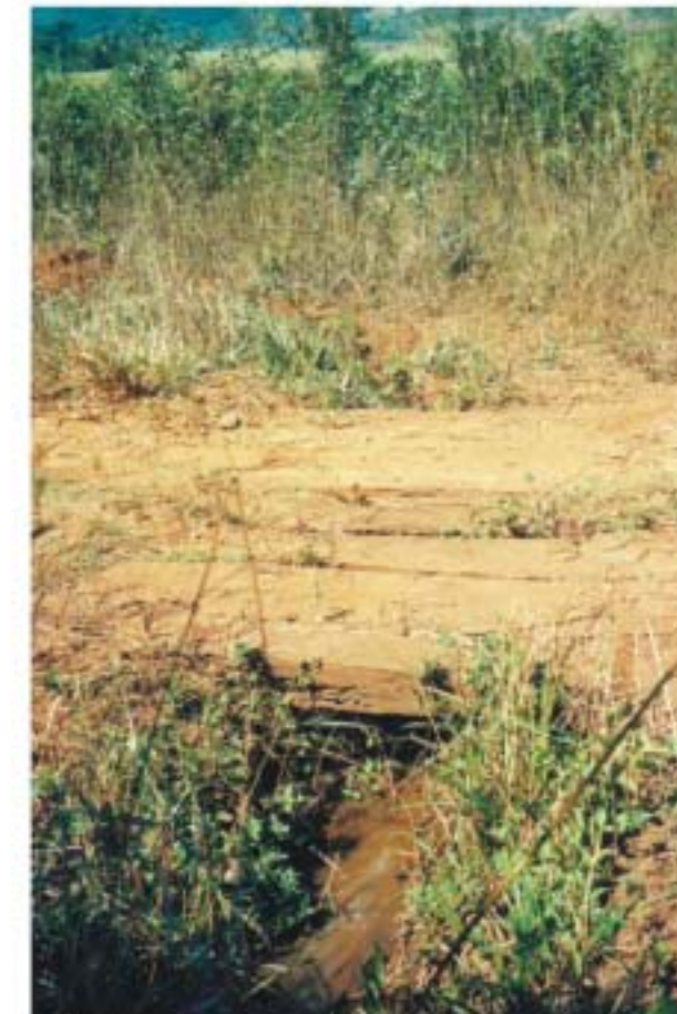
Detalhe da travessia sob a estrada.
