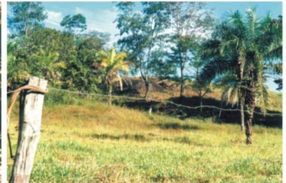
Afloramento rochoso na chácara Santa Luzia / corte em rocha - gnaisse.
