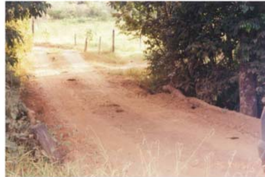
Detalhe da ponte sobre o Córrego dos Siqueiras.
