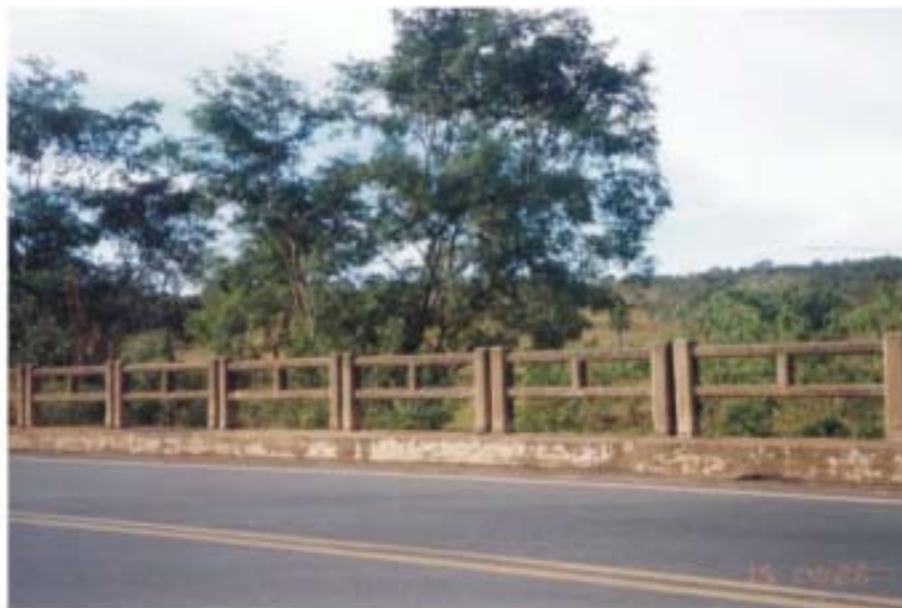
Visada do traçado sentido Ribeirão Sete Voltas, caracterizando a travessia sobre a ponte da BR-153 sobre o Rio Saraiva.
