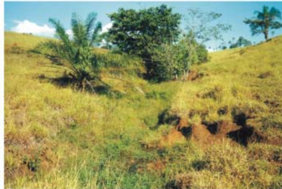
Visada para montante da drenagem, caracterização do leito.
