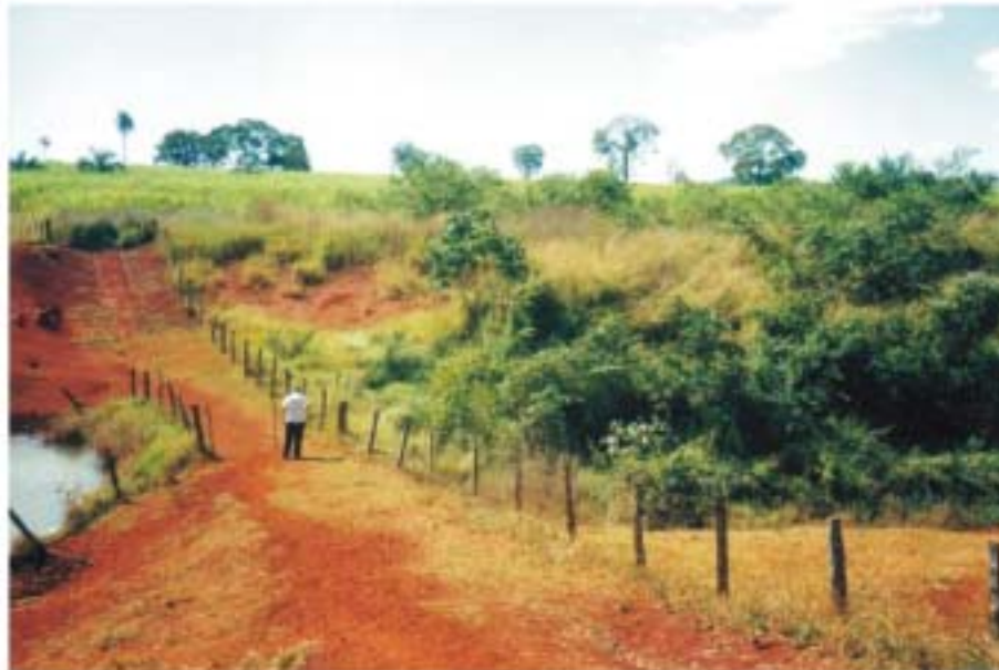
Visada do traçado sentido Ribeirão Sete Voltas. Destaque para o barramento efetuado pela estrada.
