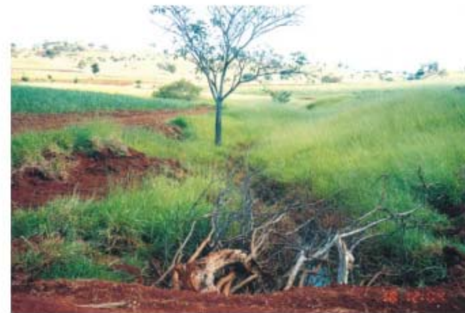
Visada para montante da drenagem.
