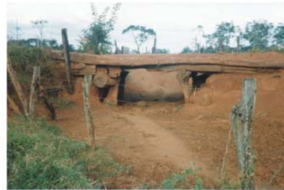
Detalhe da passagem de gado sob a estrada vicinal.
