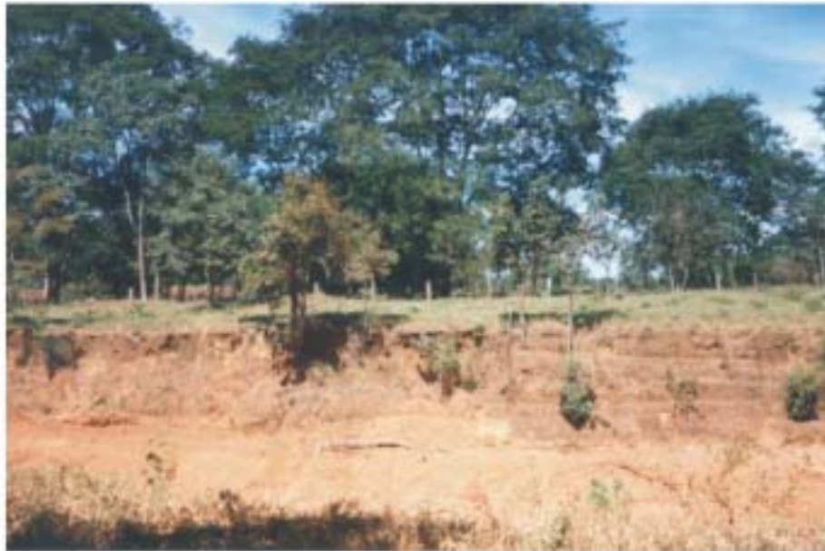
Visada do traçado sentido Jesúpolis. Observar caixa de empréstimo adjacente ao eixo da via.
