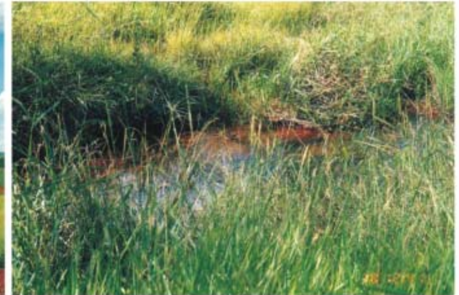
Detalhe do leito da drenagem no ponto de travessia.
