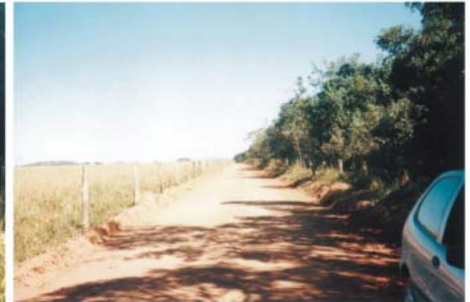
Leito da estrada vicinal, sentido BR-153.
