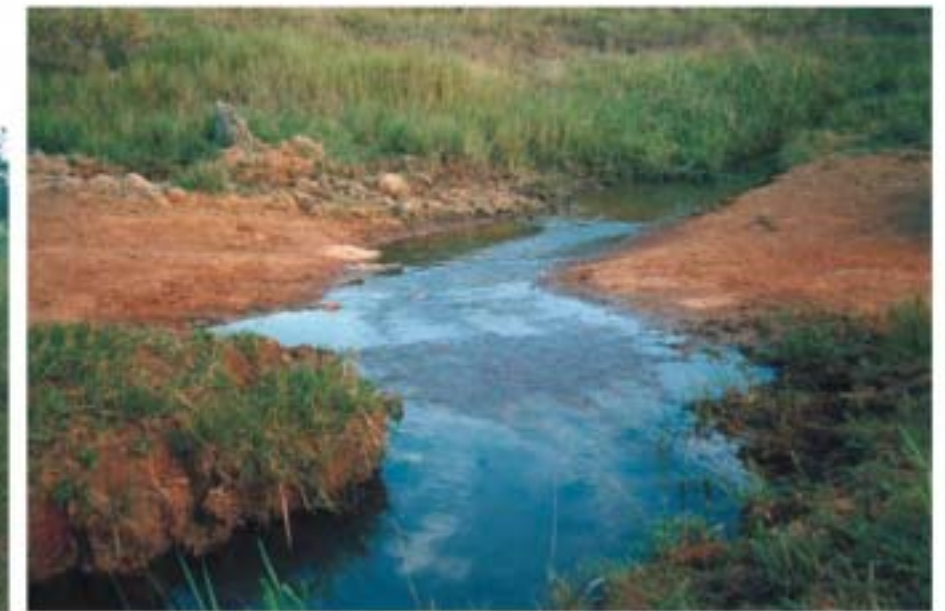
Detalhe do escoamento da drenagem sobre a estrada.
