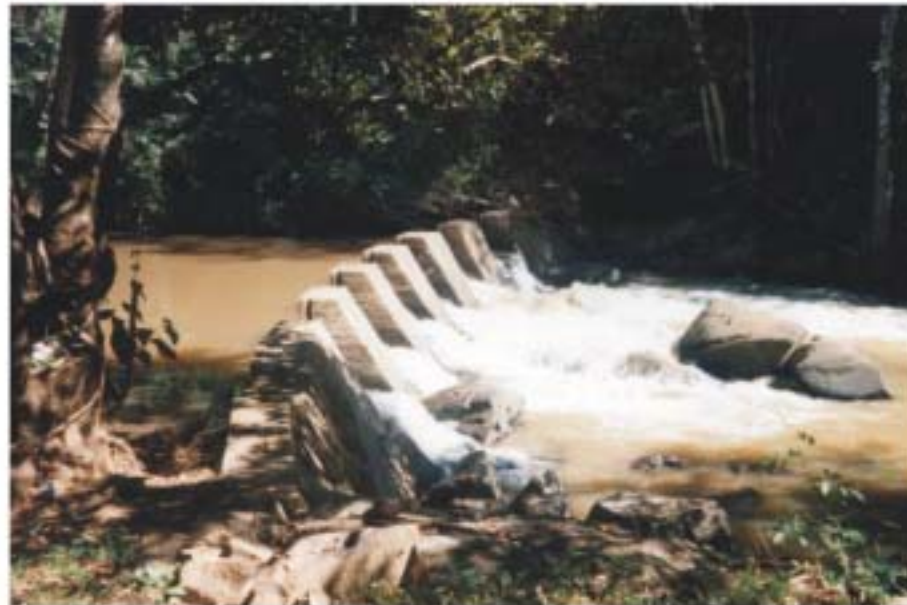
Barragem/ Dissipador de energia localizado no Córrego Diamante.
