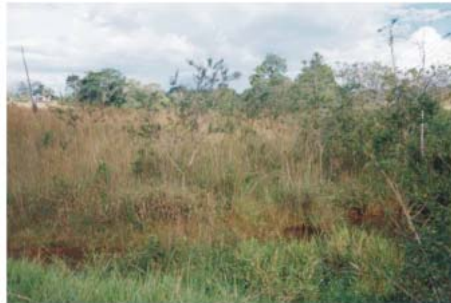
Visada perpendicular ao traçado, detalhe da drenagem.
