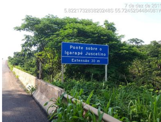
Ponte sobre o Igarapé Juscelino
