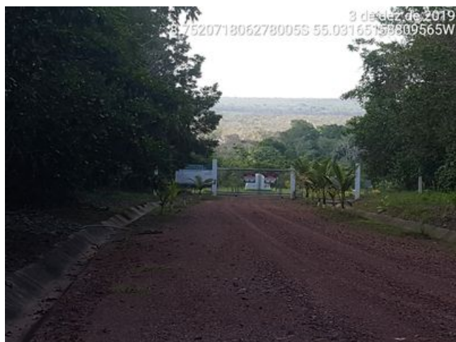
Entrada da PCH
