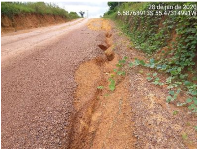
Cobertura superficial de cascalho possivelmente advinda de fonte externa para encascalhamento
