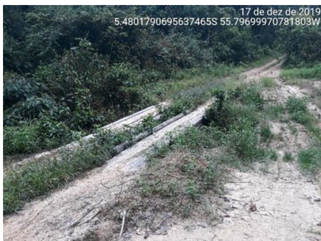
Ponte próximo ao Rio Aruri Grande.
