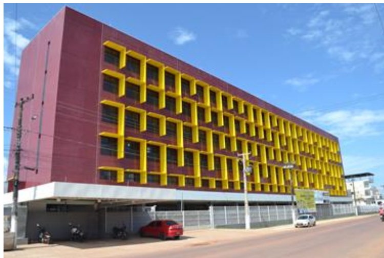
Figura 816 – Hospital Tapajós, município de Itaituba/PA, coord. 612285.53 m E 9527453.46 m S.
