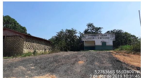
Figura 760 – Posto de saúde na Comunidade Santa Luzia (5,276366S; 56,028091W).
