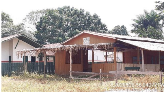
Figura 763 – Associação de Moradores da Vila Planalto (5,202050S; 56,040721W).
