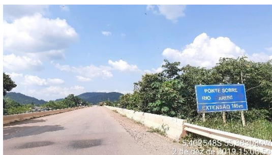
Figura 868 – Ponte da BR-163 sobre o rio Aruri (5,402548S; 55,883084W).
