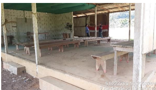
Figura 794 – Galpão comunitários da Comunidade São Francisco de Assis (5,622279S; 55,799876W).
