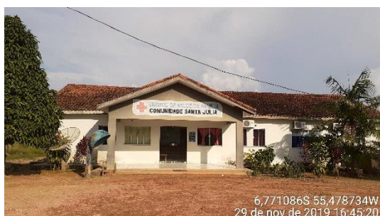
Figura 729 – Posto de saúde na Comunidade Santa Júlia (6,771086S; 55,478734W).
