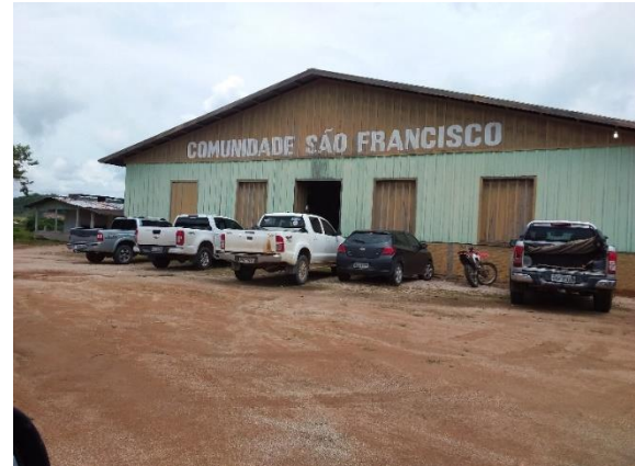
Figura 686 – Salão comunitário na Comunidade São Francisco de Assis (8,099417S; 55,143948W).
