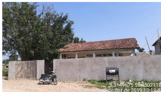
Figura 750 – Posto de saúde na Comunidade 03 Bueiros (5,314987S; 55,950211W).
