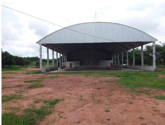
Figura 636 – Galpão da Igreja no Distrito de Miraguaí do Norte (10,365662S; 55,029263W).
