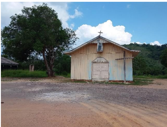
Figura 709 – Igreja Nossa Senhora Aparecida na Comunidade 1027 (7,496041S; 55,260952W).
