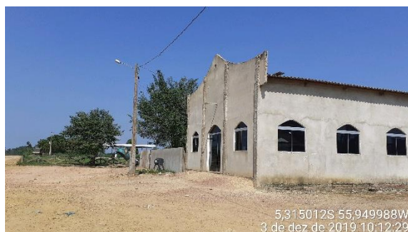
Figura 754 – Igreja na Comunidade 03 Bueiros (5,315012S; 55,949988W).
