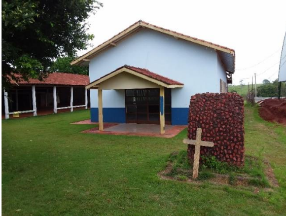
Figura 662 – Igreja na Comunidade Serra do Cachimbo (9,559004S; 54,872948W).
