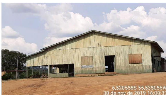
Figura 856 – Desapropriação de estrutura comunitária, Novo Progresso/PA (6,520558S; 55,535056W).
