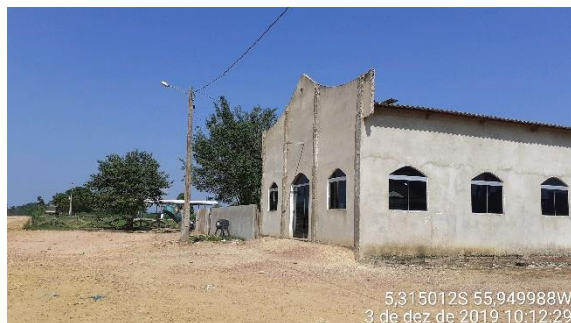
Figura 749 – Igreja na Comunidade 03 Bueiros (5,315012S; 55,949988W).
