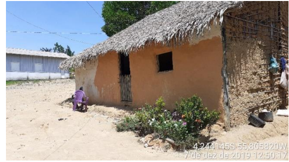
Figura 812 – Casa na Comunidade São Raimundo (4,244145S; 55,805820W).
