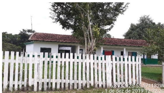
Figura 739 – Escola na Comunidade Riozinho das Arraias (6,393292S; 55,571182W).
