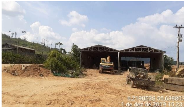
Figura 837 – Madeireira na região estudada – Itaituba/PA (6,219053S; 55,638807W).
