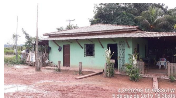
Figura 857 – Desapropriação de estrutura mista (comércio e residência), Itaituba/PA (4,392029S; 55,958361W).
