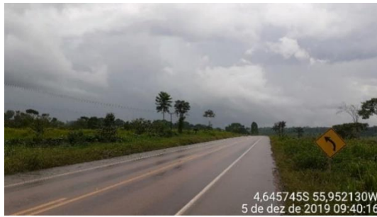
Figura 852 – Rodovia BR-163, Trairão/PA (4,645745S; 55,952130W).
