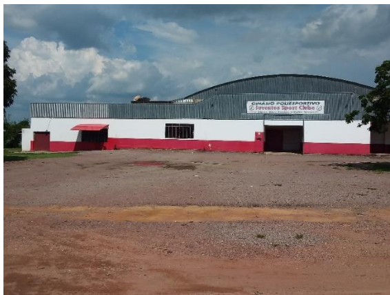
Figura 652 – Centro Poliesportivo em Cotrel (9,948444S; 54,953627W).
