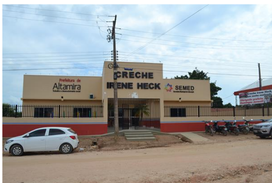
Figura 673 – Creche Irene Reck, Distrito Castelo dos Sonhos/Altamira (709613.42 m E, 9080250.44 m S).
