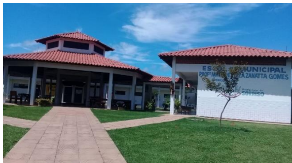
Figura 608 – Escola Municipal localizada no PA Jonas Pinheiro (sem coordenadas). Fonte: APROCEL, 2020.
