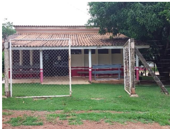
Figura 637 – Posto de Saúde no Distrito de Miraguaí do Norte (10,365352S; 55,029720W).
