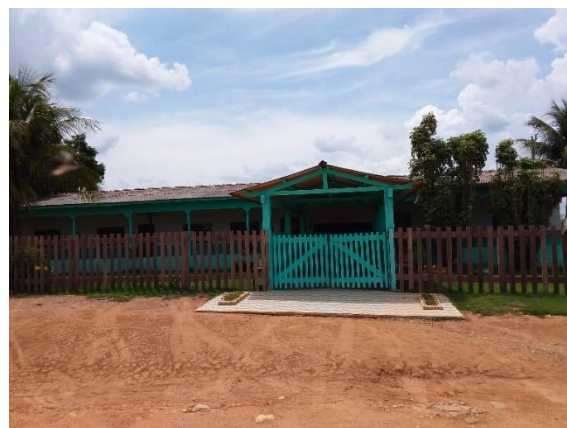
Figura 694 – Escola na Vila Isol (7,726970S; 55,208944W).
