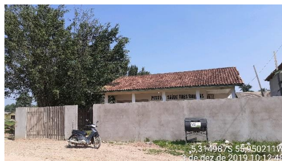
Figura 755 – Posto de saúde na Comunidade 03 Bueiros (5,314987S; 55,950211W).
