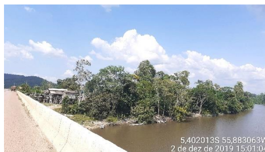
Figura 869 – Vista da comunidade a partir da ponte sobre o rio Aruri (5,402013S; 55,883063W).
