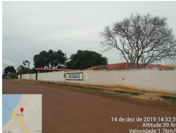
Figura 810 – Escola Municipal de Ensino Fundamental Carlos Sarmiento, Distrito de Miritituna/Itaituba.
