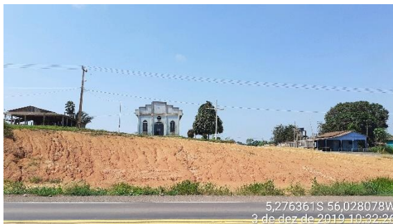
Figura 759 – Igreja na Comunidade Santa Luzia (5,276361S; 56,028078W).
