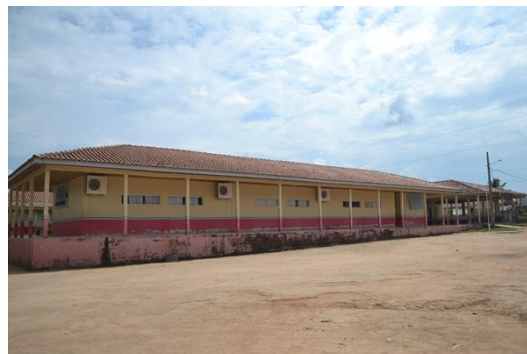
Figura 672 – Escola de Ensino Fundamental João Paulo II, Distrito Castelo dos Sonhos/Altamira (coord. 708209.63 m E, 9079641.49 m S).
