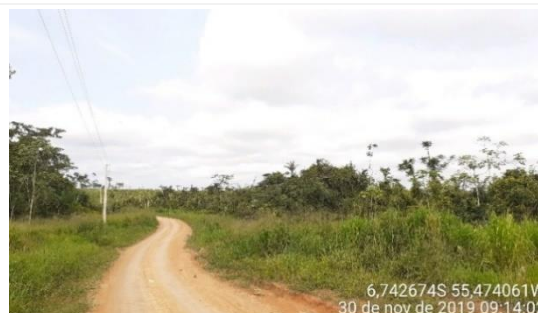
Figura 851 – Estrada vicinal, Novo Progresso/PA (6,742674S; 55,474061W).
