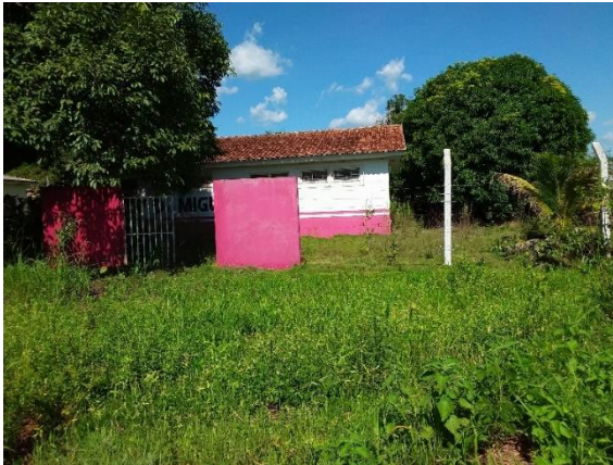
Figura 632 – Colégio desativado no PA União de Todos (10,448301S; 55,187223W).
