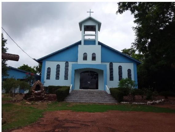
Figura 634 – Igreja São Roque no Distrito de Miraguaí do Norte (10,365073S; 55,029061W).
