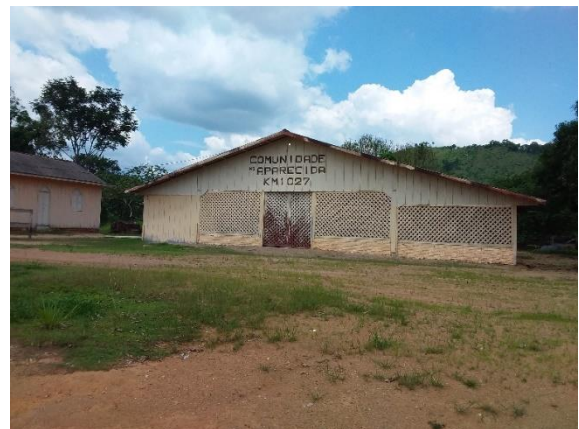
Figura 710 – Salão comunitário na Comunidade 1027 (7,496284S; 55,260845W).
