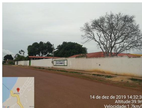
Figura 14 – Escola Municipal de Ensino Fundamental Carlos Sarmiento, Distrito de Miritituna/Itaituba.
