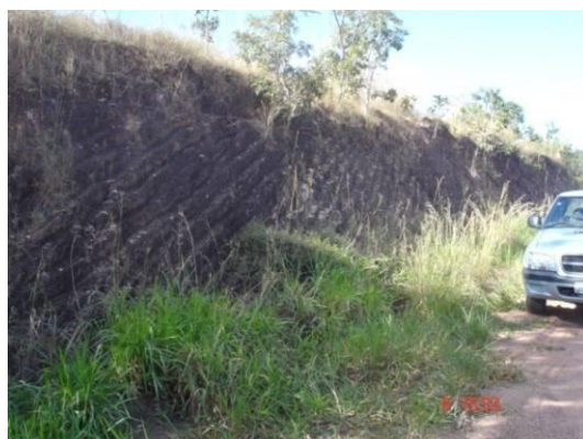
Figura 5.1-125 - Exposição do Horizonte C em talude. (Coord. UTM: N8419970/ E695618).
