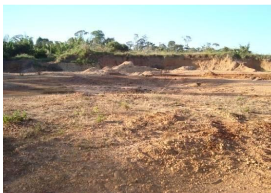
Figura 5.1-227 - Caixa de empréstimo de rodovia, com destaque ao Plintossolo associado ao Neossolo próximo ao Rio Ponte de Pedra. Coord. UTM: N8561250/ E475222.
