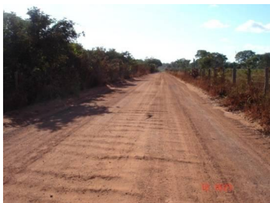
Figura 5.1-155 - Município de Cocalinho – MT, Localidade com presença de Latossolo Vermelho-Amarelo. Coord. UTM: N8411834/ E499303
