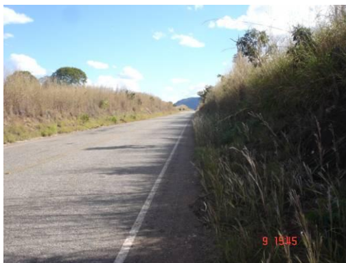
Figura 5.1-92 – Exemplo de taludes que serão implantados na região de relevo ondulado. Taludes em saprolito.
