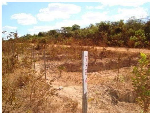
Figura 5.1-204 - Rodovia na proximidade do Rio Teles Pires com drenagem para escoamento de água pluvial. Coord. UTM: N8546526/ E644279.
