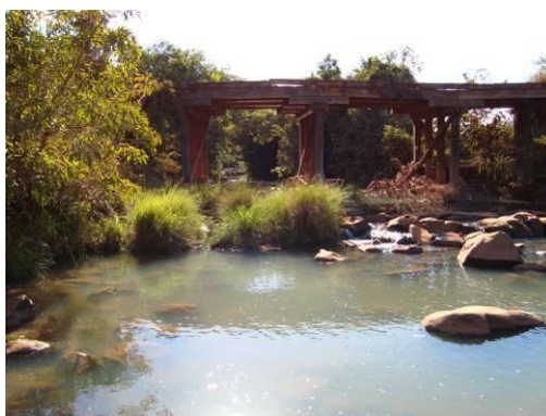
Figura 5.1-45 - Córrego Lajeado. Observam-se diversos afloramentos de rocha ( in situ ou não) ao longo do leito da drenagem (Coord.: 22L 389.557/8.450.348).
