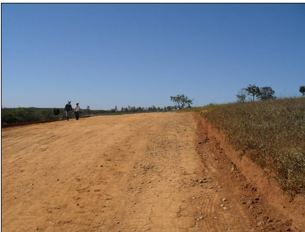
Foto 5 - Plataforma a ser recuperada na área de ampliação do Pátio Ferroviário de Hélio Torres.
