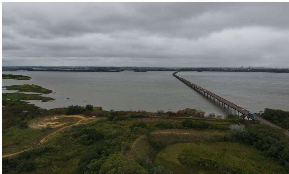
Foto 6-1: Vista Aérea da Ponte Ayrton Senna a Partir da Margem Sul-Mato-Grossense
