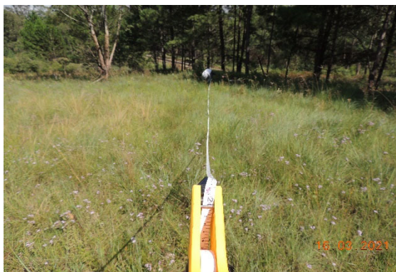
Foto 5-111: Instalação de Unidade Amostral em Áreas de Campo Nativo
