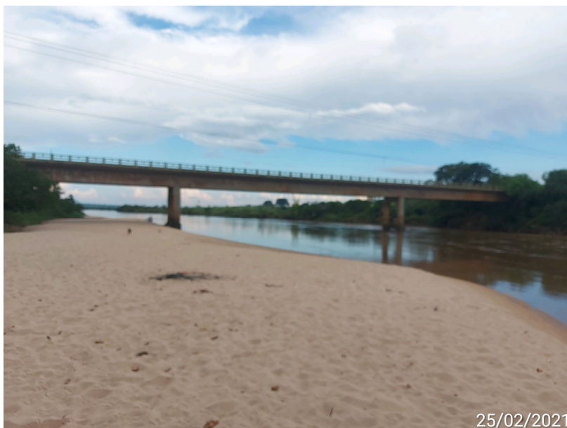
Foto 5-3: Aspecto Geral das Margens do Rio Iguatemi na APA da Bacia do Rio Iguatemi, Divisa entre os Municípios de Eldorado e Mundo Novo
