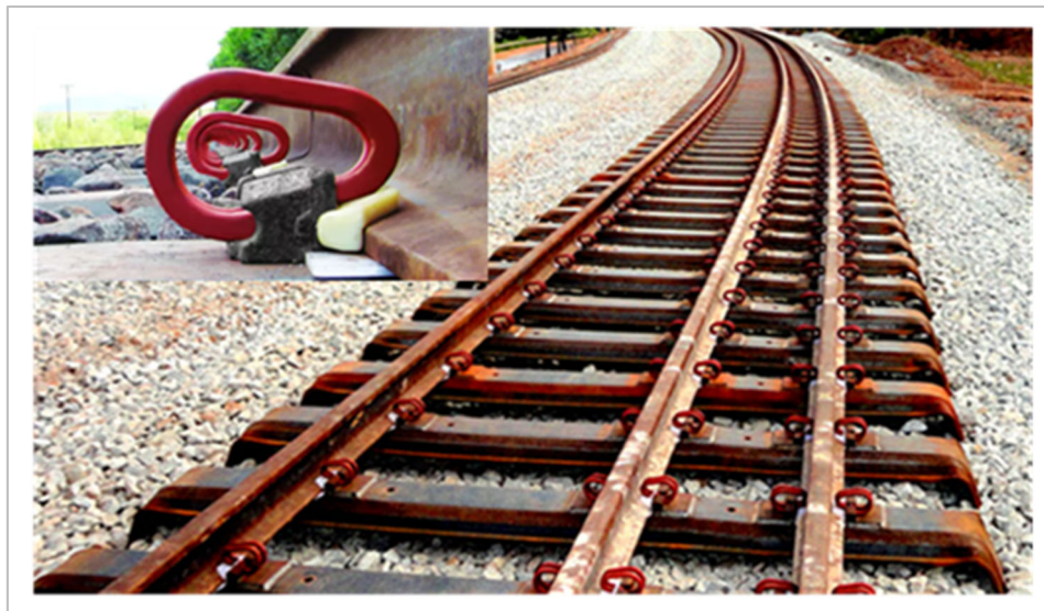
Figura 9-12: Fixações Elásticas
