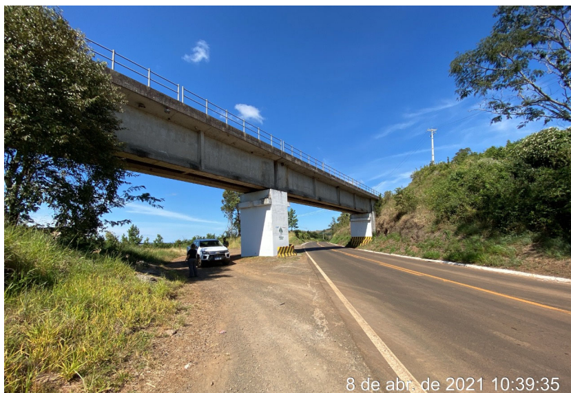
Foto 9-4: Viaduto Sobre a BR-158
