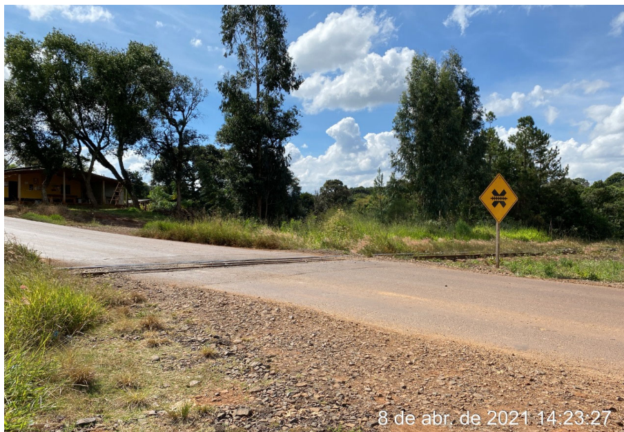
Foto 9-2: Passagem em Nível na PR-364
