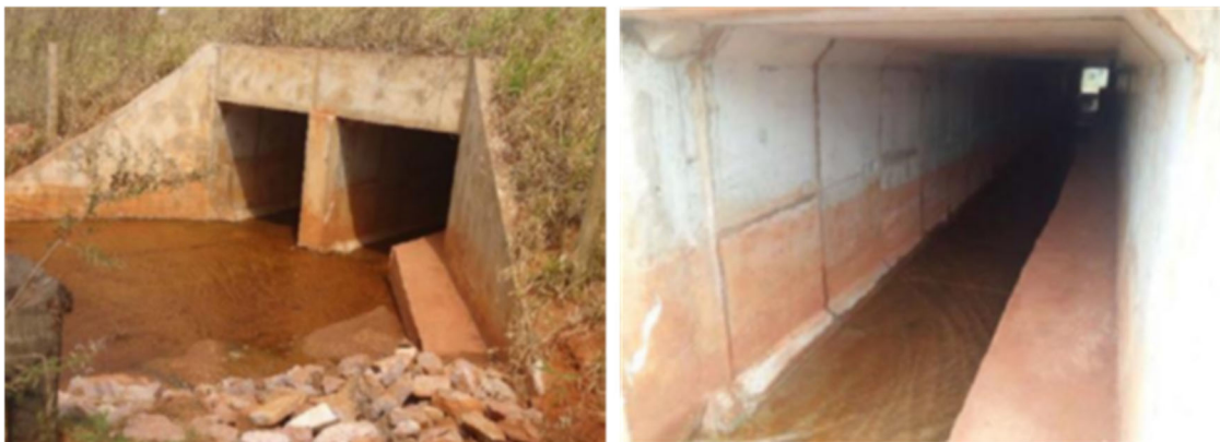
Figura 9-14: Galerias para Passagem de Fauna
