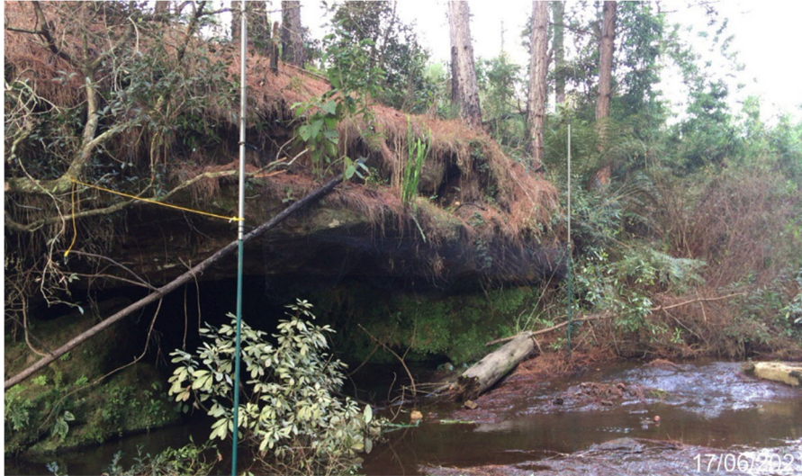
Foto 5-255: Rede Instalada na Saída da Caverna na Caverna Engenheiro Bley
