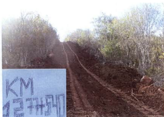
Figura 1 – Abertura de acessos no lote 2 da FIOL, realizada após a retificação da AAP nº385/2010, em 2013, que autorizou o aumento da largura do acesso para 3m.
