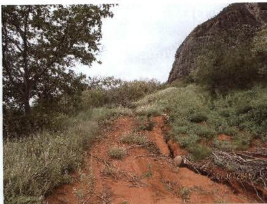
Figura 35 - Abertura de acesso no lote 5 da FIOI.
