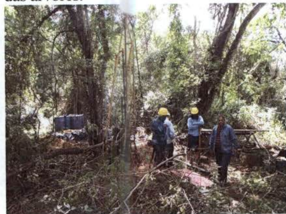
Figura 12 – Abertura de picada para sondagem no lote 4 da FIOLE.
