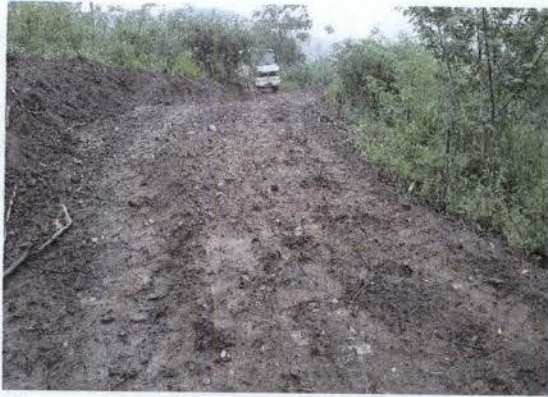
Figura 3 – Abertura de acessos no lote 2 da FIOL, realizada após a retificação da AAP nº385/2010, em 2013, que autorizou o aumento da largura do acesso para 3m.
