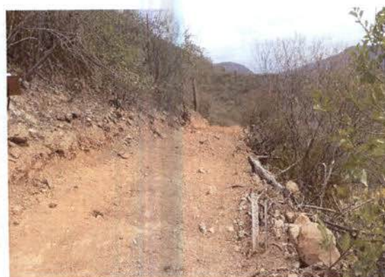
Figura 2 – Abertura de acessos no lote 2 da FIOL, realizada após a retificação da AAP nº385/2010, em 2013, que autorizou o aumento da largura do acesso para 3m.
