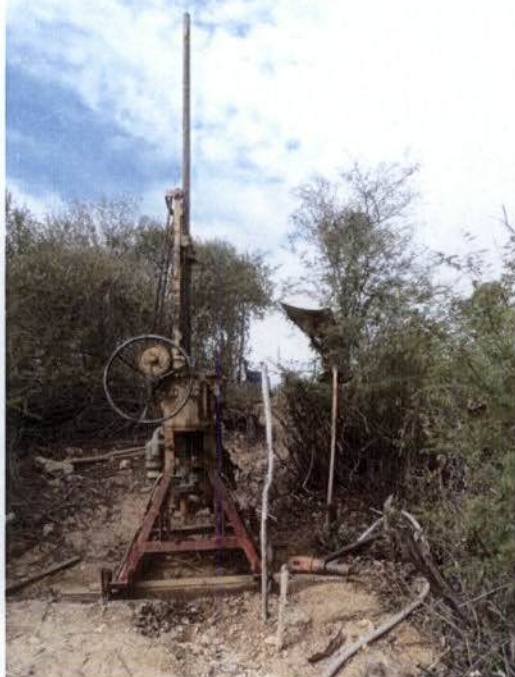
Figura 19 – Abertura de picada para sondagem no lote 4 da FIOI
