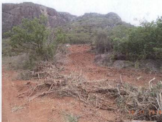
Figura 30 – Abertura de acesso no lote 5 da FIOI, evidenciado apenas o corte de galhos com menos de 5 cm de diâmetro.
