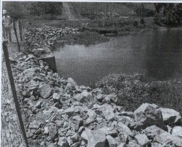
11. Rio Laje do Banco (Km 1433+400)
