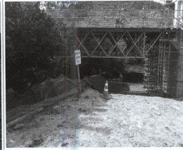
6. Ponte sobre Rio da Onça (Km 1385)
