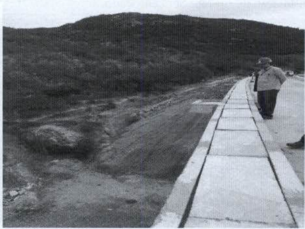
7. Drenagem provisória na faixa de domínio nas imediações da ponte 16A.
