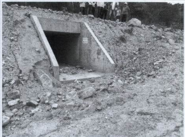
12. passagem de fauna ainda sem cercamento e obstruída do outro lado.
