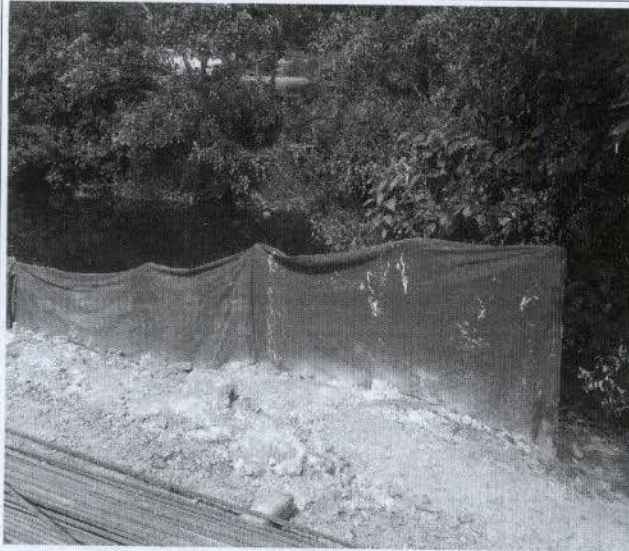
7. Ponte sobre Rio da Onça (Km 1385)
