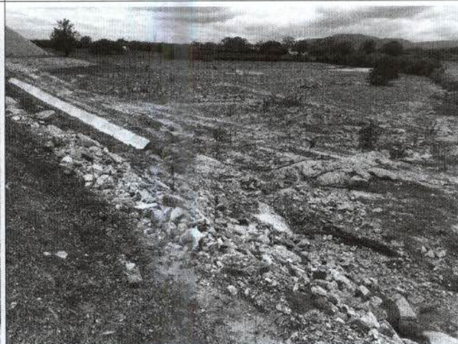
Foto 16 - Drenagem no km 1083+936
