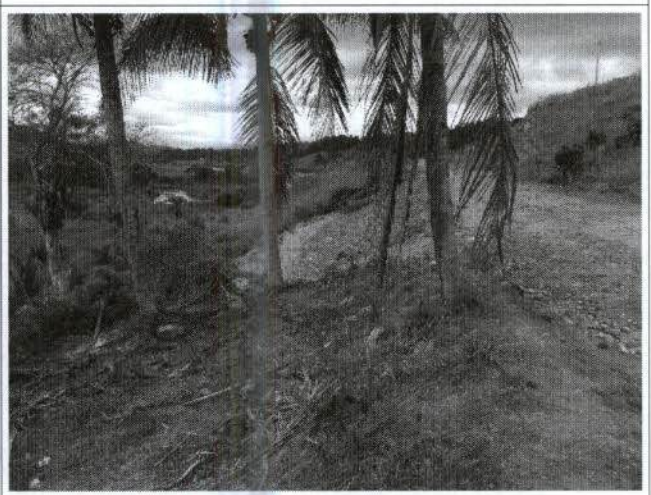
14. 1407+800: Observamos que a solicitação de vistoria anterior para retirada de material foi atendida.
