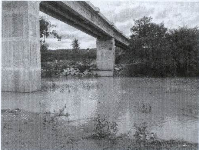
Foto 21 - km1107, ponte sobre o Rio Brumado
