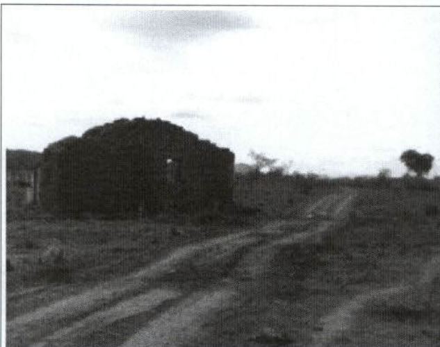
Foto 01- Km 871+980- Residência a ser demolida
