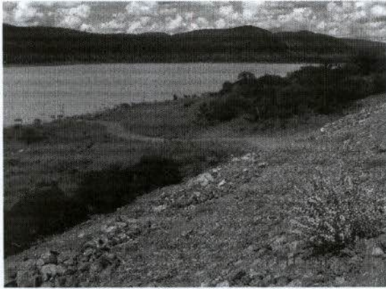
Foto 105. Caminho de serviço com processos erosivos.
