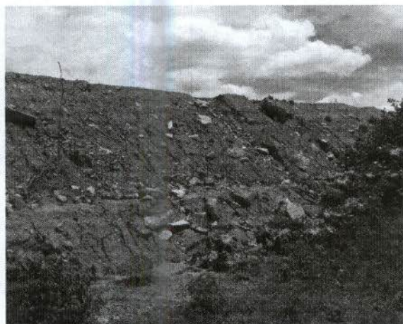
Foto 27. Aterro com erosões.
