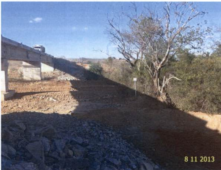
Figura 4 - Bacia de acumulação implantada no Km 1166+000
