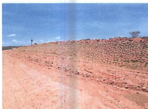
Hidrossemeadura aplicada no Km 1048+300. Data: 03/11/2013.
