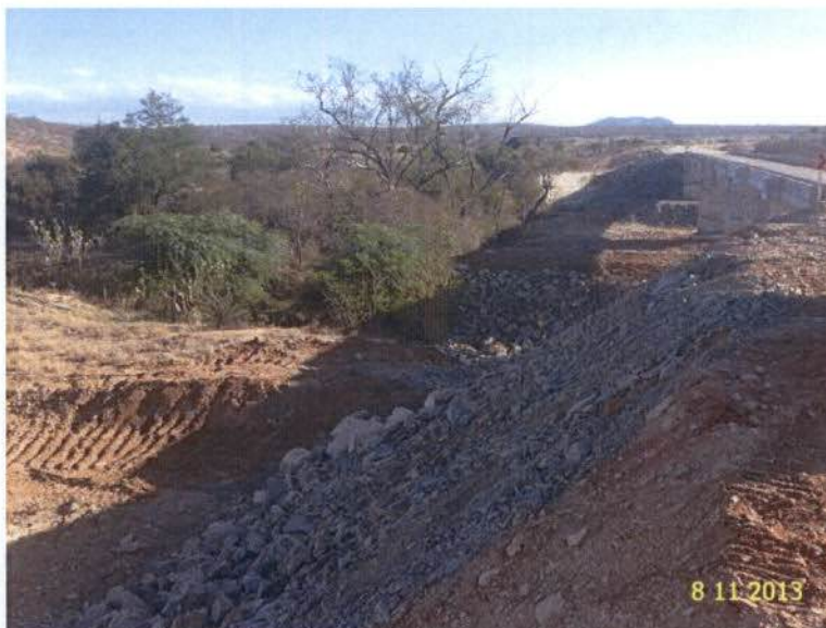
Figura 3 – Bacia de acumulação implantada no Km 1166+000
