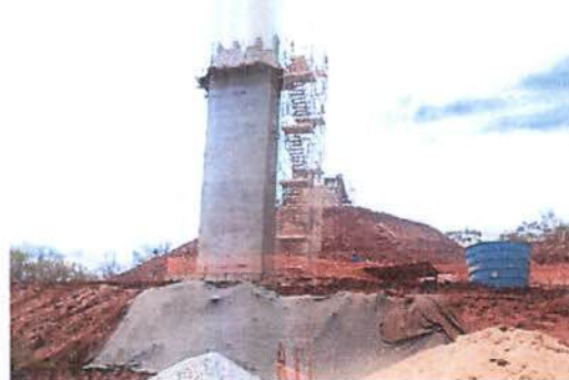
Proteção do talude do pilar e contenção dos processos erosivos com instalação de manta geotêxtil. Data: 30/10/2013.
