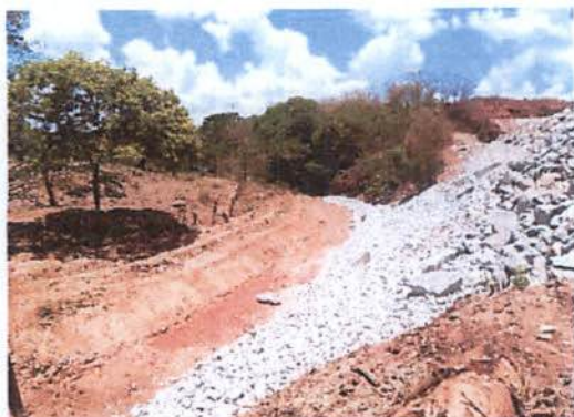
Enrocamento do corta-rio realizado no Km 991+360. Data: 12/11/2013.
