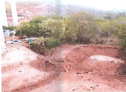
Construção de 03 bacias de infiltração e contenção (lado direito) no viaduto Brejinho I. Data: 30/10/2013.
