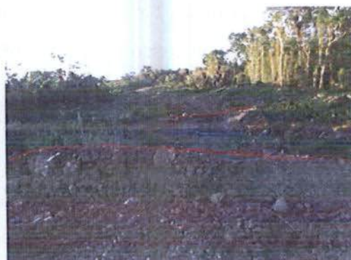
Bacias de contenção implantadas próximas ao recurso hídrico do km 1439+120.
