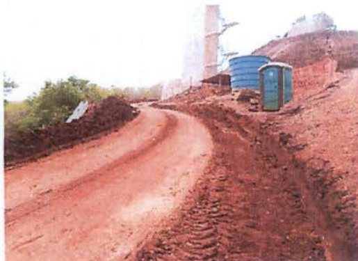
Construção canaletas que direcionam a água pluvial para as bacias de infiltração e contenção (lado esquerdo) no viaduto Brejinho I. Data: 30/10/2013.
