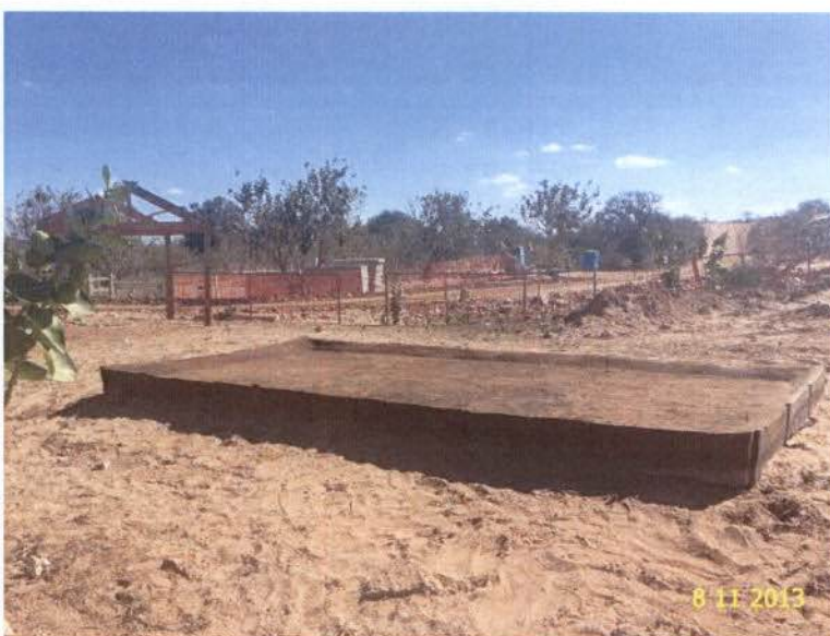
Figura 5 - Remoção de gerador e solo contaminado no Km 1190+060.
