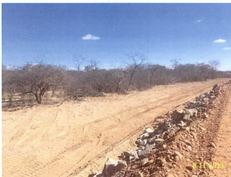
Figura 1 – Conformação de expurgo no km 1193+760
