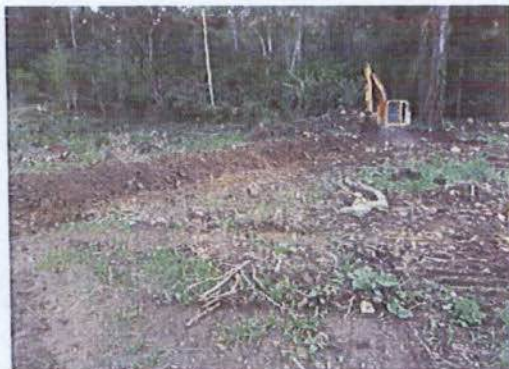
Implantação de bacias de contenção.
