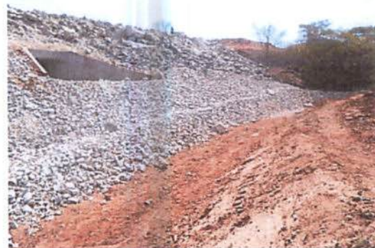
Enrocamento do corta-rio realizado no Km 991+360. Data: 29/10/2013.
