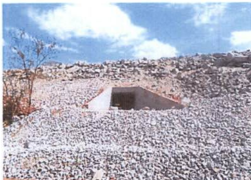
Enrocamento do corta-rio realizado no Km 991+360. Data: 29/10/2013.
