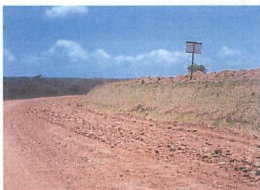
Hidrossemeadura aplicada no Km 1047+580. Data: 03/11/2013.
