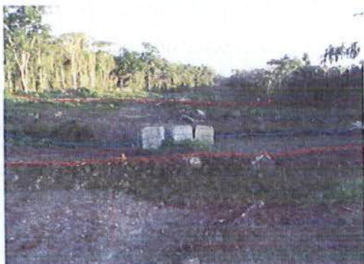
Bacias de contenção implantadas próximas ao recurso hídrico do km 1439+000.
