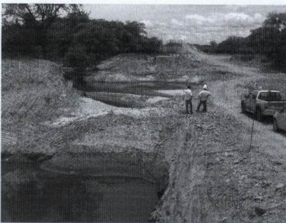
Foto 64. Intervenções na ponte do Rio do Peixe
