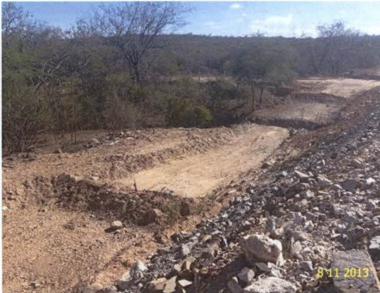
Figura 2 – Hidrossemeadura realizada no km 1200+420.
