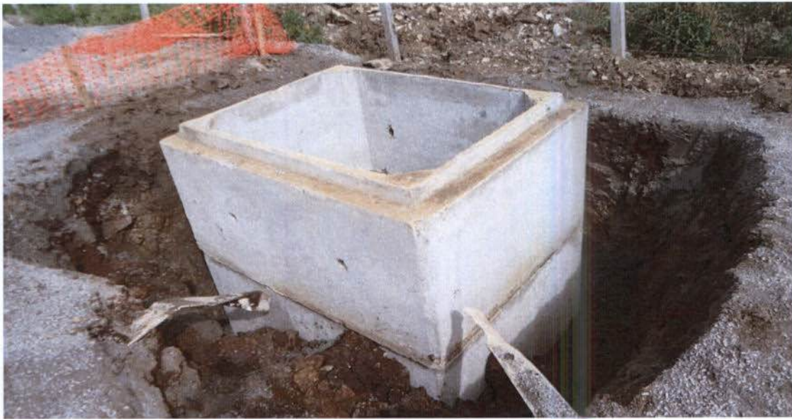
Início da Construção do novo Canteiro Bioséptico
