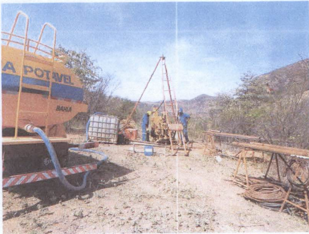
Foto 17. Vista do processo de execução de sondagem mista (Sonda e Caminhão Pipa)
