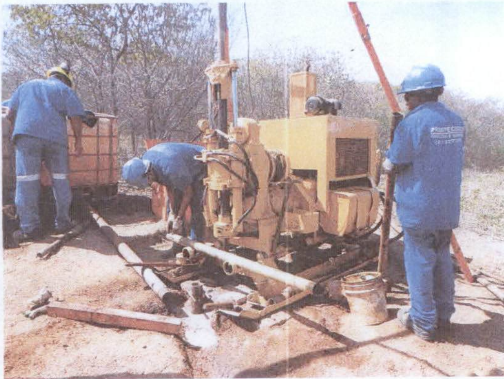
Foto 18. Vista do processo de execução de sondagem mista (Sonda)
