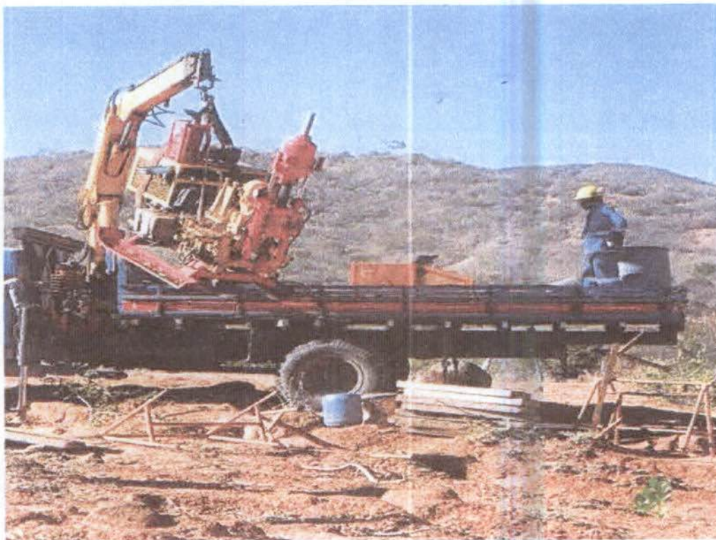
Foto 16. Deslocamento do equipamento de sondagem mista com caminhão Guindauto
