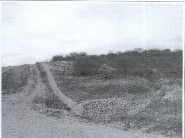
Drenagem de crista em instalação.
