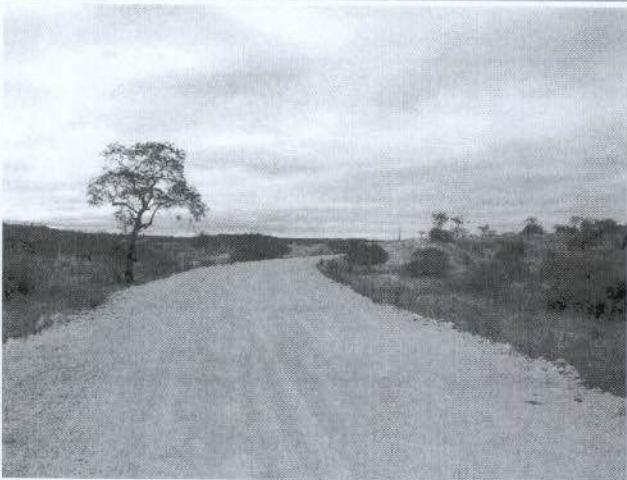
Plataforma já com sublastro.
