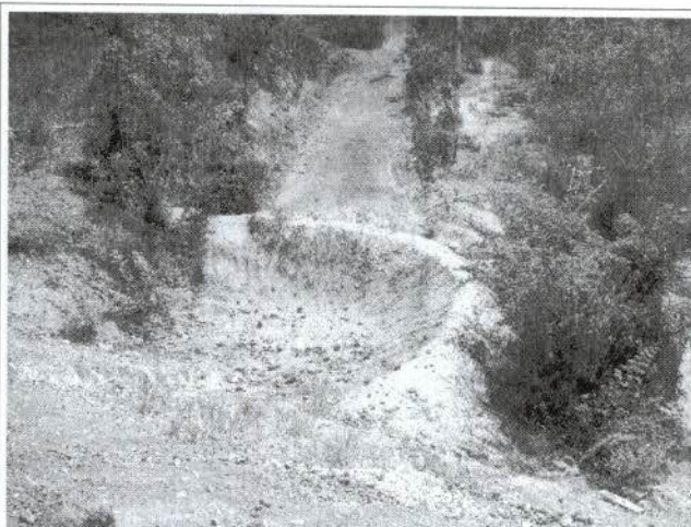
Bacia de contenção de sedimentos na base do aterro.
