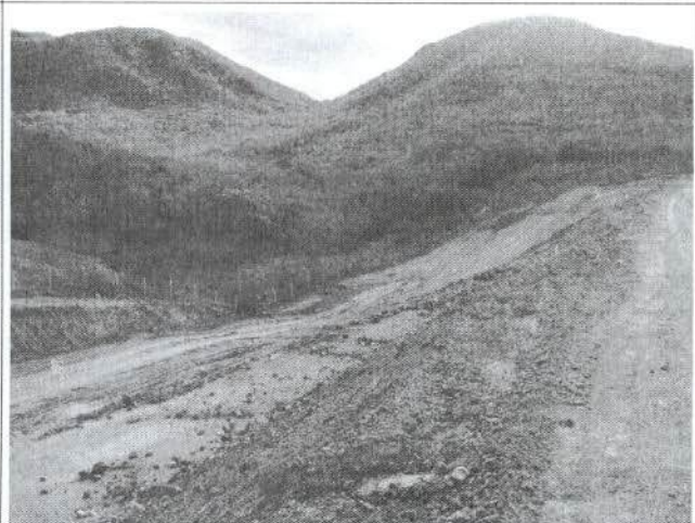
Talvegue na base do aterro sem qualquer
