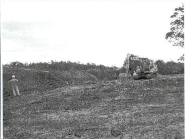
Atividades de Terraplenagem em andamento.
