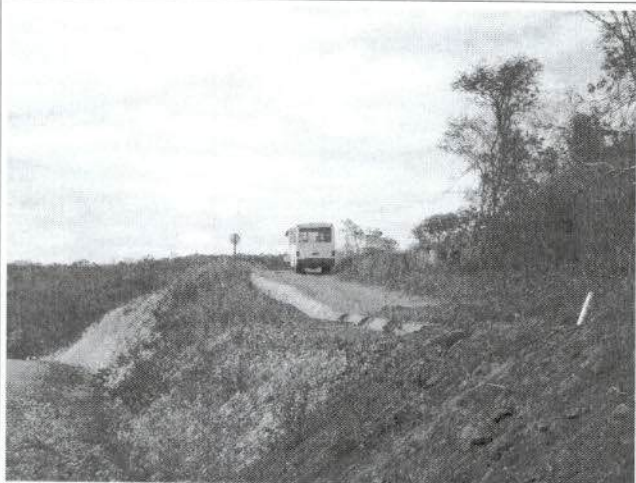
Drenagem de crista em instalação.
