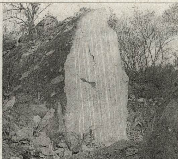
Foto 06 Desmonte de Rocha
