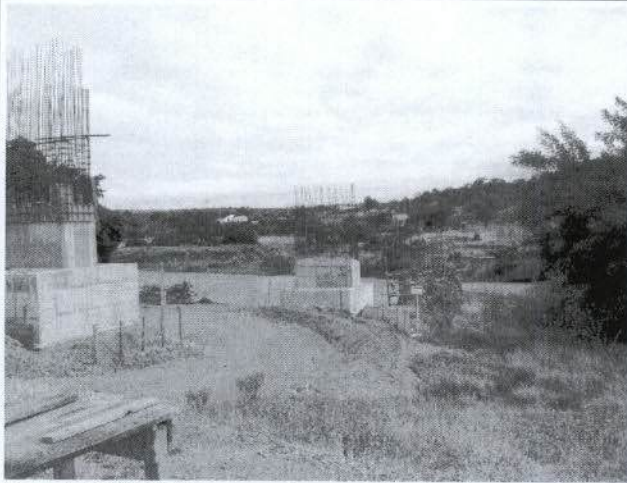
Km 1.137,90 Ponte sobre o Rio de Contas, com previsão de lançamento das vigas em setembro.
