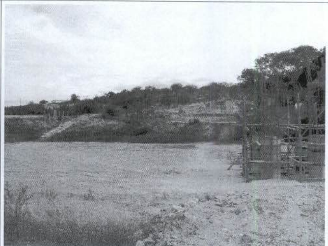
Ponte sobre o Rio de Contas, local com boa utilização de sistemas de contenção de sedimentos.
