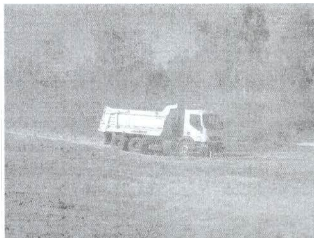
Figura 2-Transporte de solo na frente de obra sem a utilização de lona na caçamba.
