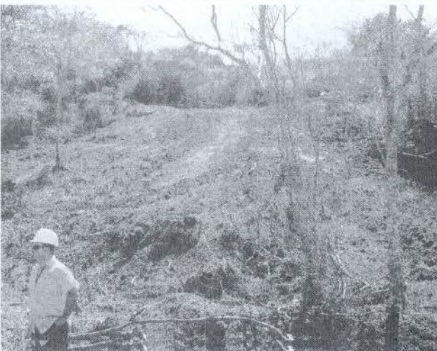
Figura 23: Córrego do Brejinho 2 - vista do talude da margem esquerda. Talude desprotegido e material depositado sobre a vegetação viva
