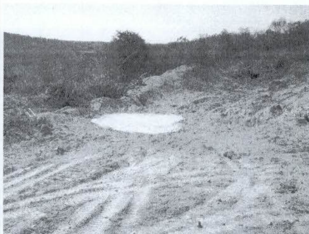
Figura 11: Cimento disposto diretamente sobre o solo
