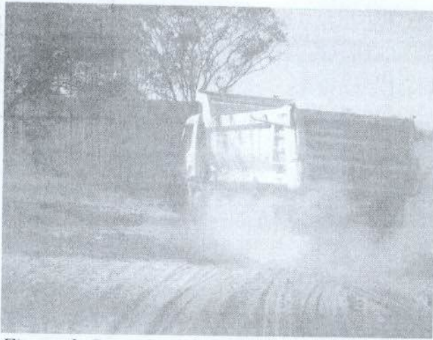
Figura 3-Caminhão trafegando na frente de obra.
