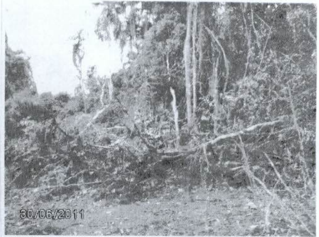
Figura 81: Vegetação desmatada de modo inadequado, sendo apenas empurrada para a lateral da faixa de domínio sobre a vegetação viva, sem ser realizada a separação do material lenhoso
