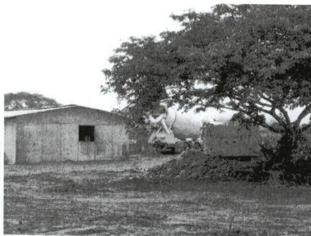
Figura 93: Resíduos dispostos de modo inadequado, de baixo de uma árvore, e ao fundo, um caminhão sendo lavado diretamente sobre o solo exposto
