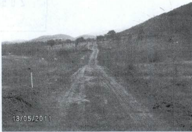
Figura 71: Picada aberta para a topografia do trecho
