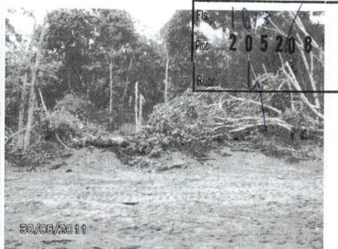
Figura 85: Outra árvore de grande porte a qual foi derrubada em desacordo com a metodologia de desmatamento aprovada no PBA
