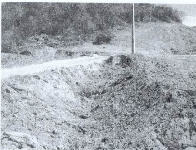
Figura 16: Outro córrego afetado pelas obras
