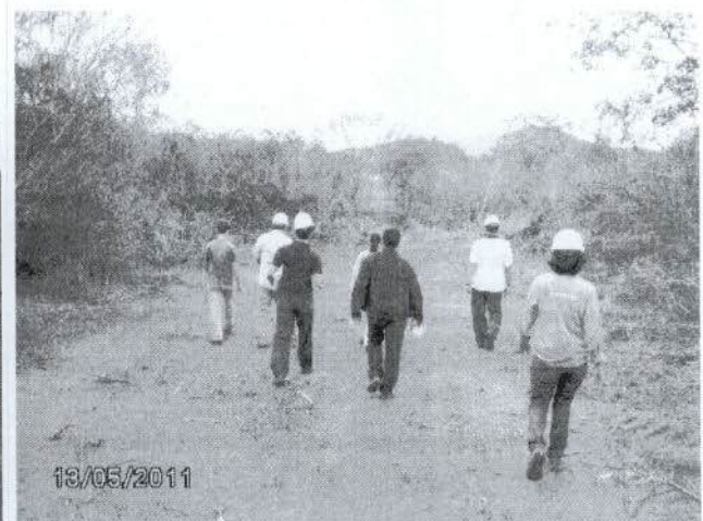
Figura 76: Desmatamento - ao fundo observa-se uma área ainda vegetada que se trata de um córrego, neste caso foi deixada um pouco de vegetação para proteger o corpo d'água até a obra começar efetivamente.
