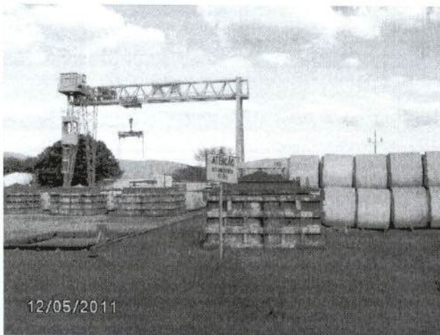
Figura 33: Fábrica de tubos e aduelas - pátio de concretagem
