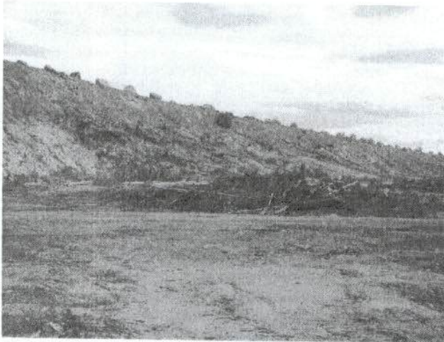
Figura 68: Deposito de material vegetal de maneira inadequada
