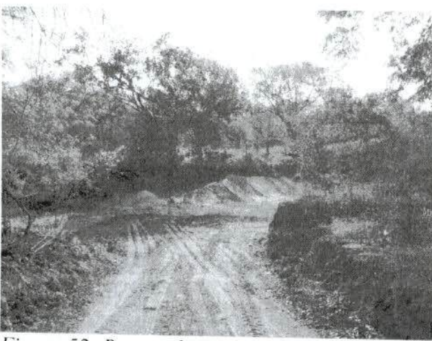
Figura 52: Rampa de acesso ao leito rio, a qual foi escavada diretamente na margem do rio.
