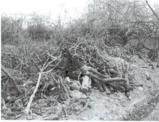
Figura 58: Material vegetal (lenhoso e galhadas) depositados na lateral da faixa de domínio sobre a vegetação viva.
