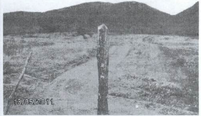
Figura 72: Picada aberta para a topografia do trecho
