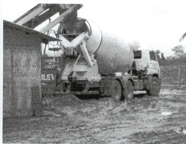
Figura 94: Caminhão sendo lavado diretamente sobre o solo exposto
