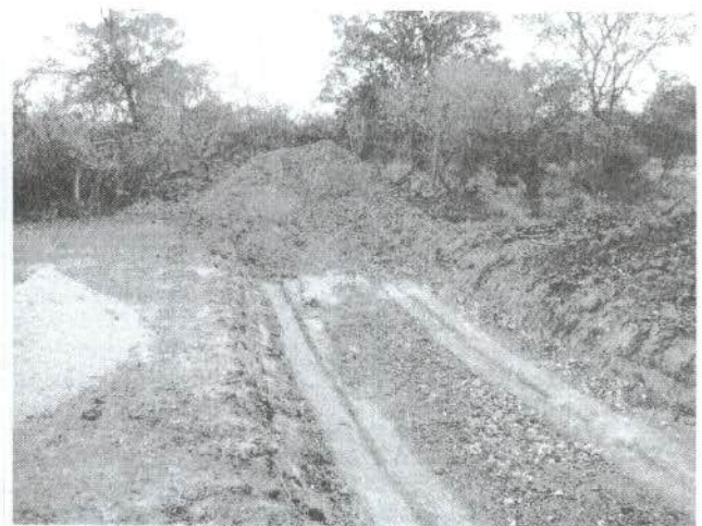
Figura 51: Solo superficial orgânico, o qual foi estocado sendo empurrado contra a vegetação em direção ao Rio São João na sua área de APP
