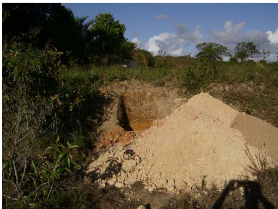
Foto 13 – KM 1485+950 – Sondagem ST para caracterização do geotécnica do solo.
