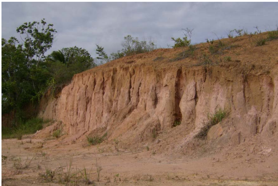
Foto 10 – KM 1485+900 – Solo silto-argiloso para composição de aterro.
