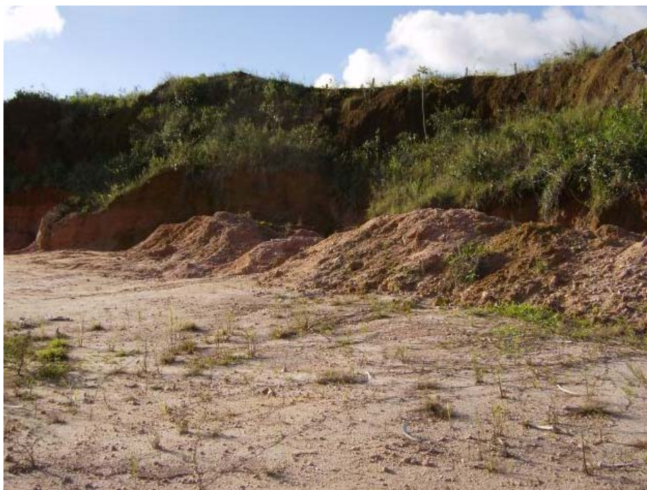
Foto 09 – KM 1484+050 – Solo silto-argiloso para composição de aterro.
