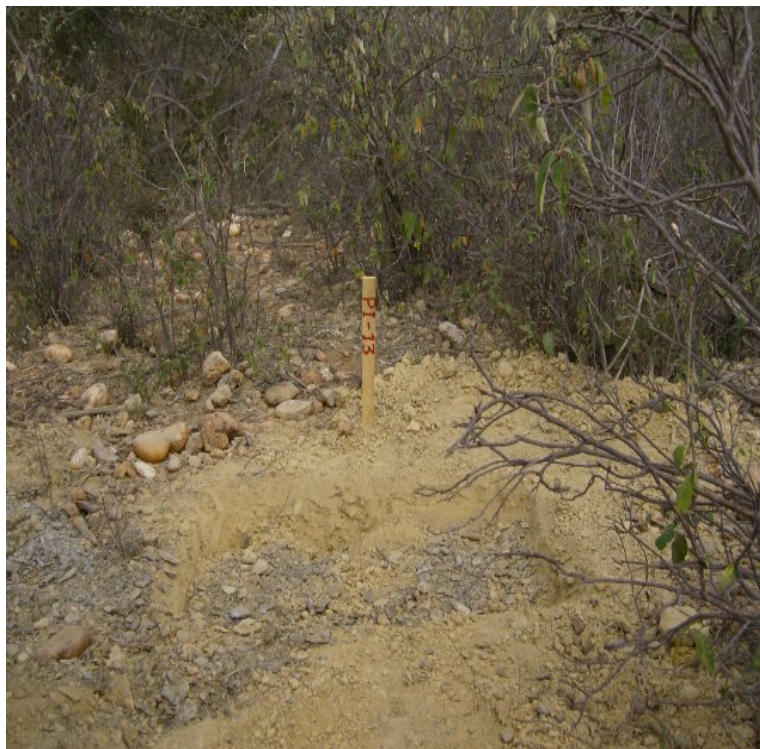
Foto 12 – KM 1485+950 – Poço de inspeção (PI), para estudo de subleito.
