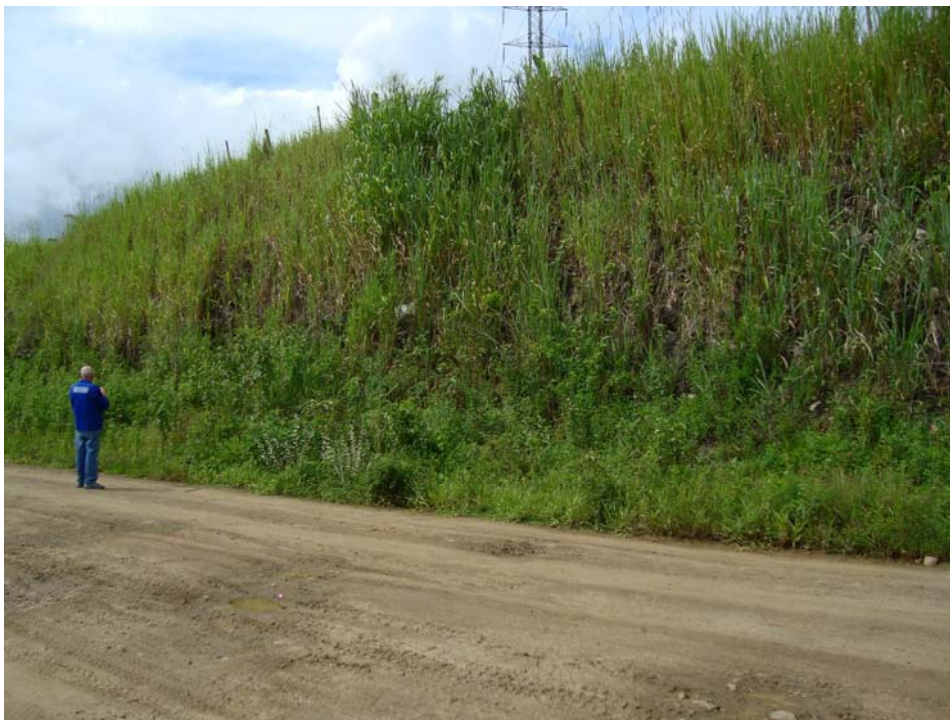
Foto 06 – KM 1418 – Talude em solo areno-argiloso, avermelhado, boa plasticidade de 2,0 metros de espessura e topo rochoso a 4,0 metros de profundidade.
