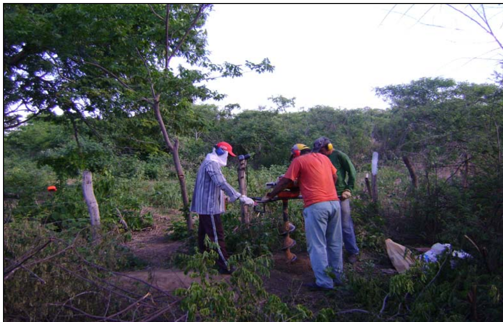
Figura 2: realização da sondagem ST-1057
