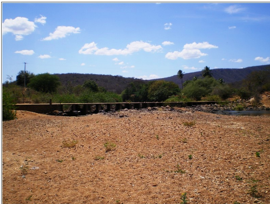
Figura 48: Interior da caixa no Rio Brumado – Vista ponte à jusante
