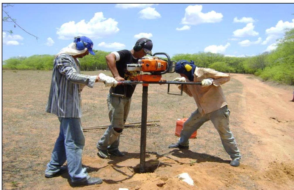
Figura 3: realização da sondagem ST-1300
