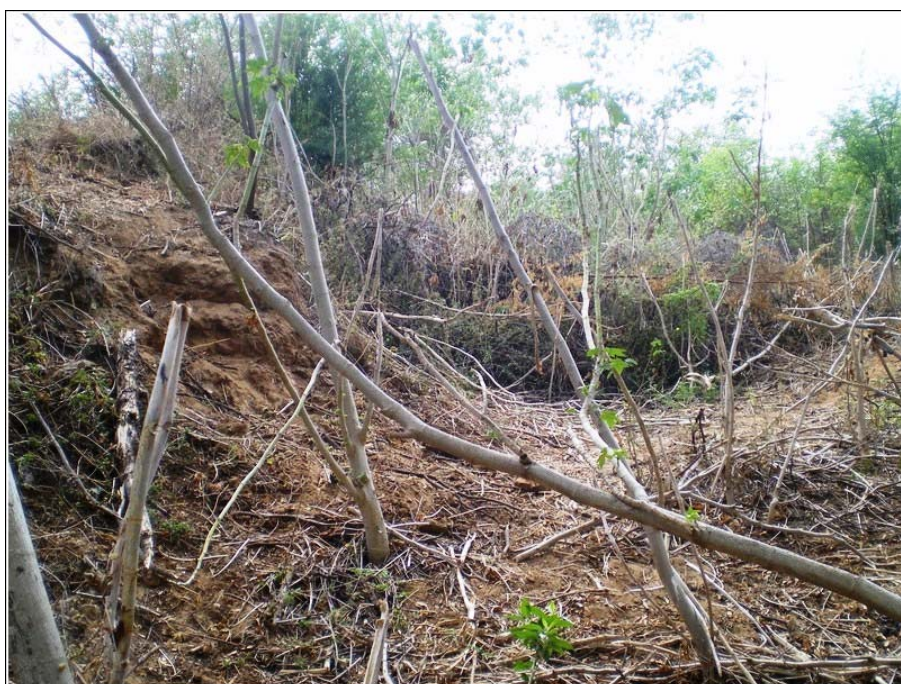
Figura 28: Interior da caixa Riacho das Antas – Vista de montante para jusante
