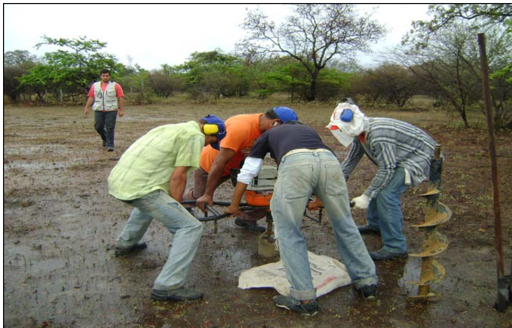
Figura 4: realização da sondagem ST-060
