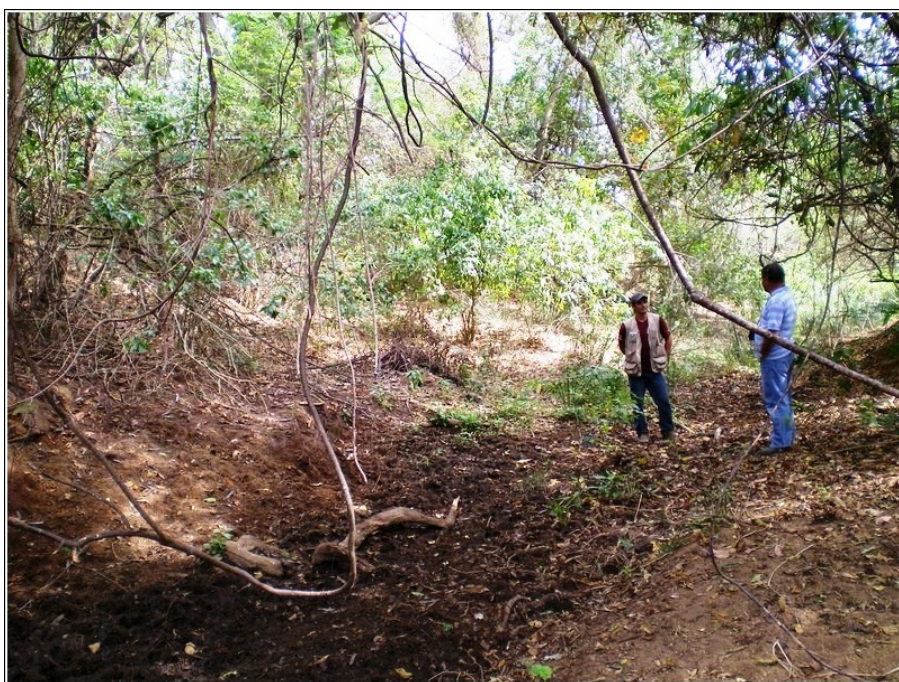
Figura 23: Interior da caixa do riacho das Antas – Vista de Jusante para montante
