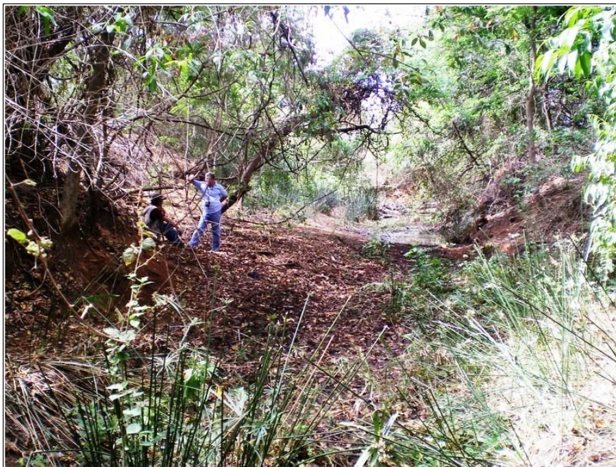
Figura 22: Interior da caixa Riacho das Antas – Vista de Montante para jusante
