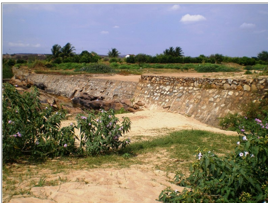
Figura 54: Barragem de Pedra no Rio Brumado – à montante
