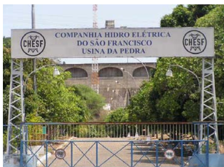
CHESF/Usina da Pedra – Jequié.
