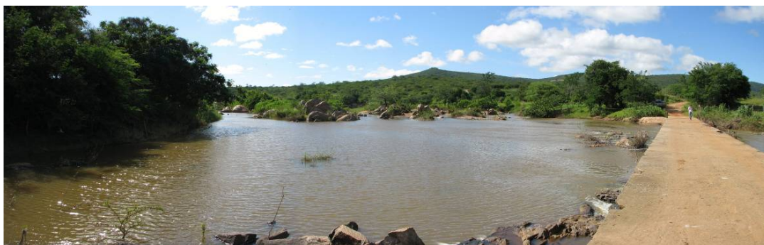
Jusante do ponto 95.
