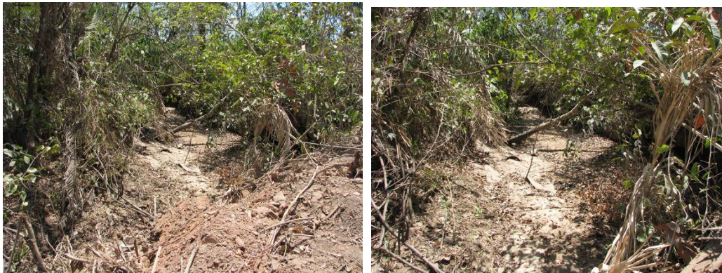
Montante e jusante do ponto 16.
