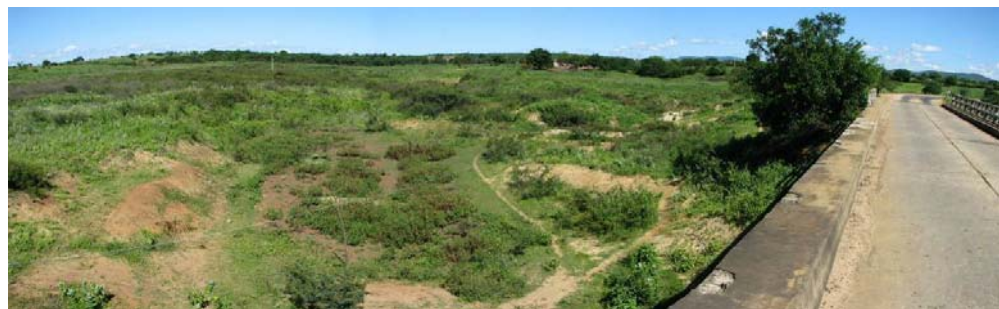
Jusante do ponto 91.
