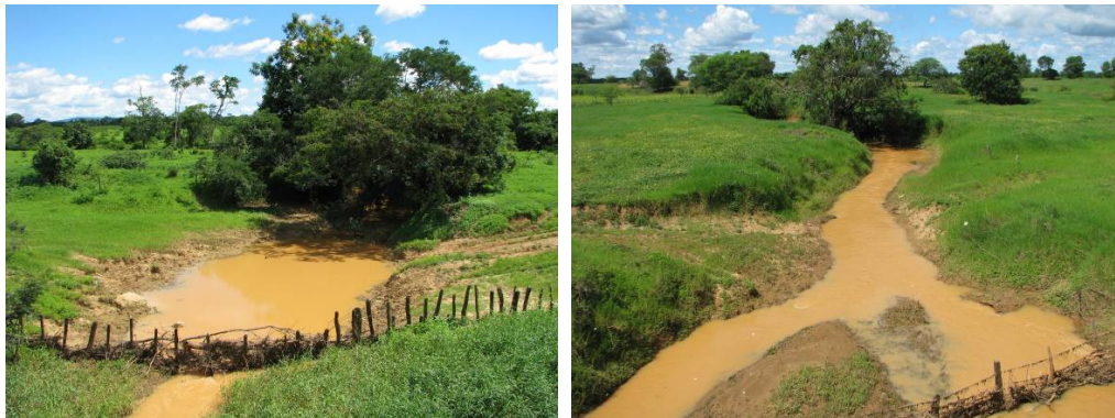
Montante e jusante do ponto 80
