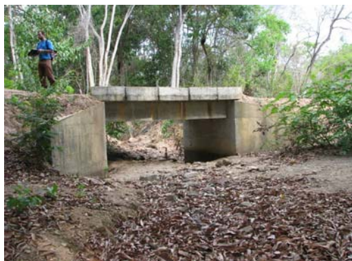
Vista da interceptação da estrada no ponto 23.
