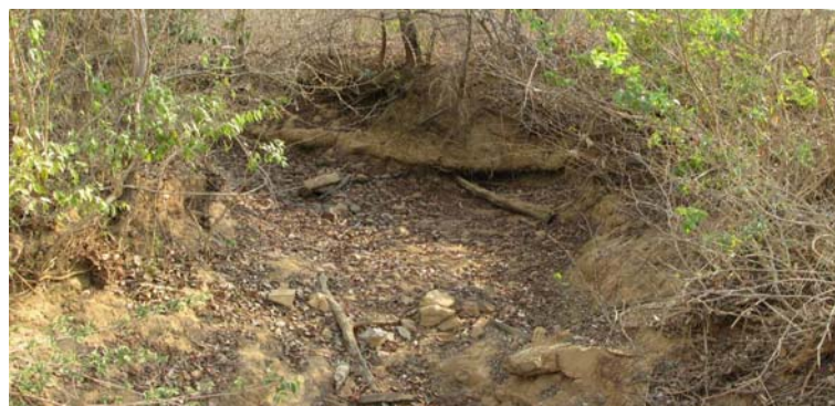
Jusante do ponto 65
