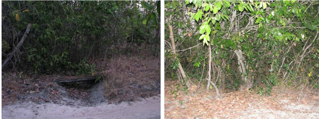
Montante e jusante do ponto 33.
