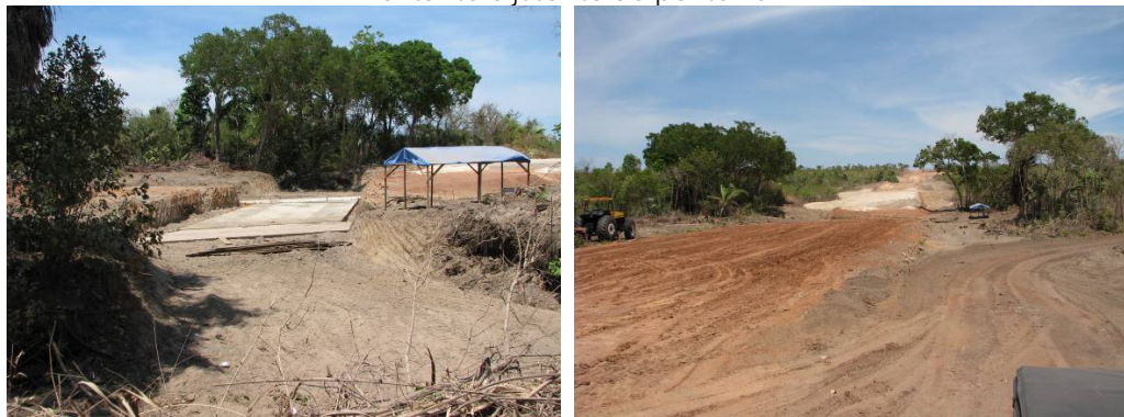
Obras para interceptação do córrego do ponto 16.
