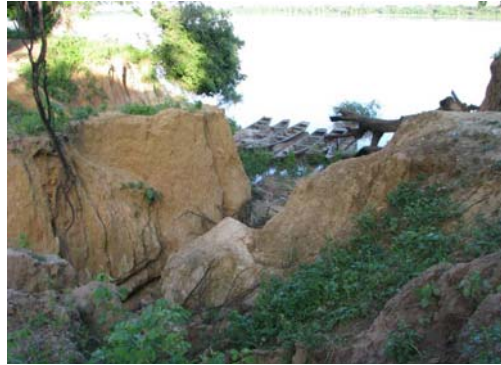
Ravina na margem esquerda, próxima ao ponto 82
