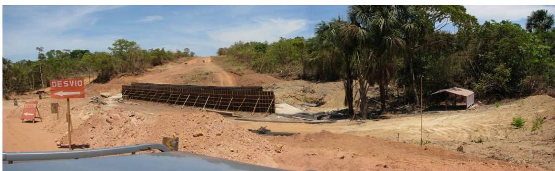
Construção de ponte na estrada que intercepta o ponto 15.
