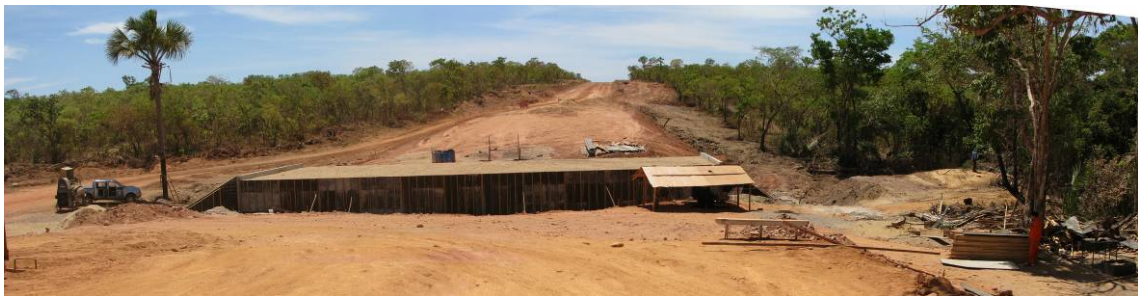
Ponte em construção da estrada que intercepta o rio do ponto 14.
