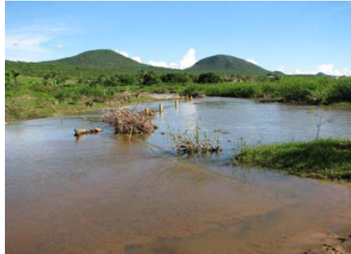
Ponte quebrada junto ao ponto 101.
