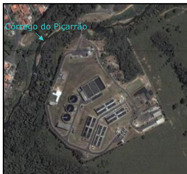
Figura 137 - Estação de tratamento de esgoto (ETE) do Piçarrão, em Campinas.
