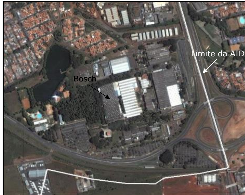
Figura 140 - Parque Industrial da Bosch, fabricante de eletrodomésticos, descarte de efluentes no Córrego da Boa Vista, em Campinas
