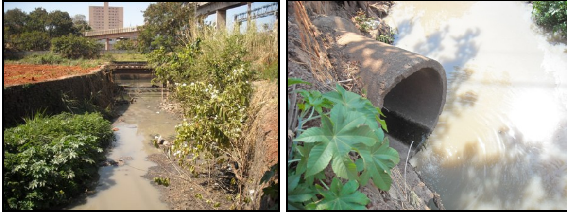
Figura 66 – Leito totalmente poluído e despejo de efluentes urbanos no afluente do Ribeirão do Tatu II.
