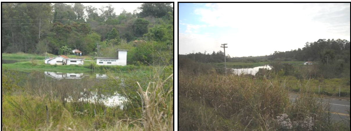
Figura 45 - Local da captação e tratamento de água do Município de Sumaré.
