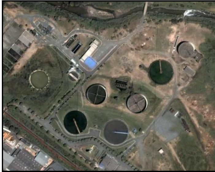
Figura 129 – Estação de tratamento de esgoto em Limeira, descarte de efluentes no Ribeirão do Tatu.
