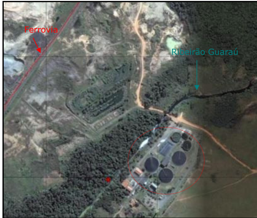
Figura 144 – Estação de tratamento de esgoto do Ribeirão Guaraú.
