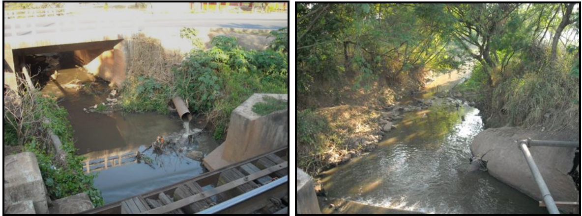
Figura 73 – Despejo de efluentes urbanos e vegetação de APP descaracterizada no córrego Pinheirinho, Município de Sumaré.
