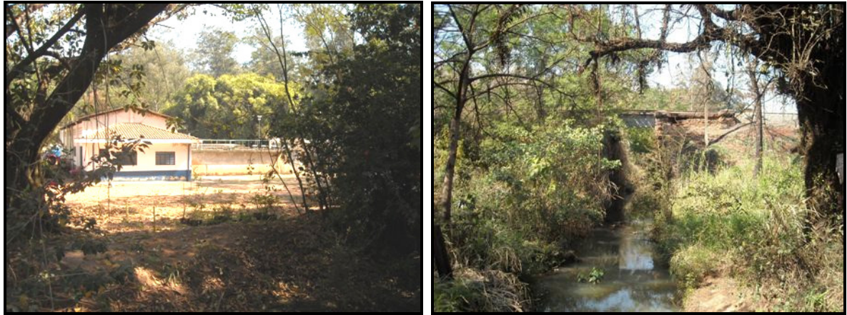
Figura 63 – Estação de Tratamento de Água do município de Santa Gertrudes e vegetação remanescente no entorno do córrego do Barreiro.
