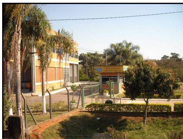
Figura 46 – SAAE Indaiatuba, captação do Córrego da Barrinha, localizado as margens da ferrovia.
