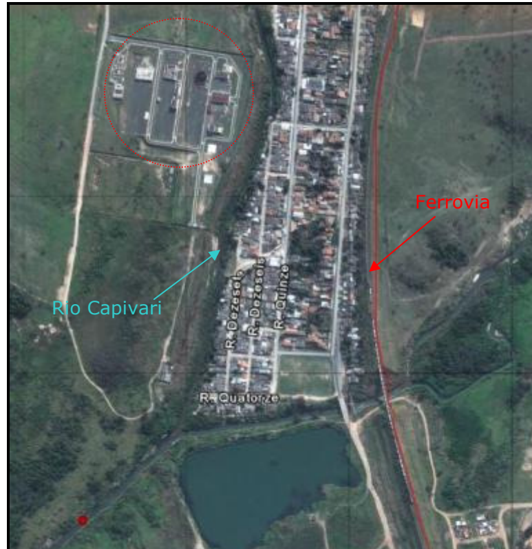
Figura 138 - Estação de tratamento de esgoto com descarte no Rio Capivari, em Campinas.
