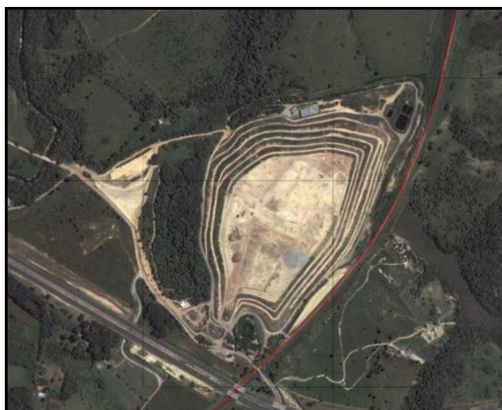
Figura 139 - Aterro sanitário ao lado da ferrovia em Campinas.
