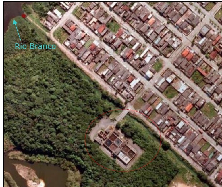
Figura 154 – Estação de tratamento de esgoto de Samaritá, em São Vicente, descarte do efluente final no Rio Branco.
