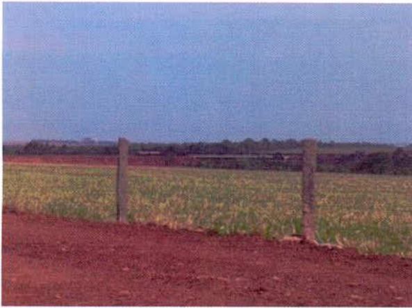
FIGURA 37 – Ponte sobre o Córrego Confusão ao fundo.
