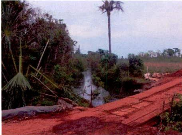
FIGURA 57 – Ponte de madeira implantada sobre o Córrego Cachoeira para a execução da ponte ferroviária.
