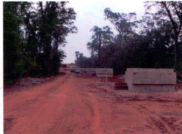
FIGURA 82 – Implantação da Ponte sobre o Ribeirão Ponte de Pedra I, encontro 1 (7 vãos). Notar pilares baixos e árvores de altura considerável.
