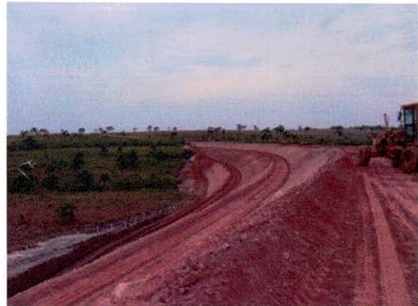
FIGURA 146 – Estacas 12.030 – 12.067: aterro de grandes dimensões em execução, sem início da hidrossemeadura – lado esquerdo.
