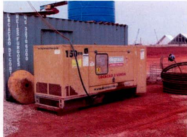
FIGURA 188 – Gerador e caixa d'água no canteiro de obras da Contern.
