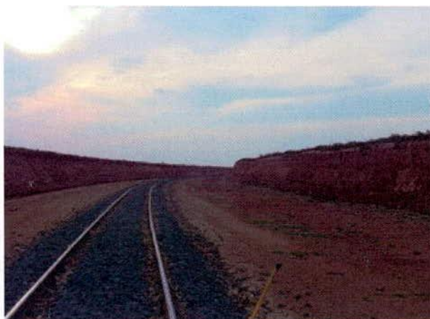
FIGURA 16 – Estaca 7405: corte (sem revegetação) com plataforma prevista para a futura implantação de pátio de cruzamento.
