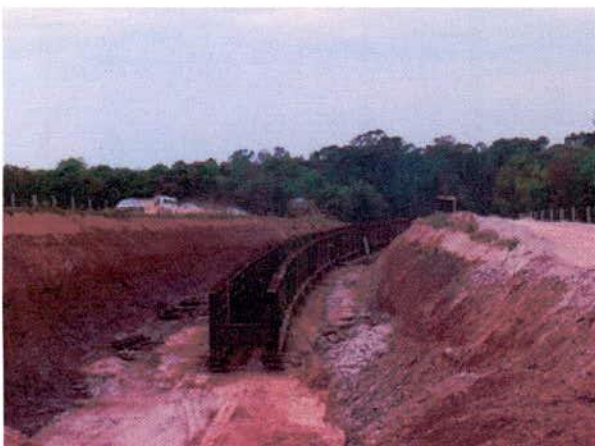
FIGURA 89 – Corte realizado para “empurrar” a estrutura metálica na cota correta da ponte.
