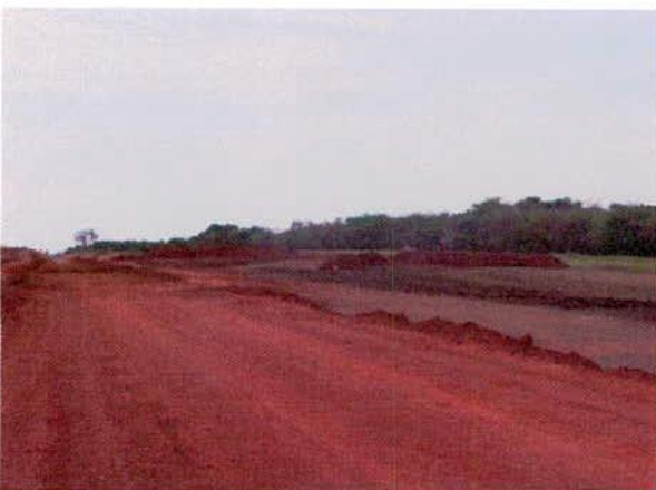
FIGURA 71 – Estaca 9900 (aprox.): área de “bota-espera” em área de terceiro.
