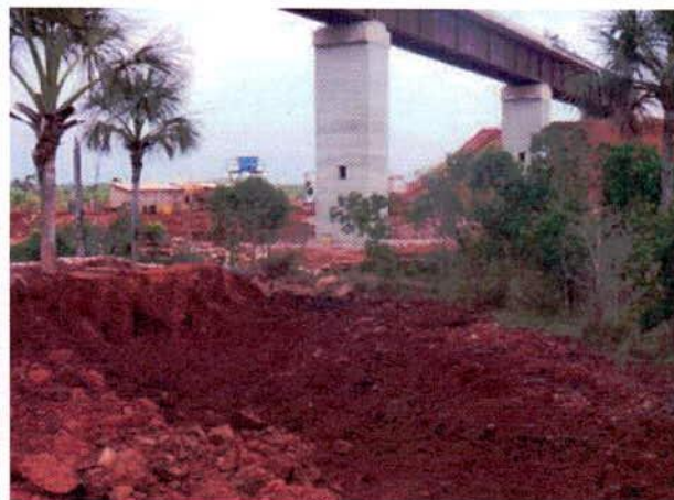
FIGURA 52 – Área com material já removido. Notar buritis parcialmente enterrados e elevação em relação ao terreno natural.
