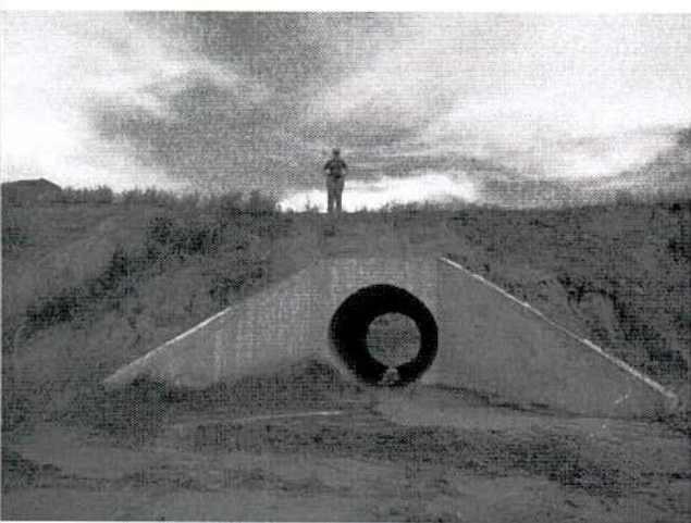
Ilustração 5: PF concluída, necessitando de revegetação.
