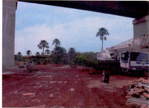
FIGURA 62 – Barracão de apoio (ao fundo) na APP do Córrego Cachoeira (próximo à margem).
