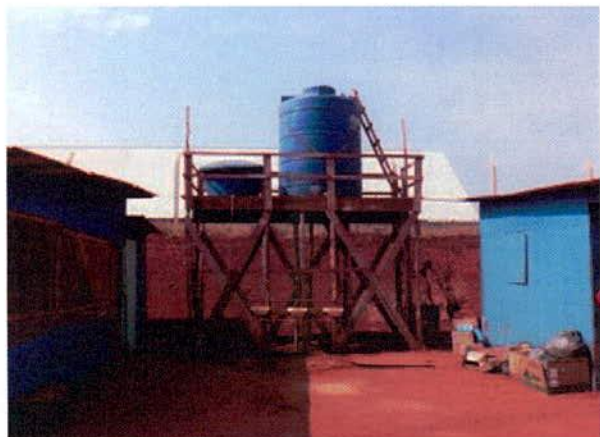
FIGURA 159 – Galpões e caixas d'água na área de apoio à implantação das telhas.
