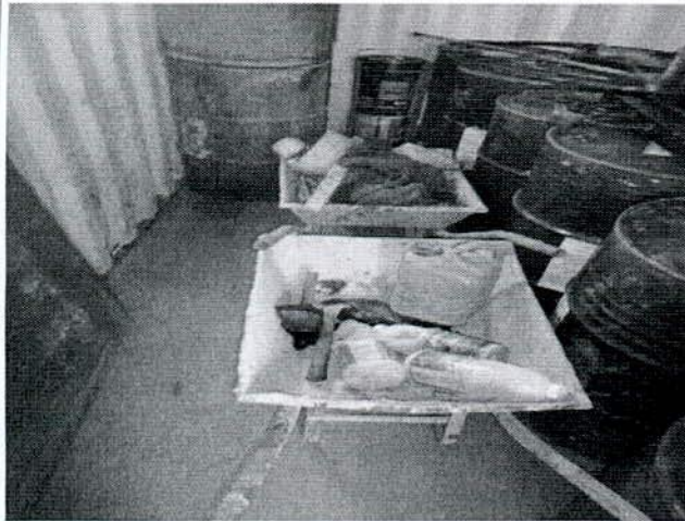
Ilustração 41: galões armazenados em local coberto e imperbalizado.
