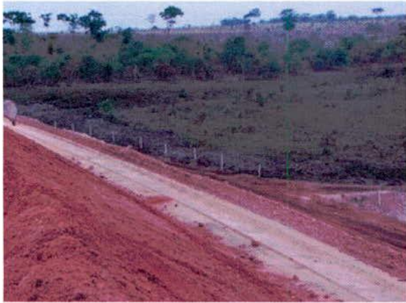
FIGURA 149 – Estaca 12.052: material oriundo da supressão de vegetação depositado fora da faixa de domínio – lado direito.
