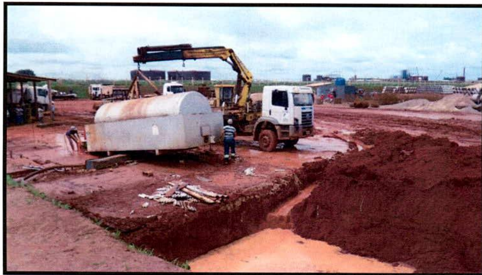
Retirada do Tanque de Abastecimento
