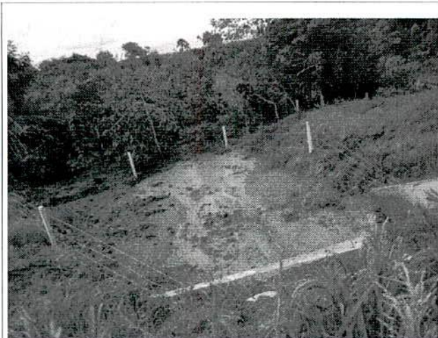
Ilustração 7: PF com cerca em instalação.
