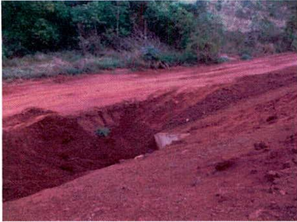
FIGURA 19 – Passagem de Fauna – PF em implantação na estaca 8346 – lado esquerdo. A PF será finalizada posteriormente, devido à utilização da estrada de serviço.
