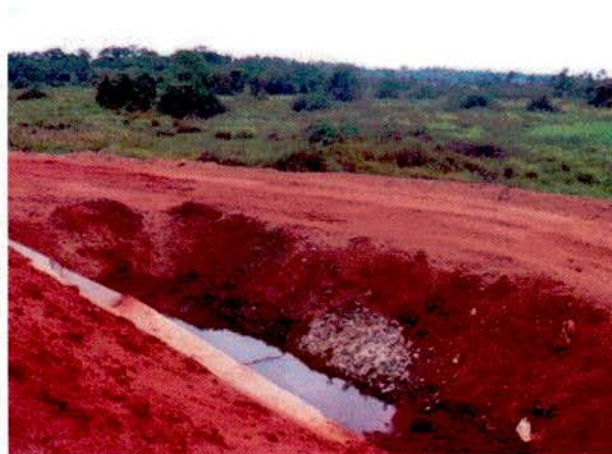
FIGURA 78 – Implantação de galeria (3X3m) na estaca 9930. Curso d'água temporariamente interrompido.
