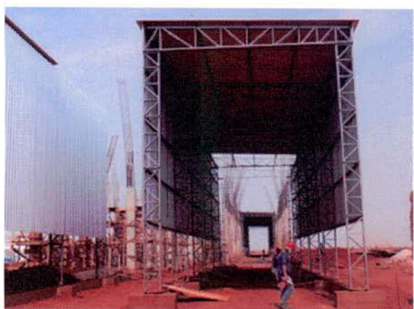
FIGURA 155 – Implantação das telhas de carregamento no Terminal de Rondonópolis (total de 5 telhas).
