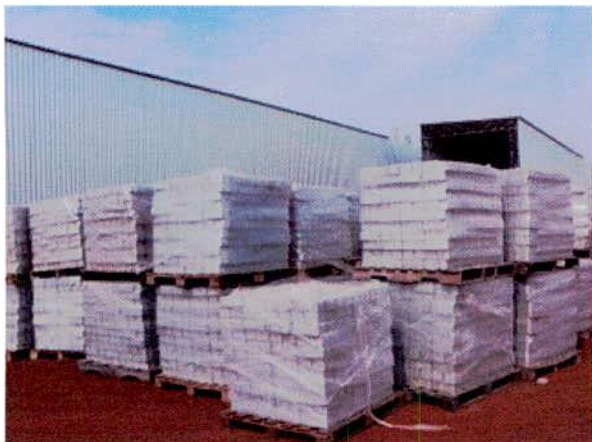
FIGURA 161 – Depósito de bloquetes de concreto para a pavimentação das áreas de trânsito de veículos leves.
