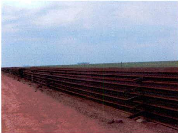
FIGURA 45 – “Pulmão” de trilhos não soldados no início do Segmento III.
