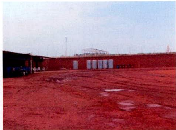
FIGURA 186 – Sanitários químicos e ambulatório no canteiro da Contern.
