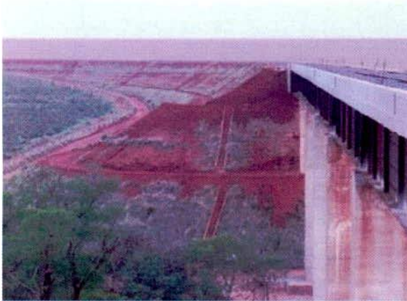
FIGURA 27 – Detalhe da revegetação não finalizada no encontro 1 da Ponte sobre o Rio Itiquira - lado direito ferrovia (sentido crescente do estaqueamento).
