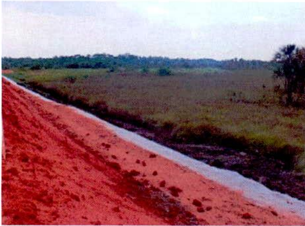
FIGURA 75 – Estaca 9918: aterro em várzea com aplicação de manta de “bidim” na base – lado direito.
