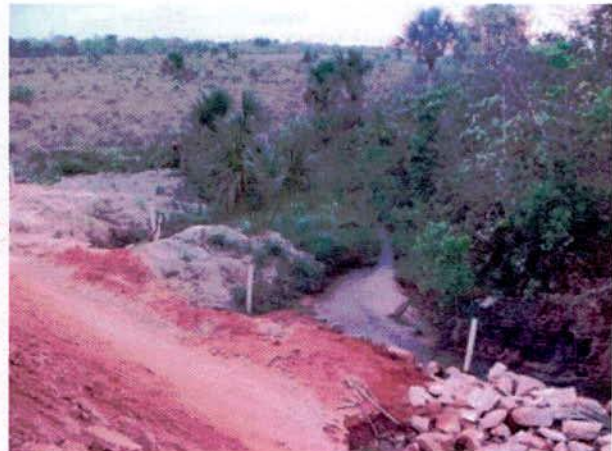
FIGURA 152 – Detalhe da existência de solo depositado além da cerca da ferrovia e assoreamento do curso d'água.
