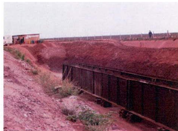
FIGURA 96 – Final do corte realizado para “empurrar” a estrutura metálica na cota correta da ponte e área de apoio ao fundo.
