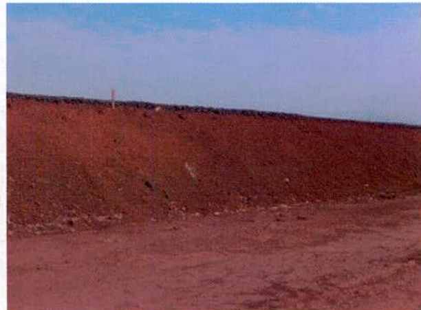
FIGURA 34 – Aterro recém finalizado e não revegetado.
