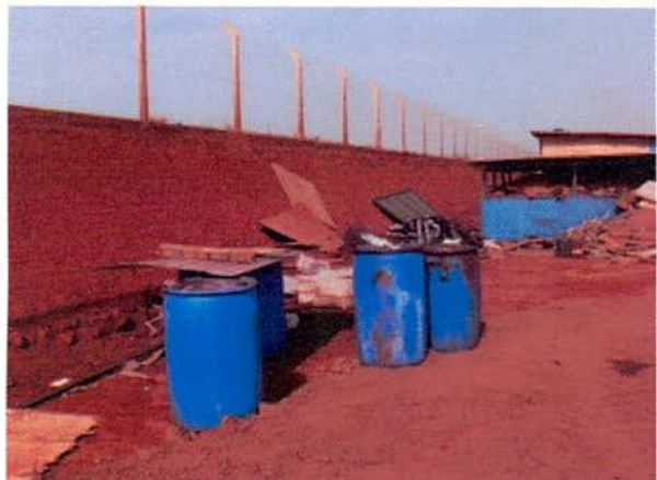
FIGURA 157 – Galões sem identificação contendo óleo diesel diretamente sobre o solo, sem isolamento, na área de apoio à implantação das telhas.
