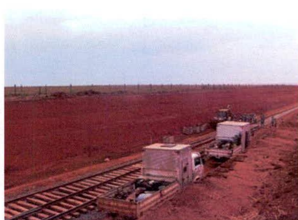
FIGURA 46 – Estaca 109.500: Pátio de Cruzamento. Aparelho de Mudança de Via – AMV em implantação.
