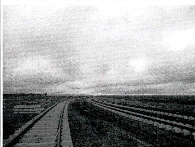
Ilustração 28: superestrutura do acesso ao terminal instalada.
