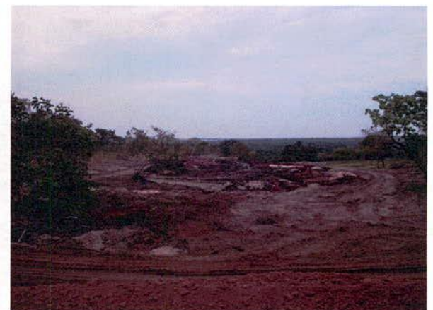
FIGURA 142 – Estaca 11.579: material excedente utilizado para corrigir processo erosivo em área de terceiro.
