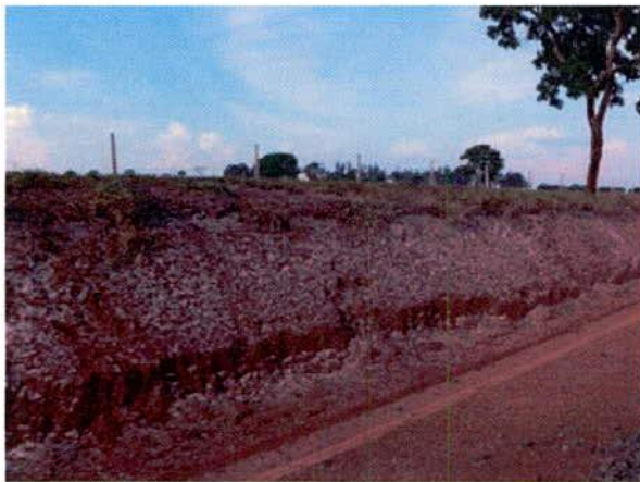
FIGURA 09 – Talude de corte com hidrossemeadura recém efetuada.
