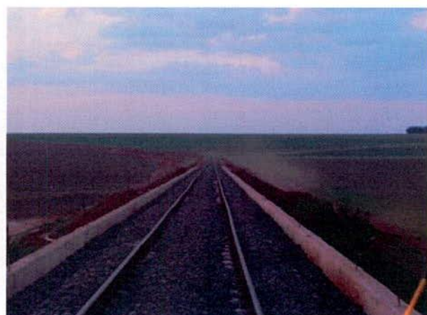
FIGURA 24 – Ponte sobre o Rio Itiquira. Infraestrutura e superestrutura ferroviárias finalizadas.
