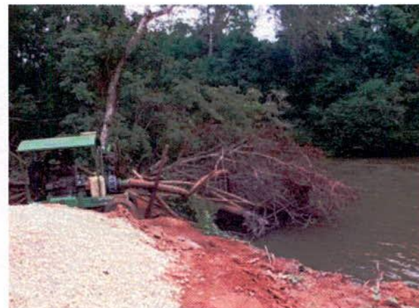
FIGURA 84 – Captação de água no Ribeirão Ponte de Pedra I, encontro 1.
