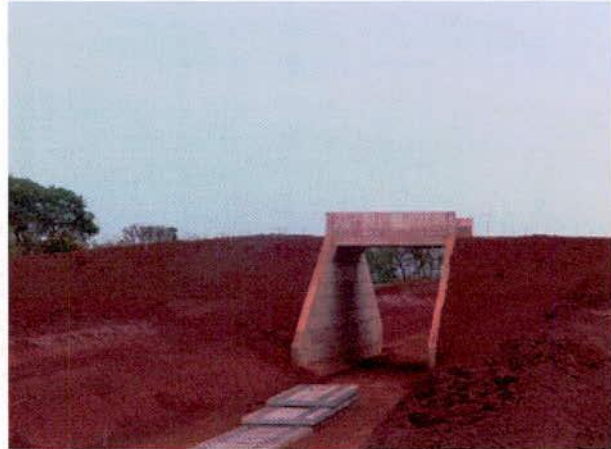
FIGURA 68 – Estaca 9588: Passagem Superior – PS rodovia MT-370.
