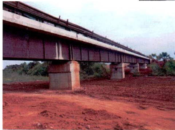
FIGURA 38 – Ponte sobre o Córrego Confusão – 5 vãos.
