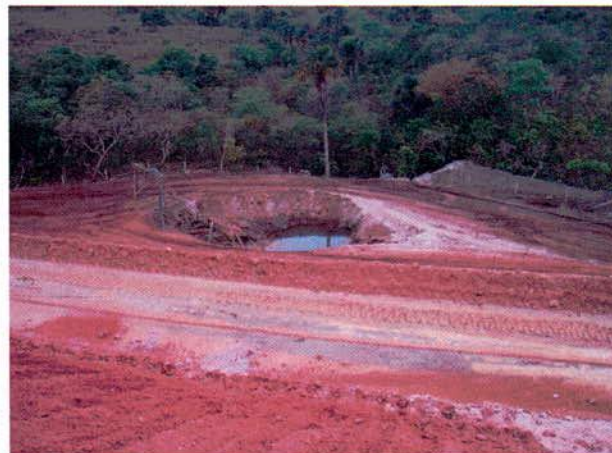
FIGURA 148 – Galeria em implantação na estaca 12.051, lado direito. Água represada temporariamente.
