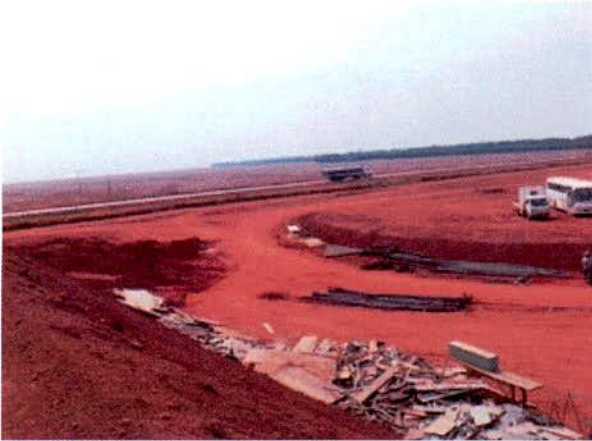
FIGURA 169 – BR-163 e área de apoio às obras do acesso rodoviário ao terminal observados a partir do final da pera ferroviária.
