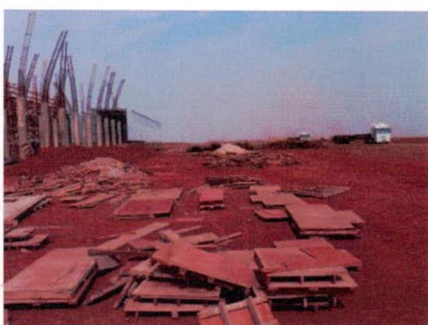
FIGURA 156 – Deposição de material utilizado para a implantação das telhas.
