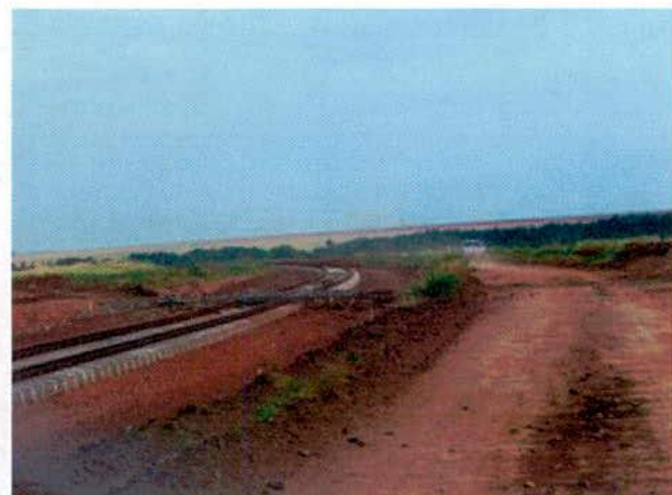
FIGURA 36 – Passagem em Nível na Fazenda Liberdade – estaca 109.238.
