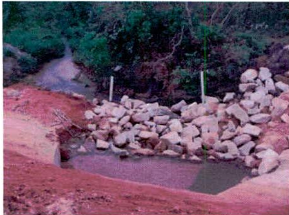
FIGURA 151 – Saída da galeria em implantação na estaca 12.051, lado esquerdo. Enrocamento executado para diminuir velocidade da água e evitar erosão.
