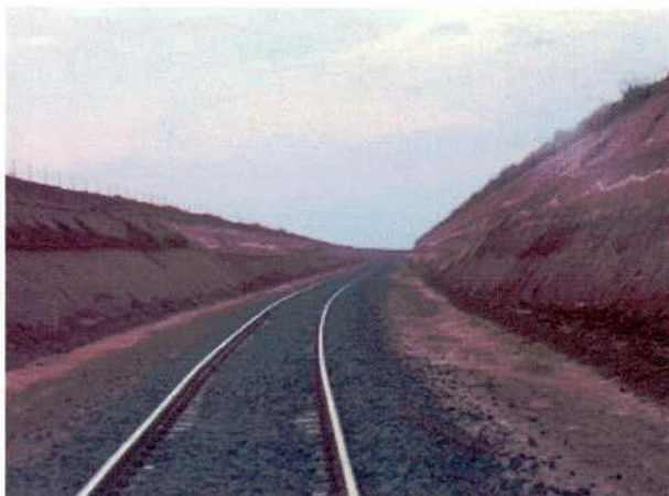
FIGURA 14 – Estaca 7073: hidrossemeadura ainda não efetuada.
