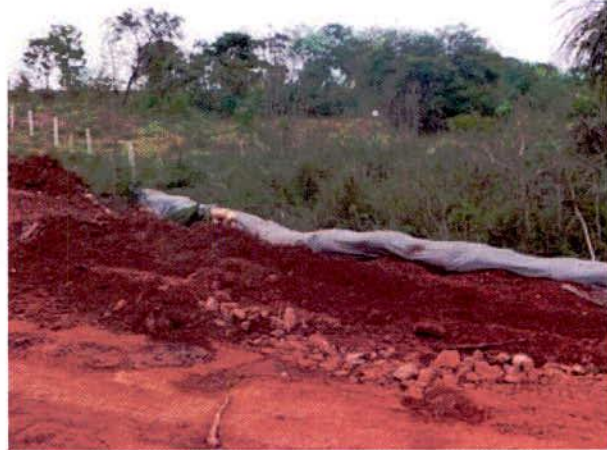
FIGURA 56 – Manta de geotêtil não-tecido (“bidim”) disposta para evitar processo erosivo e assoreamento.
