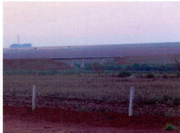
FIGURA 22 – Ponte sobre o Rio Itiquira observada a partir da estaca 8472.
