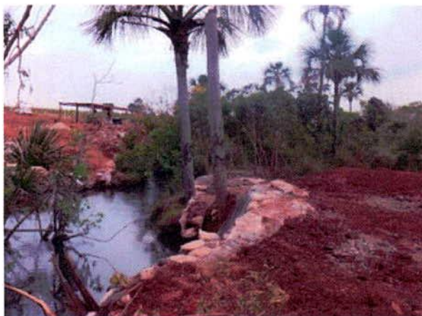
FIGURA 53 – Sacaria disposta na margem do Córrego Cachoeira para evitar assoreamento – encontro 1.
