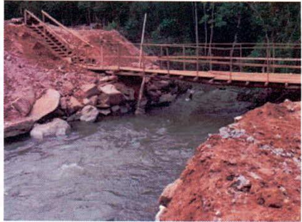
FIGURA 86 – Enrocamento executado na calha natural do Ribeirão Ponte de Pedra I para o encabeçamento da ponte.
