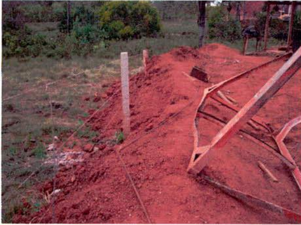
FIGURA 67 – Solo extrapolando a cerca da ferrovia. Notar elevação em relação ao terreno natural.
