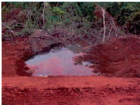
FIGURA 107 – Detalhe da saída da galeria – lado direito.
