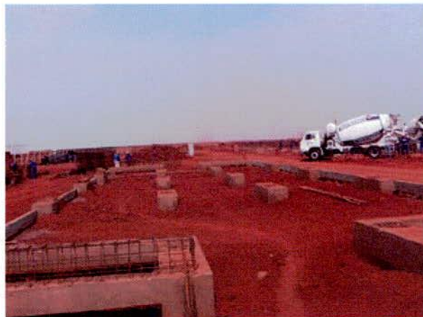
FIGURA 162 – Implantação das 2 “balanças de pesagem de saída” no lote da ALL no terminal.
