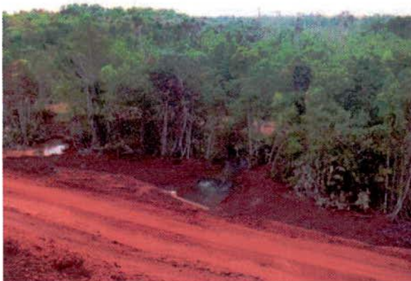
FIGURA 101 – Saída do lado direito da galeria.
