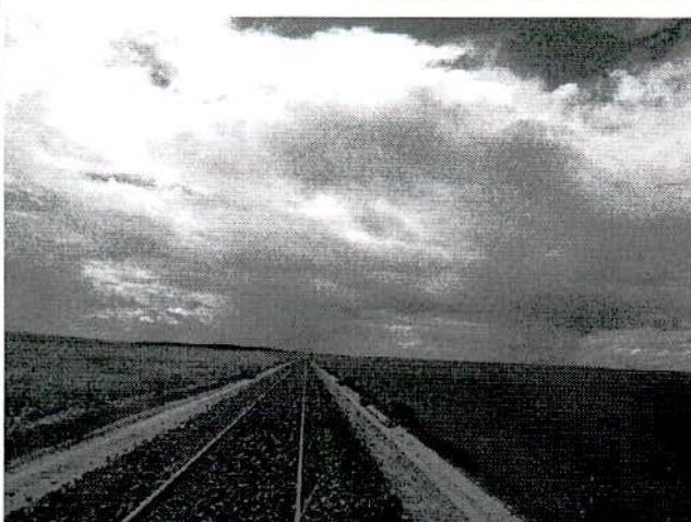
Ilustração 27: trecho da ferrovia que intercepta a Fazenda Verdura.
