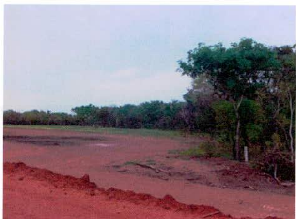
FIGURA 72 – Estaca 9900 (aprox.): área de “bota-espera” em área de terceiro. Notar mourão de concreto limite da ferrovia à direita.
