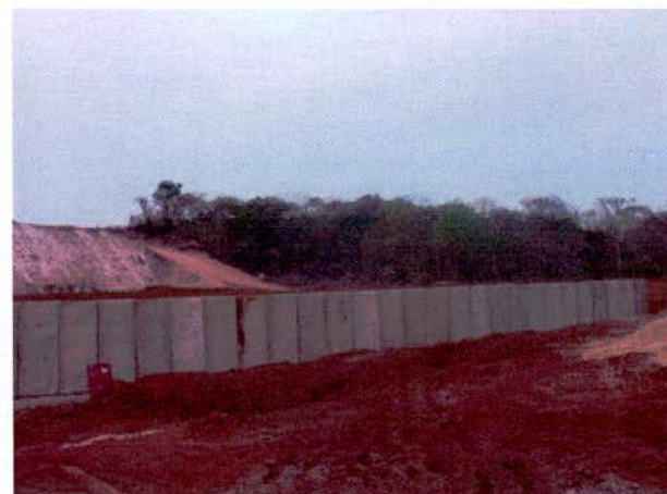
FIGURA 114 – Galeria de 2X2m em implantação na estaca 10.888.
