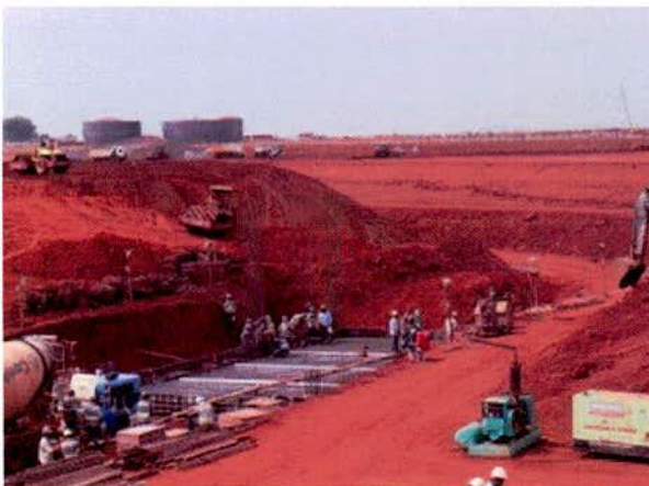
FIGURA 171 – Concretagem da base do viaduto e terraplenagem para execução dos encontros.
