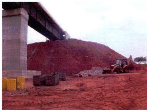
FIGURA 48 – Aterro do encontro 1 da Ponte sobre o Córrego Cachoeira não finalizado e revegetado – lado esquerdo da linha.
