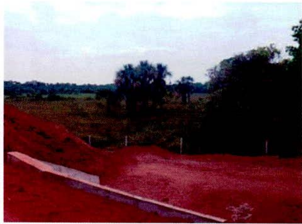
FIGURA 74 – Passagem de Gado – PG na estaca 9915 – lado direito da linha.
