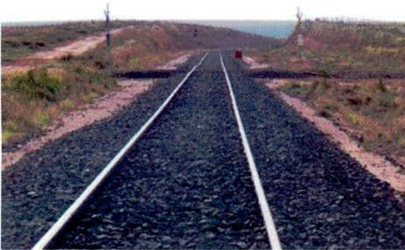
FIGURA 03 – Estaca 5989: 1ª Passagem em Nível – PN do Segmento II-3.
