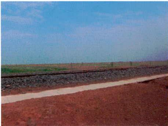
FIGURA 33 – Estaca 108.980: trecho plano no início do Segmento III.
