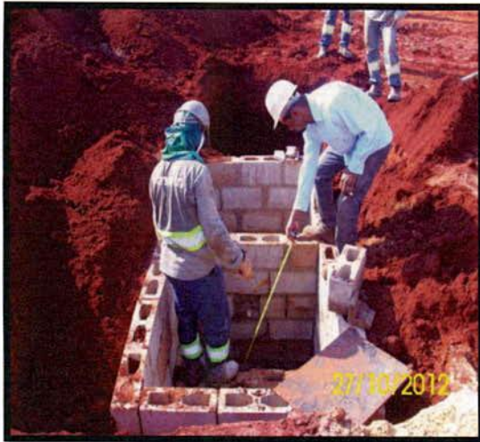
Construção do SAO
