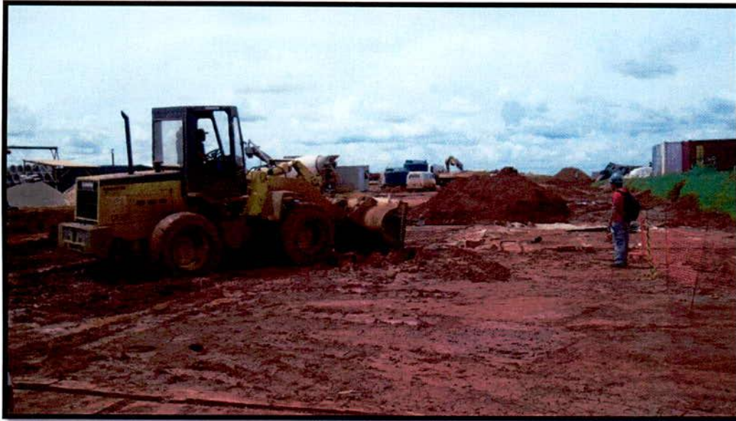
Remoção de Resíduos da Área de Abastecimento
