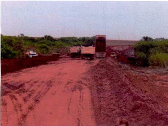
FIGURA 111 – Implantação de galeria na estaca 10.590 (PF na estaca 10.585 não iniciada).
