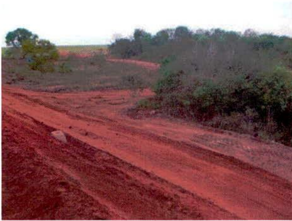
FIGURA 103 – Passagem de Fauna em implantação na estaca 10.191, final do fragmento de vegetação – lado direito.
