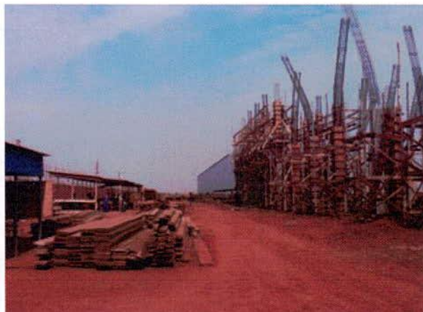
FIGURA 160 – Telhas em implantação e carpintaria da área de apoio.
