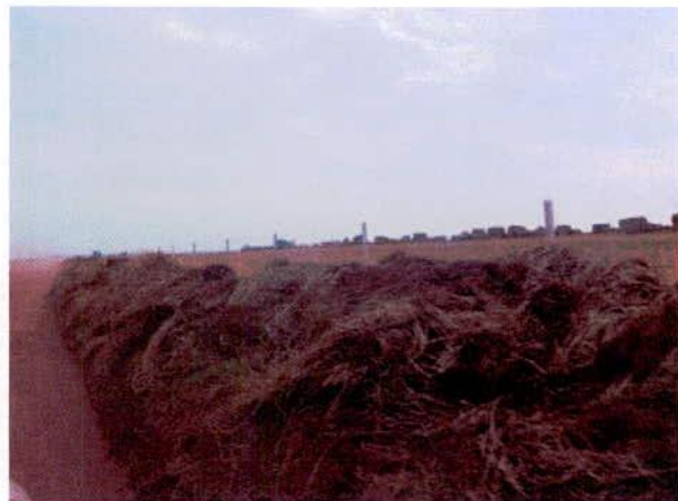
FIGURA 70 – Restos de vegetação não removidos após a abertura da estrada de serviço.
