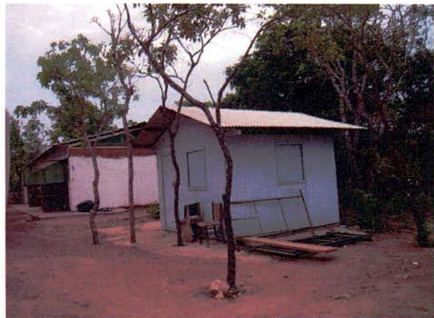
FIGURA 124 – Barracões de apoio às obras de implantação da Ponte sobre o Ribeirão Ponte de Pedra II.
