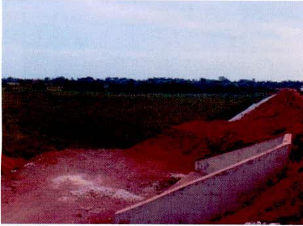
FIGURA 73 – Passagem de Gado – PG na estaca 9915 – lado esquerdo. Início de grande área de várzea.
