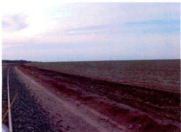
FIGURA 15 – Trecho que intercepta a Fazenda Verdura sem cercamento e com plantio na faixa de domínio – estaca 7230.
