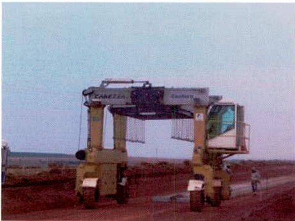
FIGURA 69 – Estaca 9741: pórtico lançador de dormentes.
