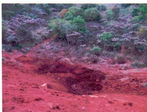
FIGURA 18 – Passagem de Fauna – PF em implantação na estaca 8346 – lado direito. Faltam remoção do solo excedente, reconformação do terreno e revegetação.
