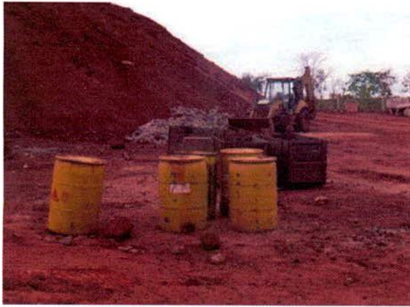
FIGURA 49 – Tambores contendo aditivo para concreto (Sika® ViscoCrete® 3535 CB) dispostos diretamente sobre o solo.
