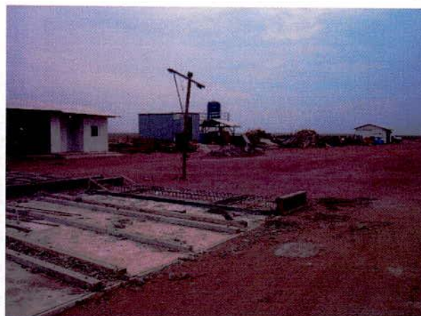
FIGURA 132 – Canteiro de pré-moldados de concreto instalado entre as Pontes sobre o Ribeirão Ponte de Pedra II e III.
