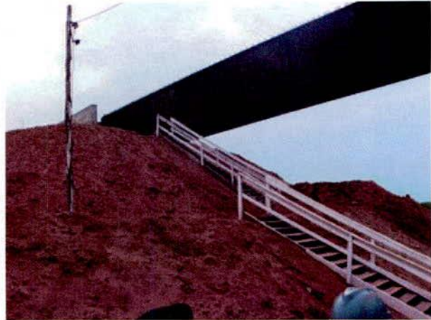
FIGURA 116 – Encontro 1 da Ponte sobre o Ribeirão Ponte de Pedra II ainda não finalizado e revegetado.
