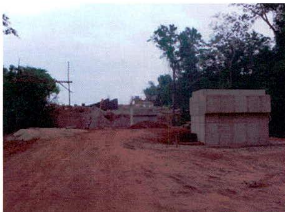
FIGURA 83 – Implantação da Ponte sobre o Ribeirão Ponte de Pedra I, encontro 1, próximo à calha natural do curso d'água.
