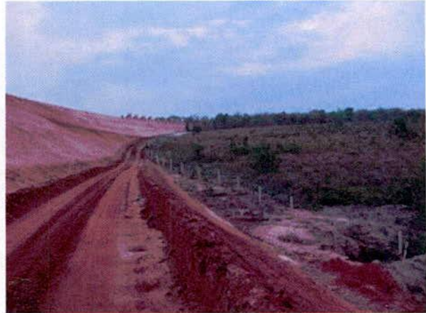
FIGURA 150 – Aterro estacas 12.030 – 12.067 observado da base – lado esquerdo da ferrovia.
