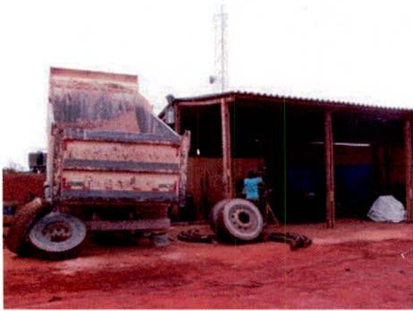
FIGURA 185 – Oficina de manutenção leve de veículos no canteiro de obras da Contern, sem isolamento com canaletas.
