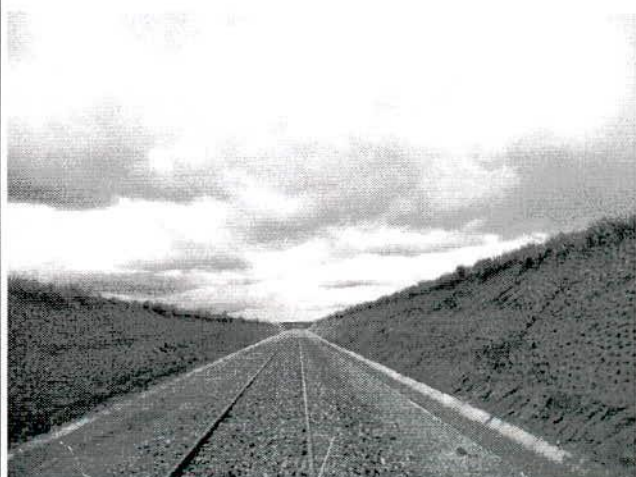
Ilustração 12: coveamento realizado, aguardando a aplicação de hidrosseadura.
