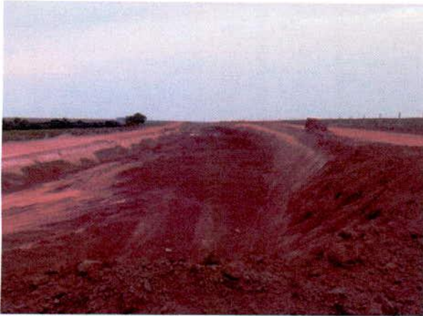
FIGURA 97 – Corte recém-aberto após a Ponte sobre o Ribeirão Ponte de Pedra I.
