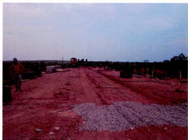
FIGURA 120 – Encontro 2 da Ponte sobre o Ribeirão Ponte de Pedra II.
