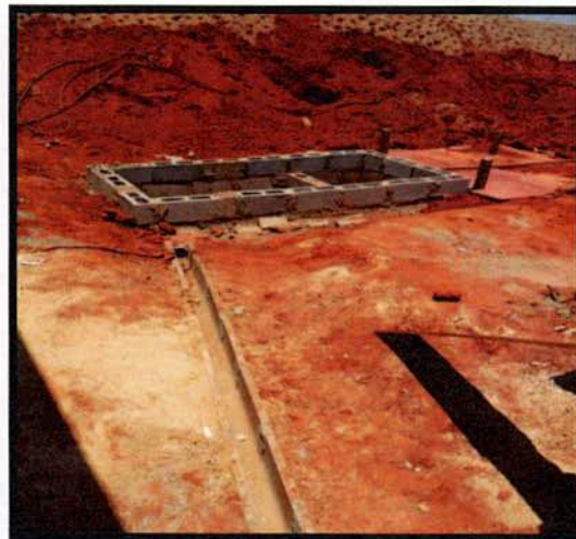
SAO executado – Canaletas da Impermeabilização
