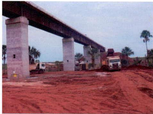
FIGURA 50 – Visão geral das obras de implantação da Ponte sobre o Córrego Cachoeira. Notar grande intervenção em APP.
