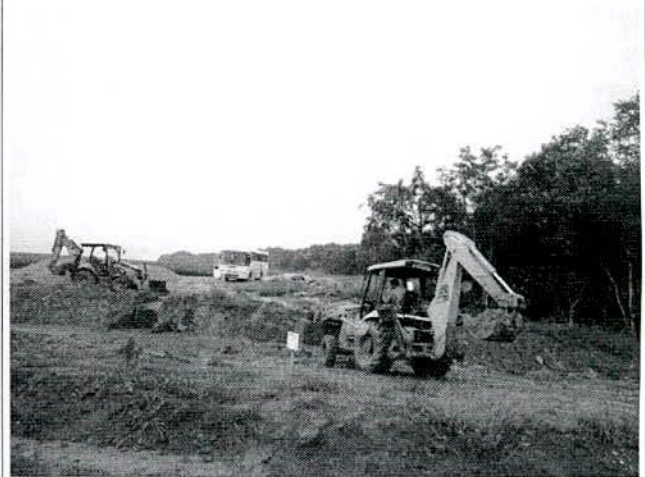
Ilustração 22: Maquinas trabalhando na reconformação de talude da OAE sobre o Riacho Ponte de Pedra 1.
