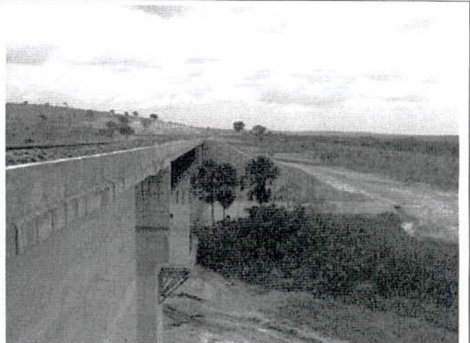
FIGURA 116 – Pouca intervenção na APP da estaca 3178. Notar buritis intactos sob a ponte.
