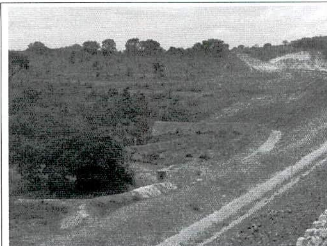
FIGURA 127 – Reconformação e revegetação na estaca 1222 – local de execução de aterro em terra armada.
