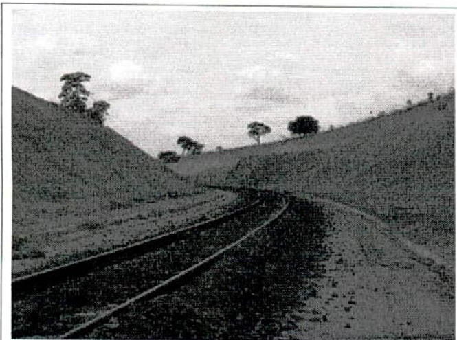
FIGURA 109 – Trecho com lastro já disposto.
