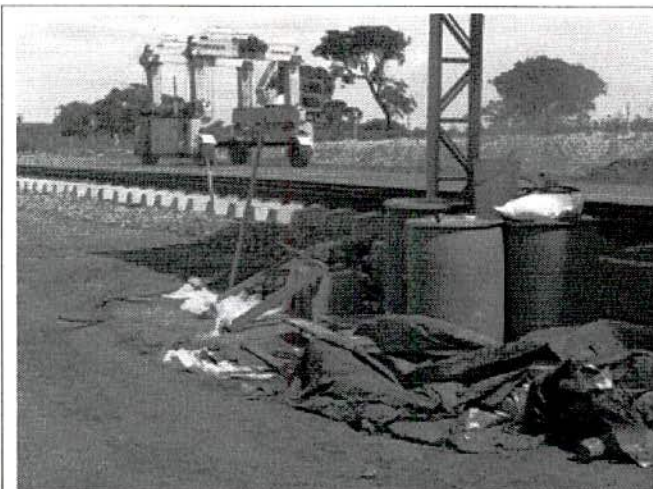
FIGURA 79 – Bombonas plásticas contendo aditivo surfactante irregularmente dispostas à céu aberto, bem como resíduos sólidos (madeira, plástico e “entulho”).
