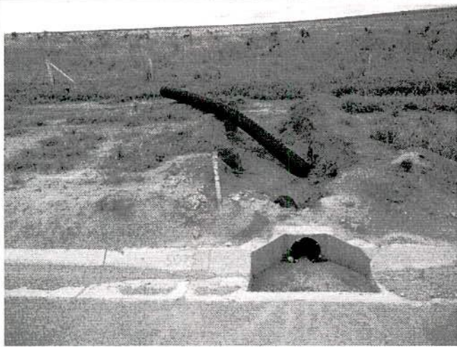
FIGURA 91 – Desobstrução dos bueiros.
