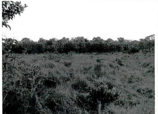
FIGURA 20 – Eixo da ferrovia na estaca 1195–proximidades do encontro 2 da Ponte sobre o Rio Ponte de Pedra II.
