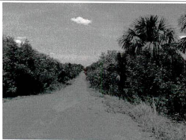
FIGURA 35 – Eixo da ferrovia paralelo à direita da estrada – estaca 10190.
