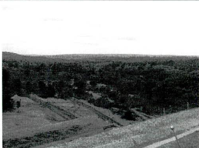
FIGURA 104 – Ponte estaca 4290 – canteiro já foi desmobilizado.
