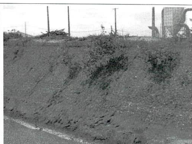
FIGURA 84 – Detalhe da hidrossemeadura já realizada.
