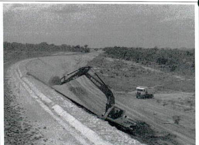
FIGURA 120 – Trecho com substituição das caixas de concreto das descidas d'água (foram subdimensionadas).
