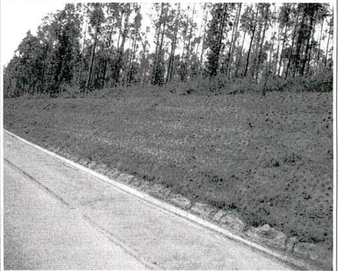
FIGURA 92 – Talude revegetado.
