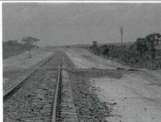
FIGURA 119 – Passagem em Nível – Ponto 144 GPS.
