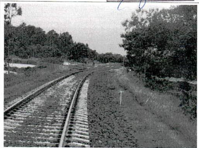
FIGURA 134 – PN com a rodovia MT-299 no Segmento 1 – Ponto 173 GPS.
