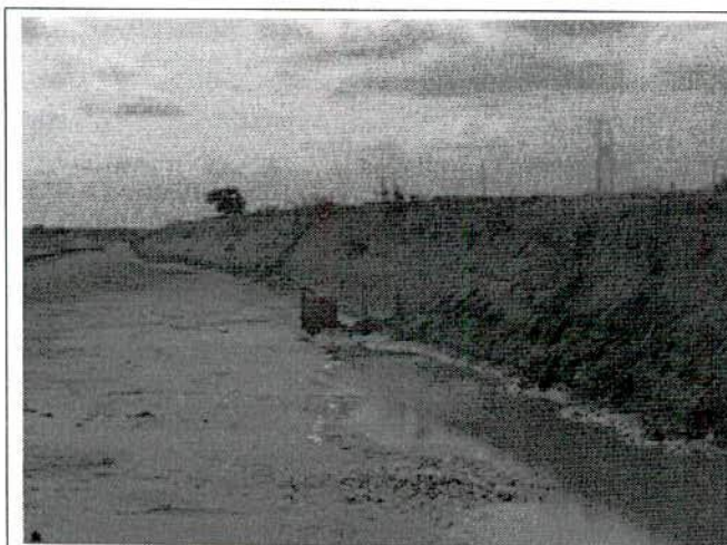
FIGURA 83 – Hidrossemeadura já realizada.
