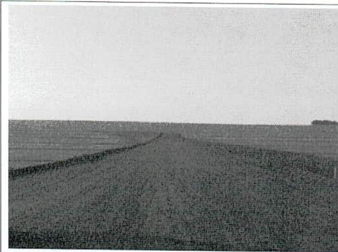
FIGURA 63 – Plataforma ferroviária na chegada à Ponte sobre o Rio Itiquira – vista oposta.
