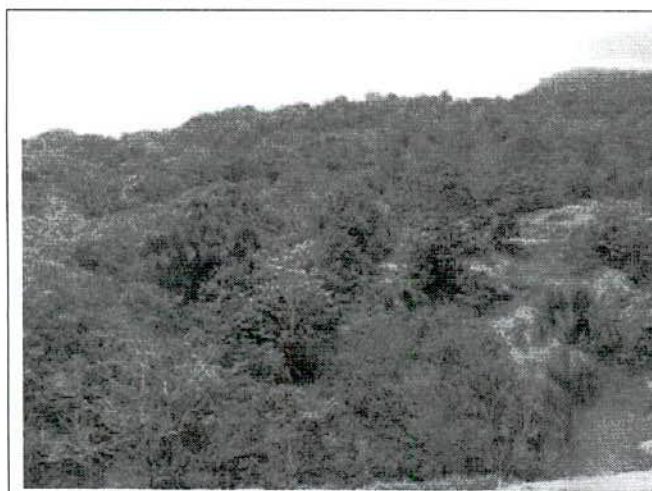
FIGURA 131 – Estaca 992 – local de execução de aterro em terra armada.
