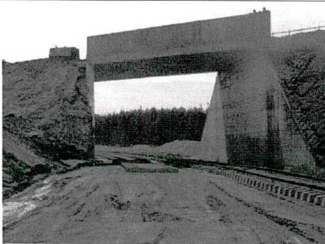
FIGURA 71 – Passagem Superior rodoviária no futuro Pátio de Cruzamento de Itiquira – chegada ao terminal.
