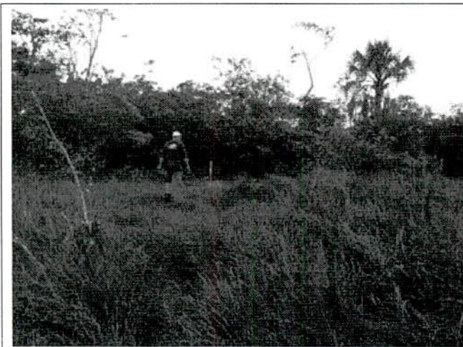
FIGURA 09 – Local onde será implantado o encontro 2 da Ponte sobre o Rio Ponte de Pedra III – estaca 11296+11,30.
