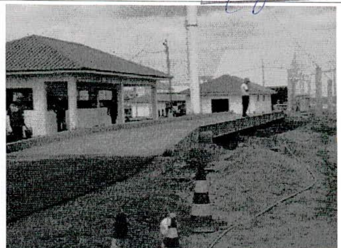
FIGURA 86 – Balança de pesagem de caminhões na entrada do Terminal de Itiquira e área administrativa ao lado.
