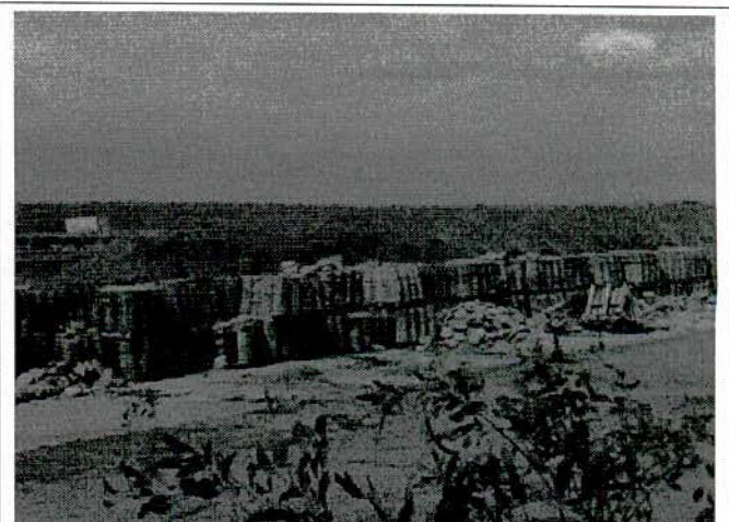
FIGURA 72 – Blocos intertravados de concreto para pavimentação das vias internas do Terminal de Itiquira.
