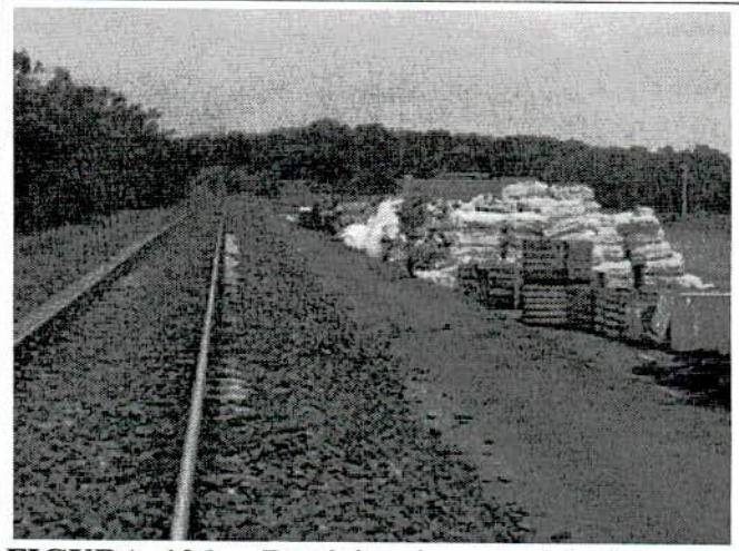
FIGURA 136 – Depósito de materiais (grampos de fixação) no pátio da fábrica de dormentes.
