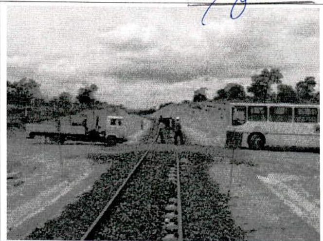
FIGURA 122 - Passagem em Nível - Ponto 155 GPS. Solda de trilhos em execução.
