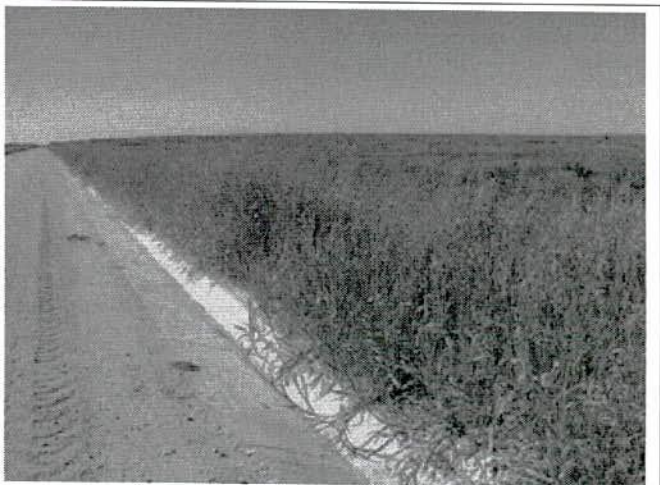
FIGURA 30 – canaletas implantadas e hidrossemeadura já executada na estaca 5005.
