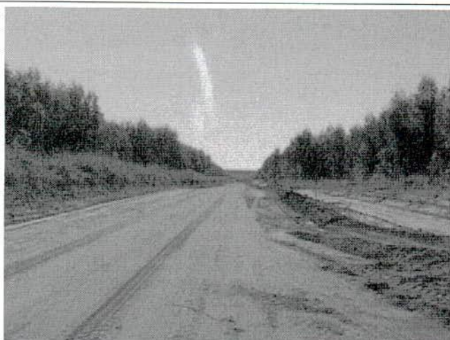
FIGURA 23 – Plataforma parcialmente finalizada na estaca 5599. Taludes já foram revegetados.
