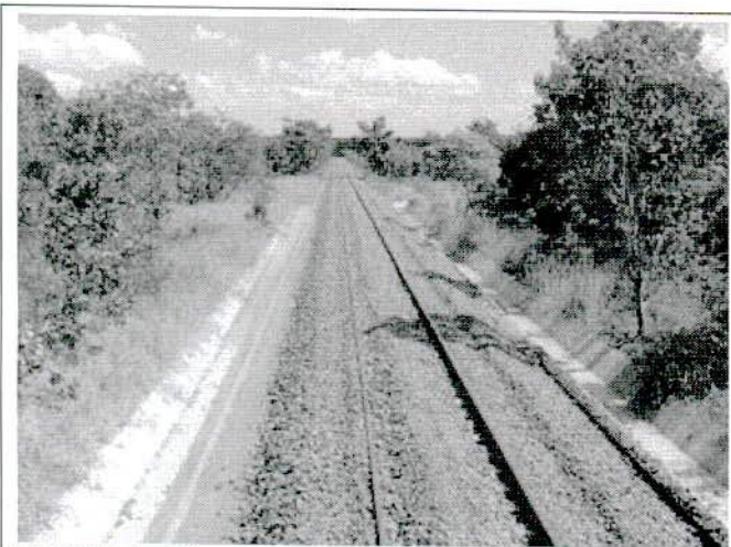
FIGURA 81 – Segmento I: canaletas de drenagem de concreto implantadas nas saídas de cortes – estaca 410.
