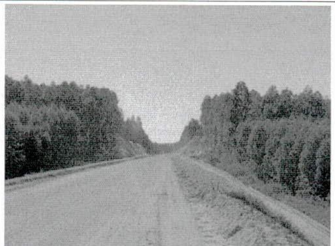
FIGURA 24 – Aterro e corte (já revegetados) em meio à eucaliptal – estaca 5488
