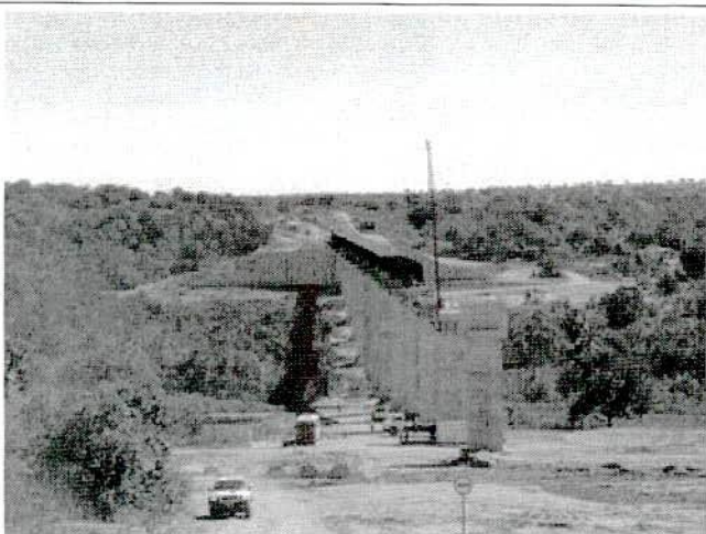
FIGURA 51 – Obras de implantação da ponte da estaca 4182 – visão oposta.
