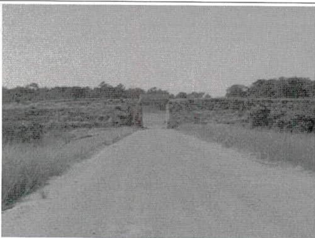
FIGURA 41 – PS implantada na estaca 4365 vista da plataforma ferroviária.
