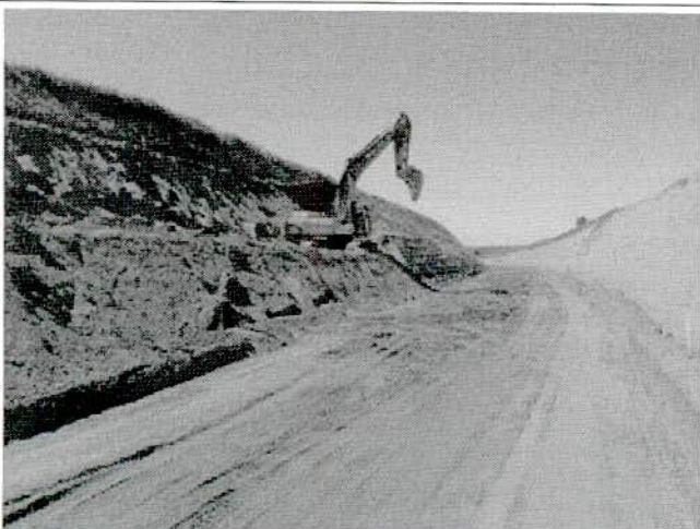
FIGURA 53 – Execução de corte na estaca 3848.
