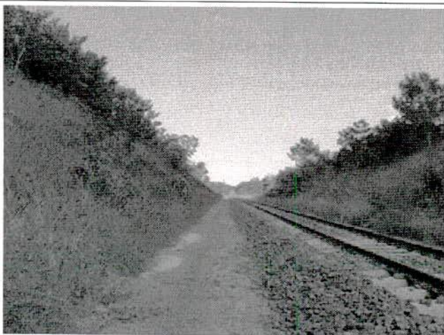
FIGURA 65 – Segmento I: taludes revegetados na estaca 107.
