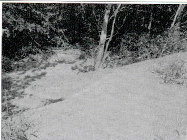
FIGURA 71 – Segmento I: processo erosivo na estaca 131, lado esquerdo. Neste ponto será incrementada a revegetação.
