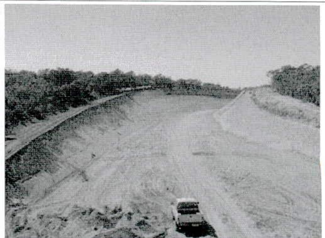
FIGURA 44 – Trecho com plataforma em implantação visto a partir da PS (est. 4365) – sentido decrescente do estaqueamento.
