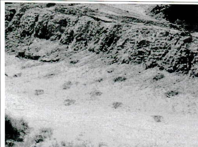
FIGURA 93 – Plantio de mudas e hidrossemeadura (estacas 981 a 992), lado direito da linha.
