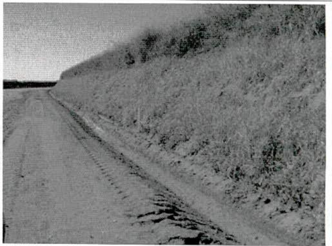
FIGURA 28 – Canaletas de drenagem em início de implantação – estaca 5170.
