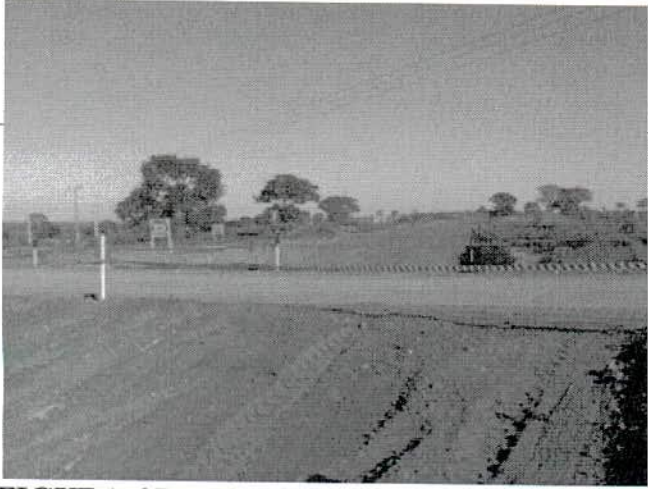
FIGURA 07 – Plataforma dupla (futuro Pátio de Itiquira) já implantada.
