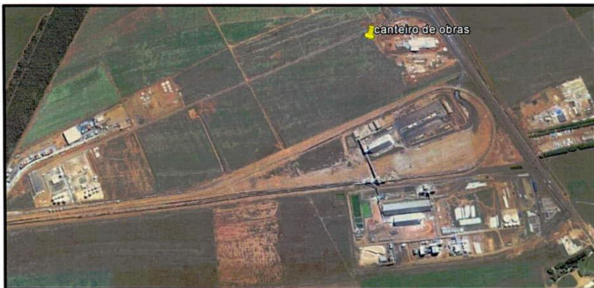
Figura 1 - Canteiro de obras localizado dentro do Complexo Intermodal de Rondonópolis.
