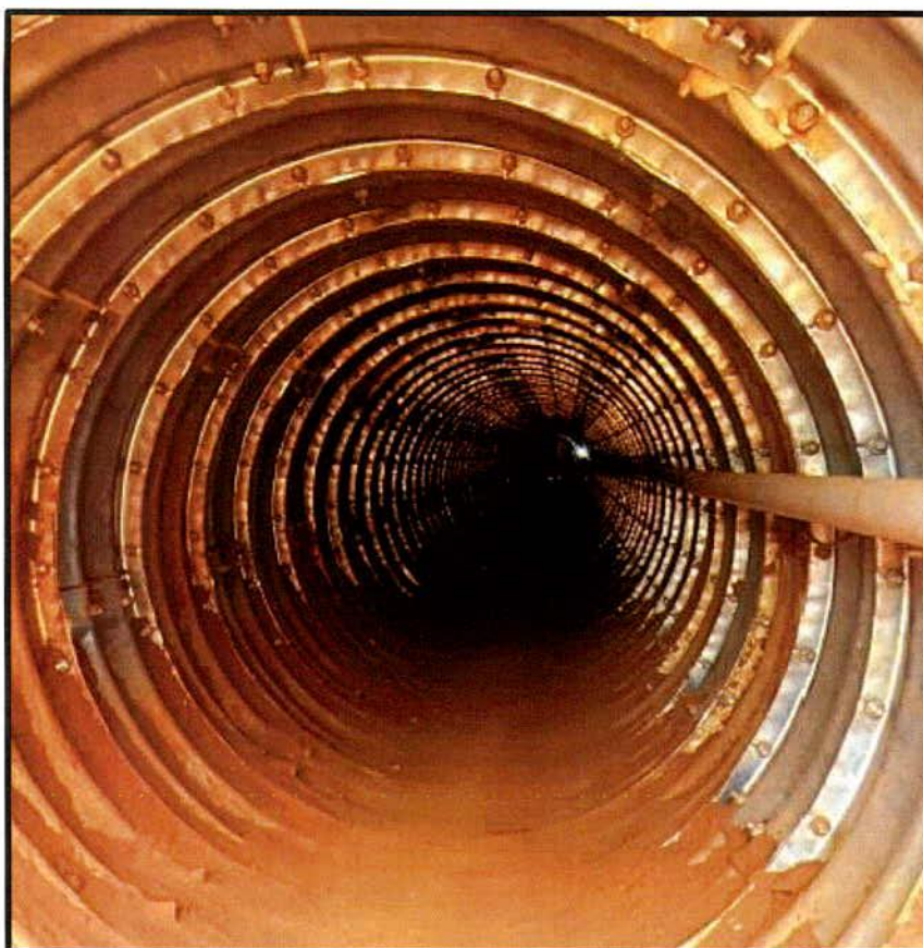
Foto 2 – Implantação de tubo metálico do tipo túnel linear.
