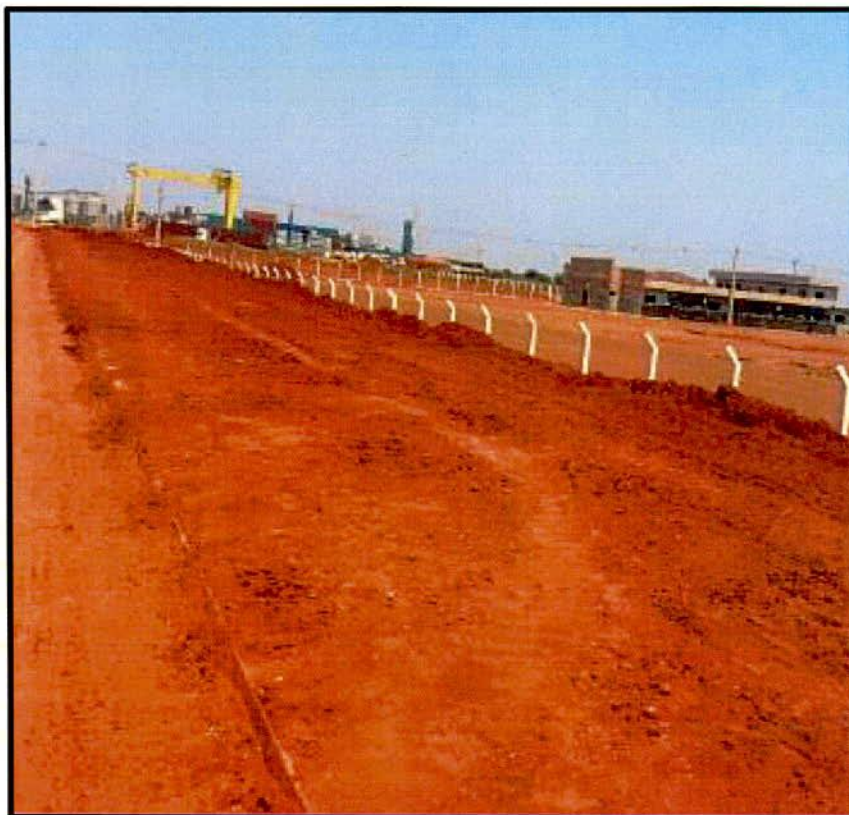
Foto 5 – Aterro e compactação da vala.
