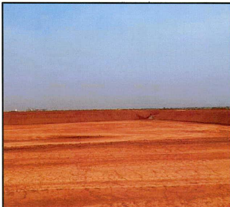
Foto 4 – Lagoa de retenção finalizada.
