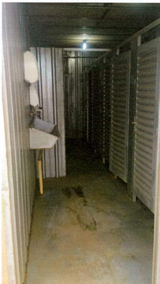
Figura 4. Interior do sanitário
