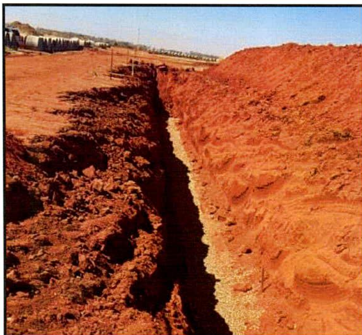
Foto 7 – Abertura de vala.
