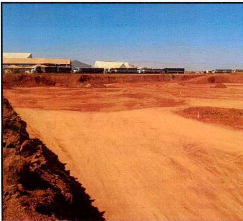
Foto 3 – Abertura de lagoa de retenção.
