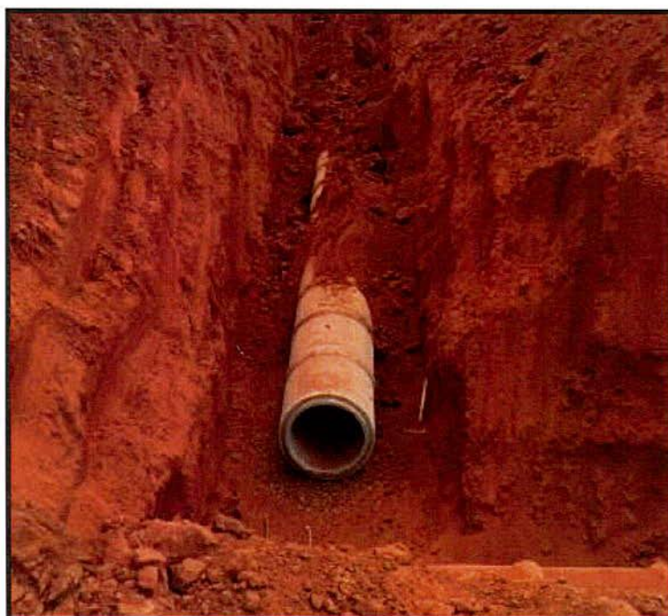
Foto 8 – Implantação de tubulação.
