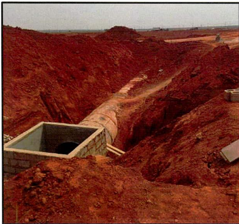
Foto 9 – Implantação de tubulação.
