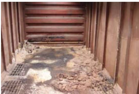
Lavagem interna das paredes do vagão.
