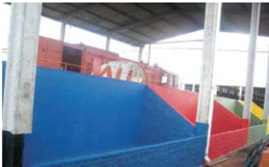
Central de Resíduos Uvaranas
