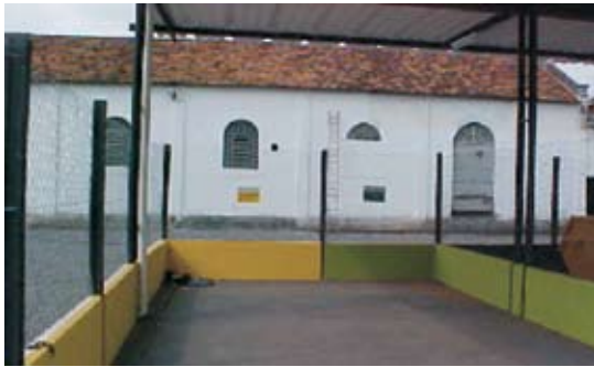
Central de Resíduos Bauru
