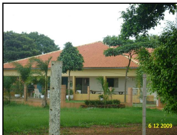
Figura 136 – Casa-sede dos proprietários da Fazenda Estância Paraíso.
