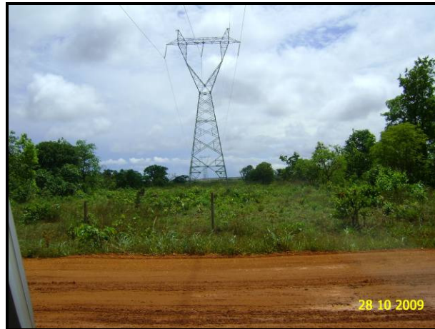
Figura 37 – Rede de alta tensão que passa na região em que será instalada a ferrovia.
