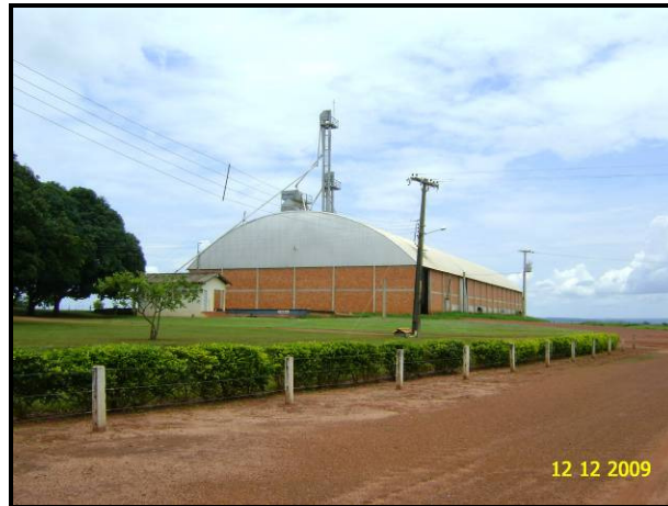
Figura 170 – Estrutura na Fazenda Flórida.
