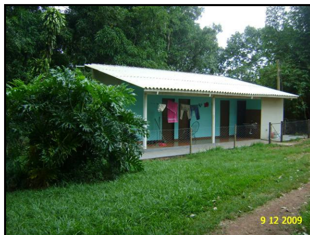
Figura 150 – Casa de funcionário na Fazenda Sperotto.
