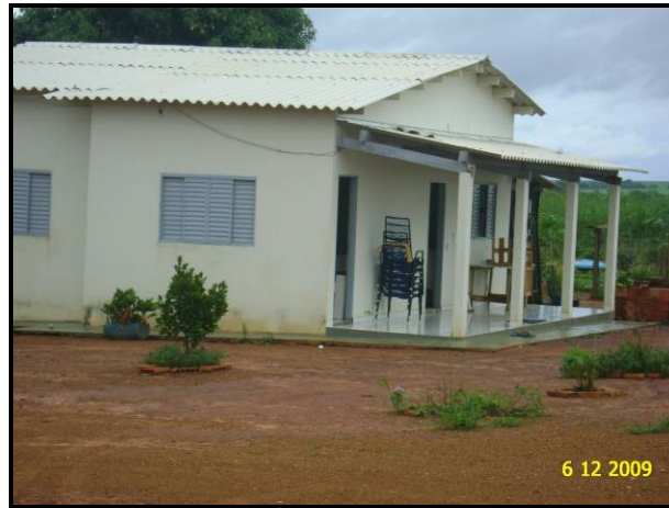
Figura 142 - Casa do administrador da Fazenda Água Limpa.
