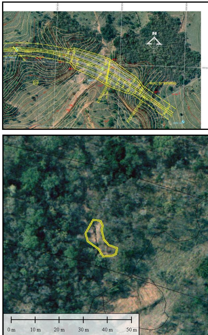
Figura 305 - Imagens da área degradada, localizada na ADA.
