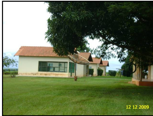
Figura 154 – Casas de funcionários na Fazenda Flórida.
