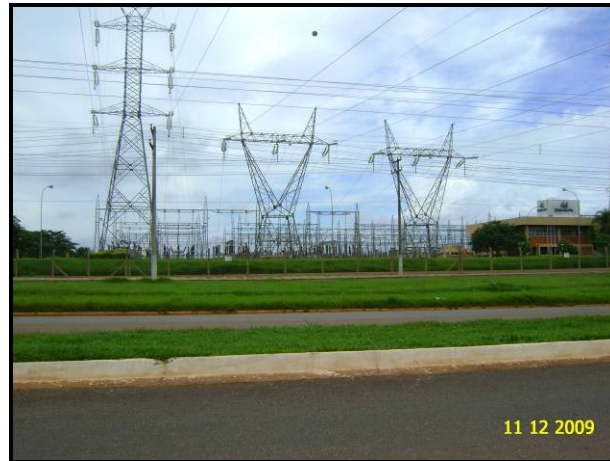
Figura 35 - Unidade da Eletrobrás em Rondonópolis.
