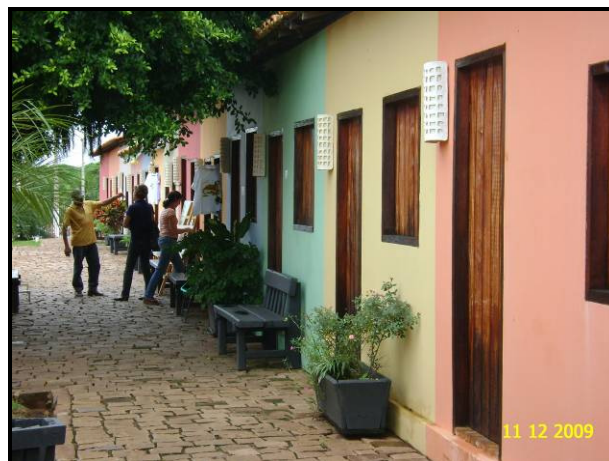
Figura 247 - Complexo arquitetônico denominado Casario.
