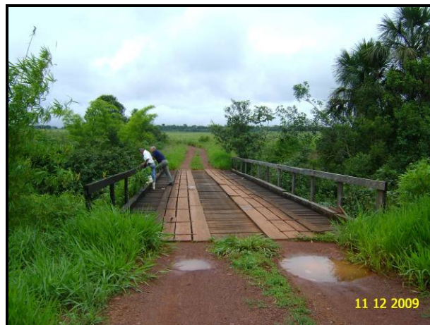
Figura 160 – Ponte sobre rio na Fazenda Nossa Senhora da Guia.
