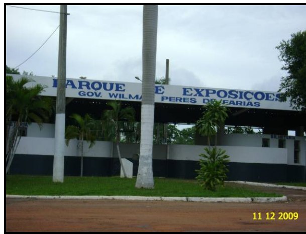
Figura 257 - Fachada do Parque de Exposições.
