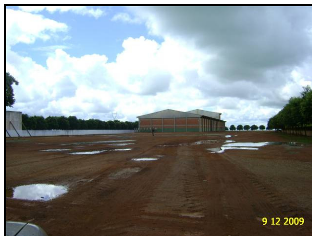
Figura 166 – Estrutura localizada na Agropecuária Cavalca.
