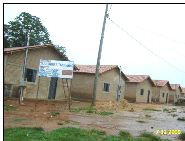
Figura 56 - Casas em fase final de construção do projeto Tijolinho a Tijolinho.
