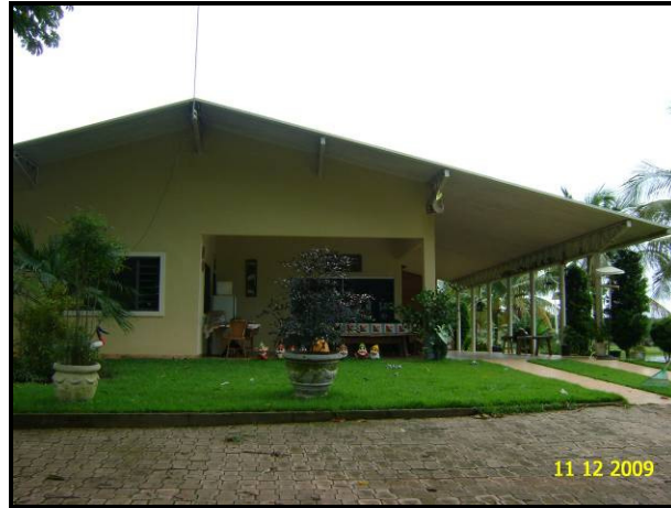
Figura 140 – Casa-sede da Fazenda Nossa Senhora da Guia.
